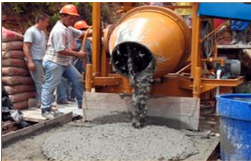
Figura 7. Mezcla de concreto.
