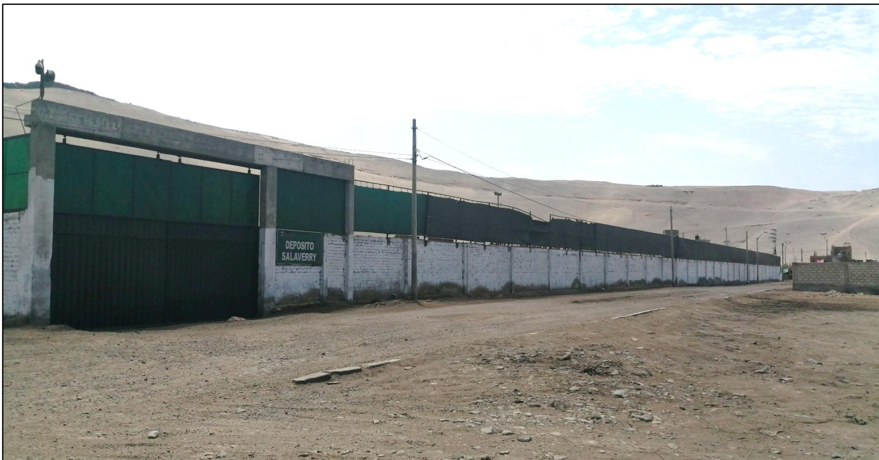
Figura 21. Vista panorámica del cerco perimétrico del almacén Salaverry.
