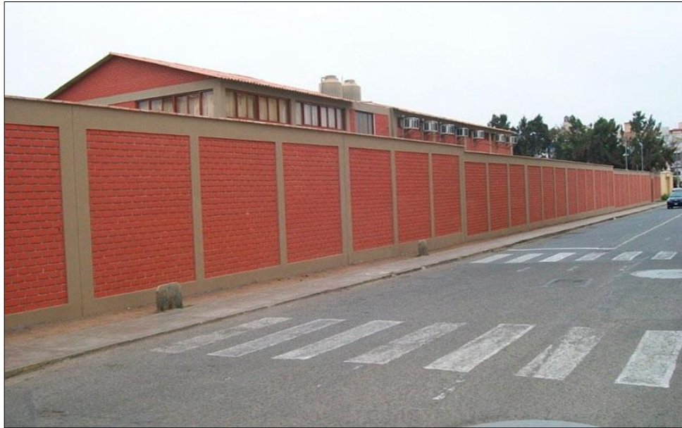
Figura 2. Cerco perimétrico del I.E. San Jose Obrero de Trujillo. Fuente: PHONNI Contratistas Generales S.A.C
