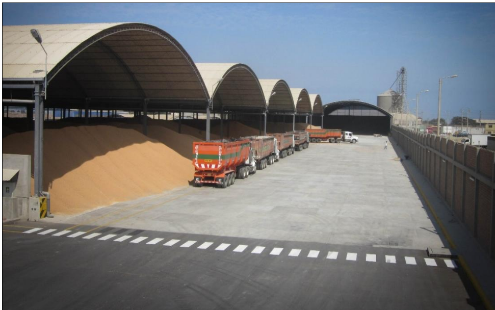
Figura 1. Almacén de Materiales del Grupo TRC.
