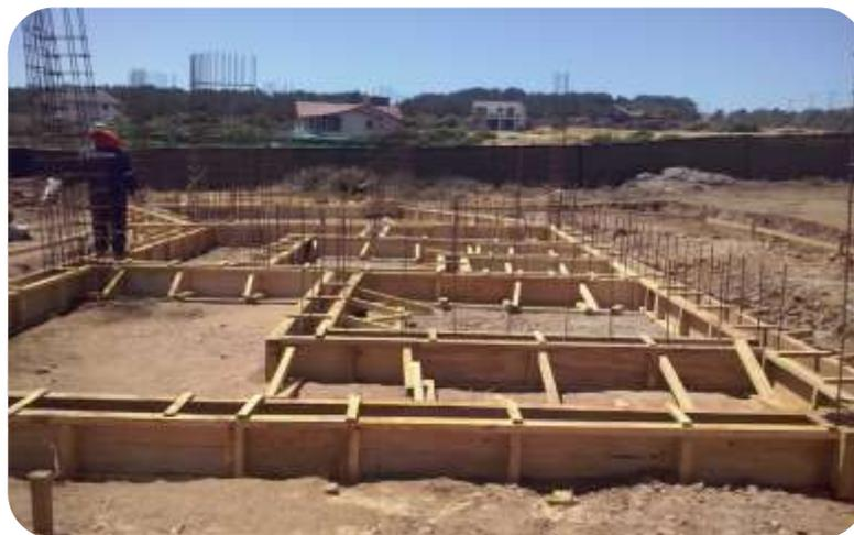
**Figura 6.** Proceso Constructivo de sobrecimiento.
