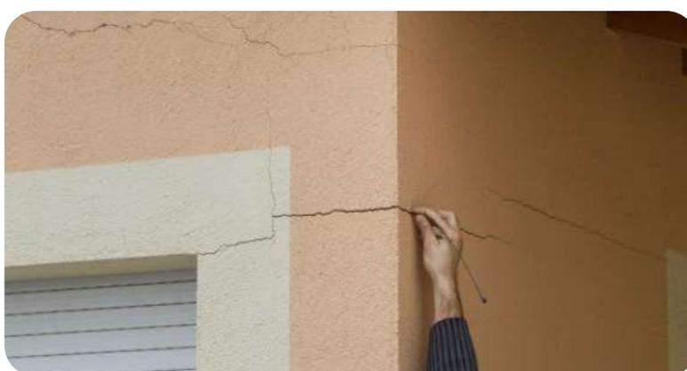
**Figura 19.** Fisura en esquina de fachada.
