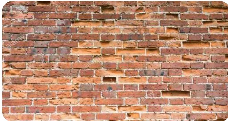
**Figura 16.** Erosión Física.
