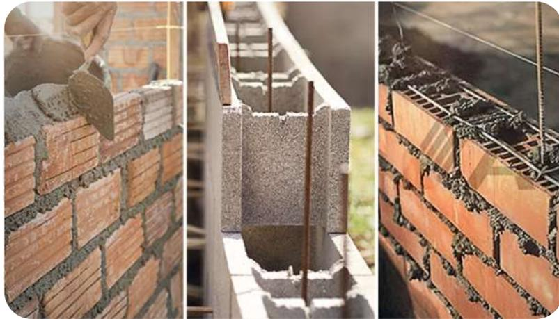
**Figura 4.** Proceso Constructivo, albañilería reforzada.
