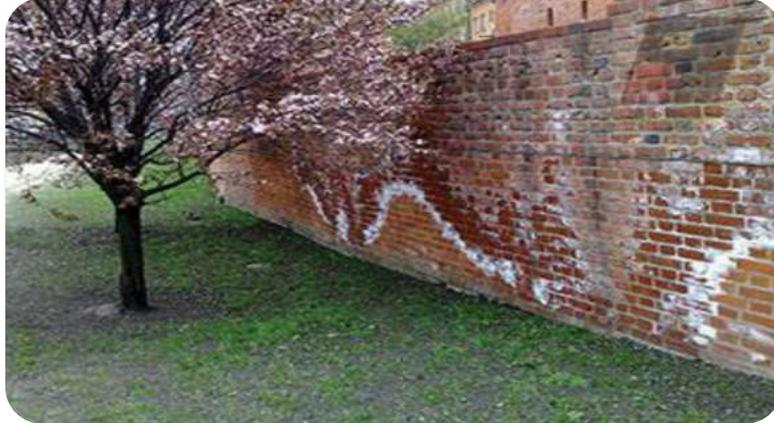
**Figura 21.** Eflorescencia en muro de albañilería.
