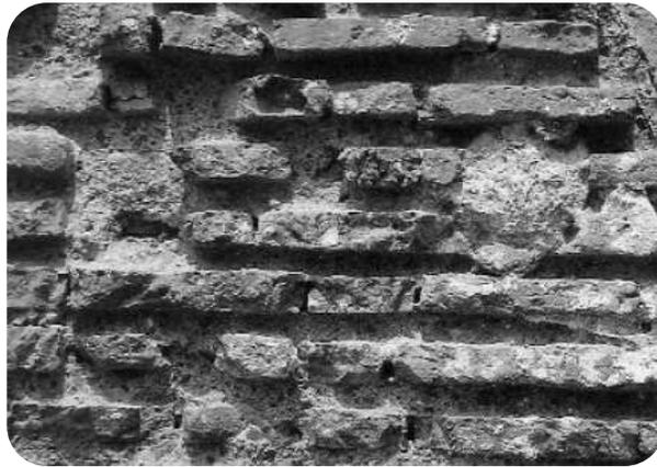
**Figura 17.** Erosión Mecánica producida por las partículas que transporta el viento.
