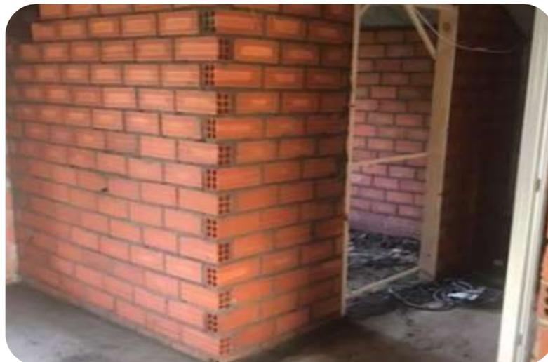
**Figura 2.** Proceso constructivo de albañilería simple.
