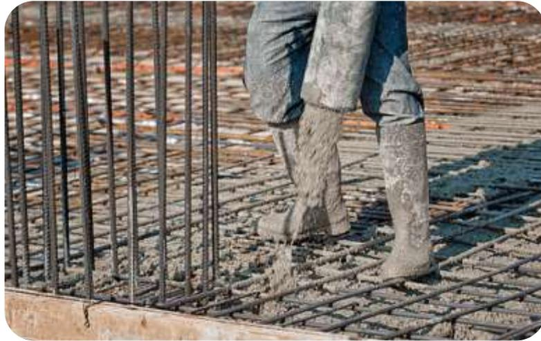
**Figura 13.** Vaciado de Concreto en estructura armada.
