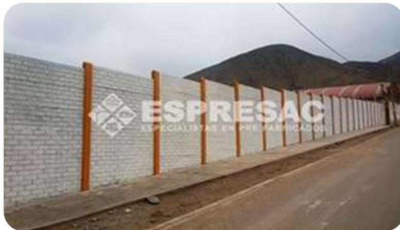
**Figura 11.** Cerco perimétrico – Muro no portante.
