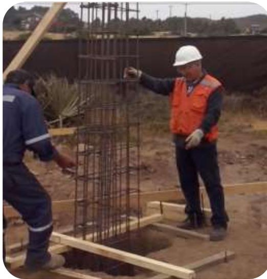
**Figura 7.** Colocación de Columna in situ.
