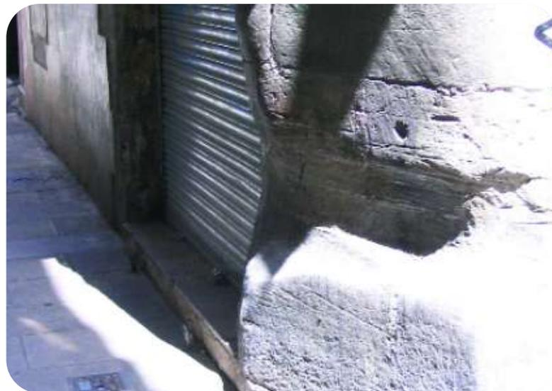
**Figura 18.** Erosión Mecánica producida por el paso de vehículos no móviles que transitan las avenidas.
