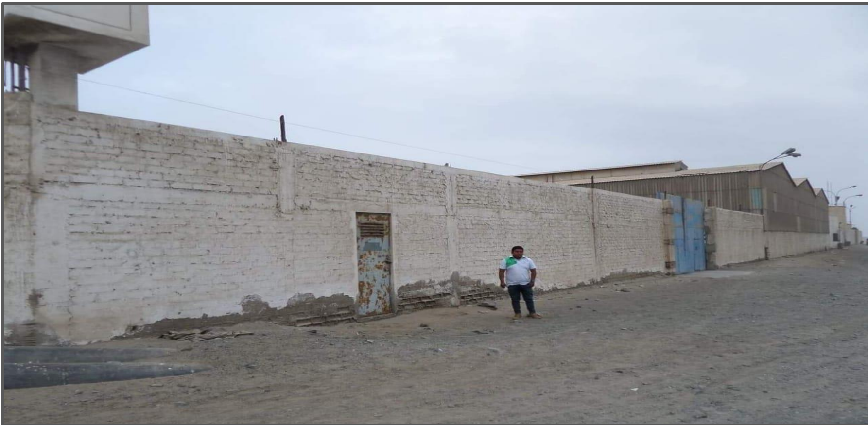
Fotografía 01: Vista Panorámica del exterior del cerco de la envasadora export del distrito de Samanco, provincia del Santa, región Áncash.
