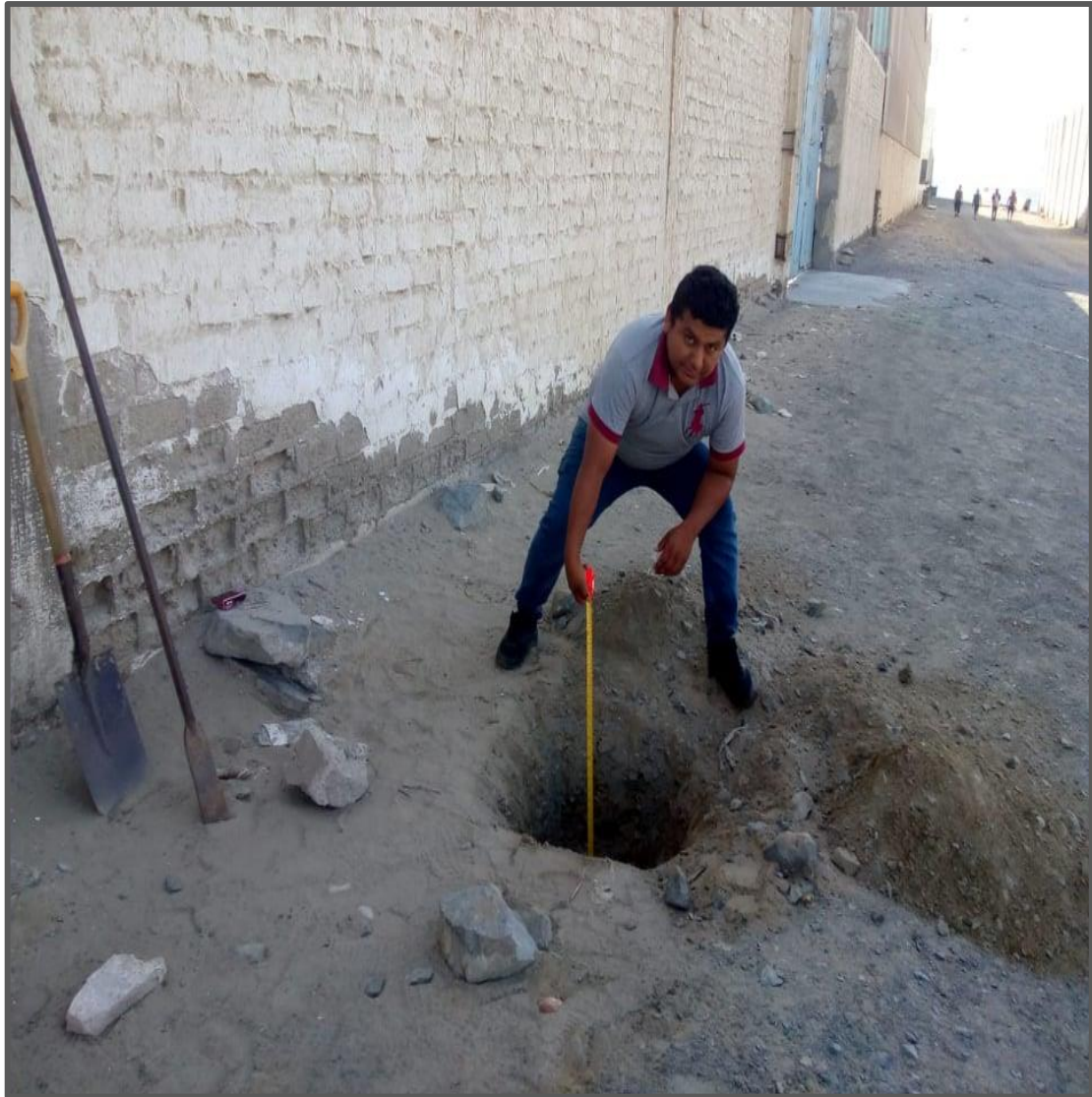
Fotografía 14: Excavación de calicata 1.00 m x 1.00 m.
