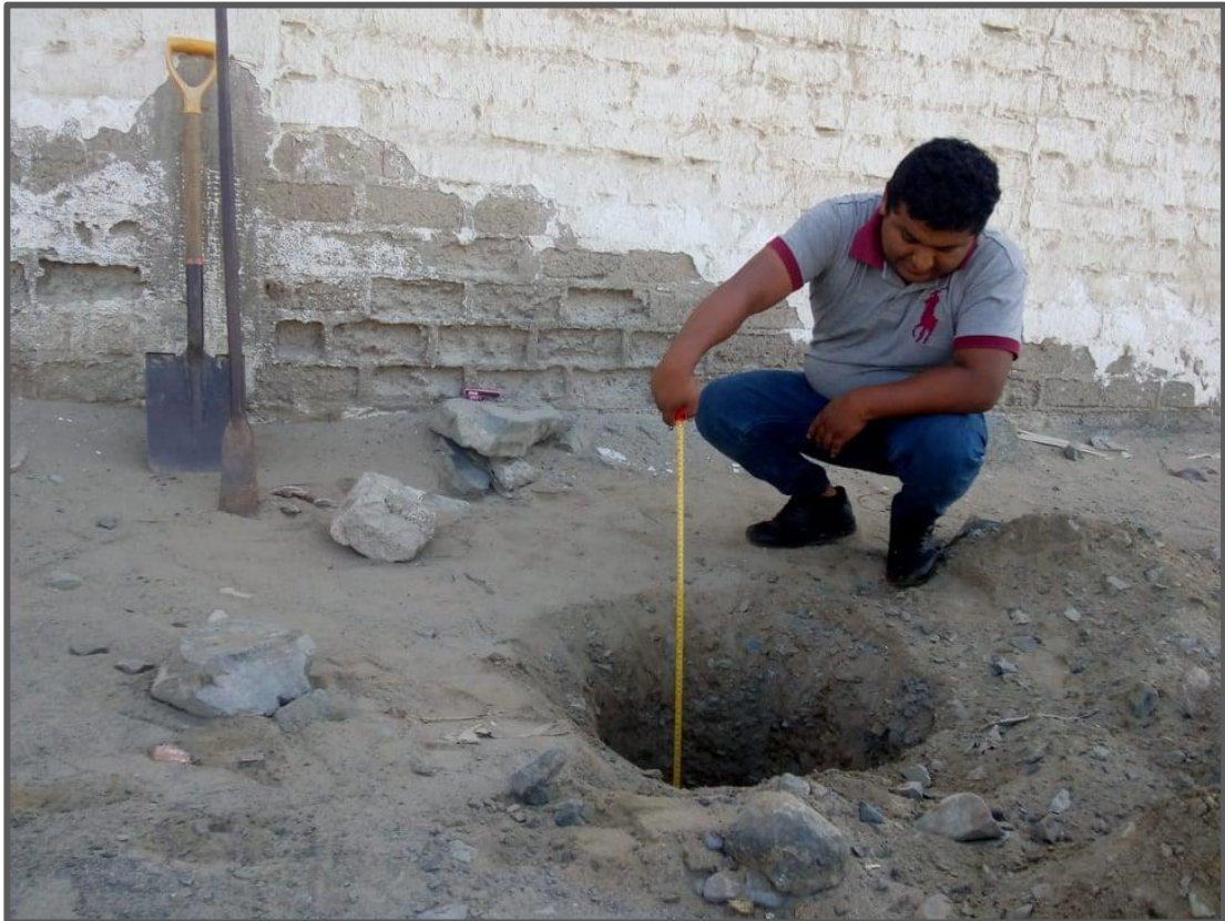
Fotografía 16: Calicata de 1.00 m x 1.00 m ubicado al costado del cerco de la envasadora export.
