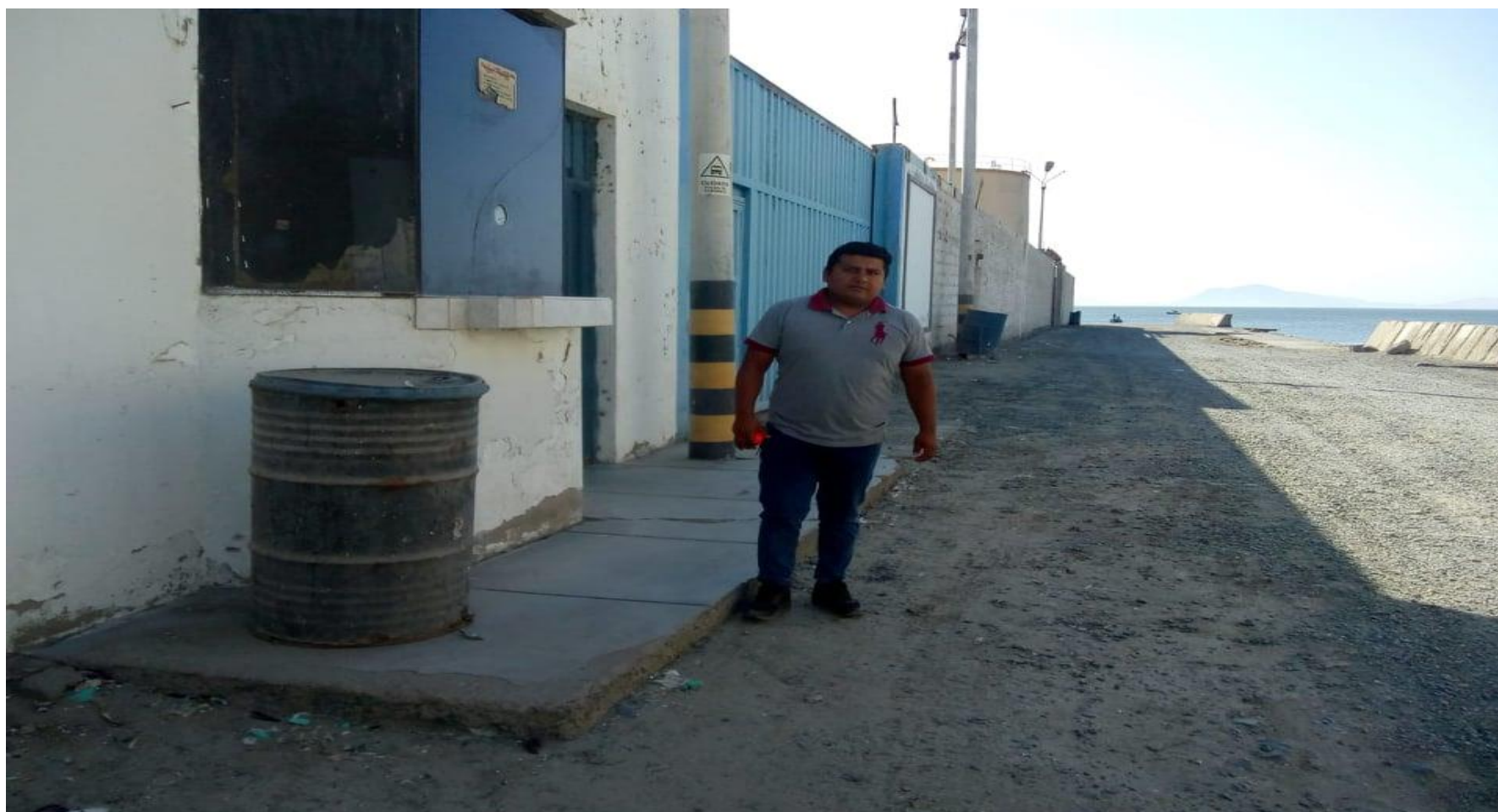
Fotografía 03: Vista del cerco perimétrico exterior eje 2-2 de la envasadora export del distrito de Samanco, provincia del Santa, región Áncash.
