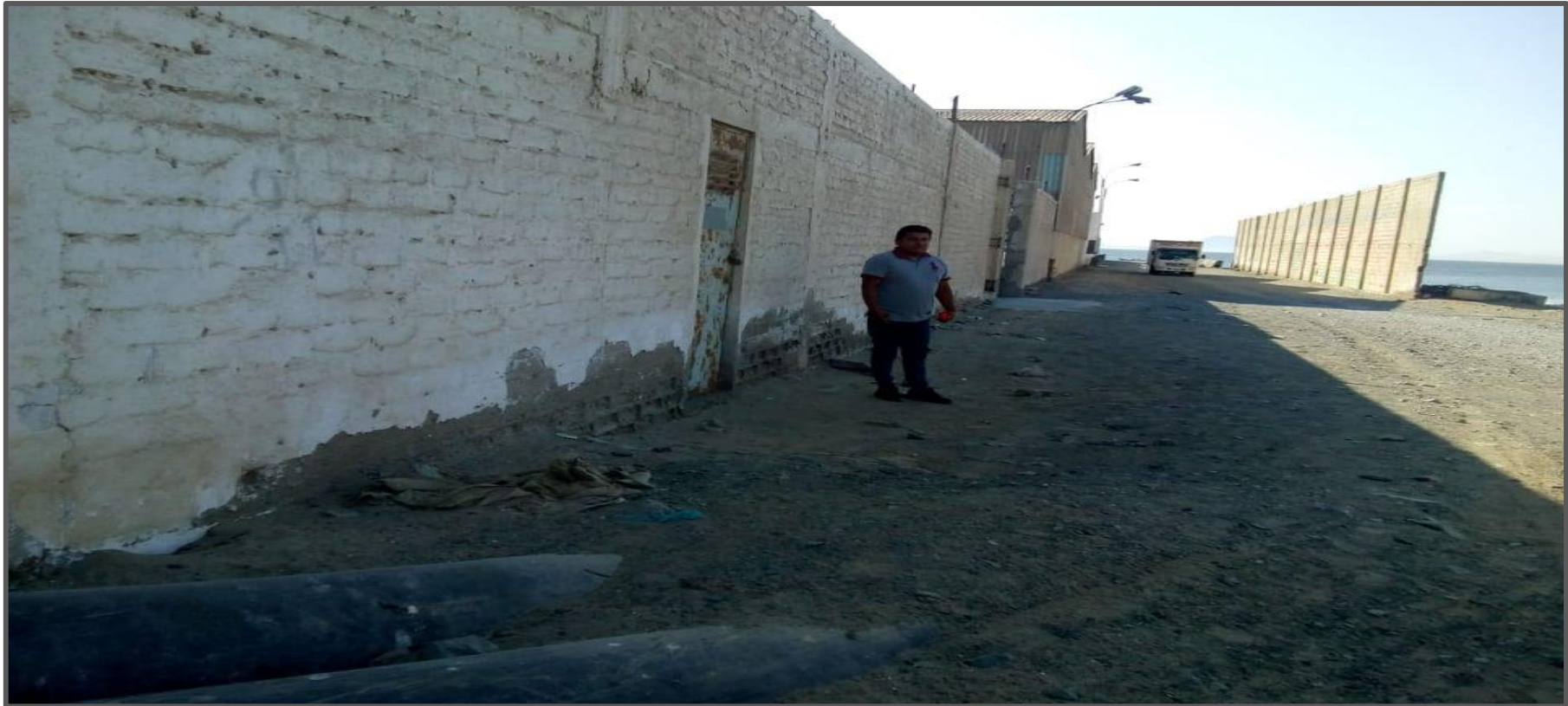
Fotografía 02: Vista del cerco perimétrico exterior eje 1-1 de la envasadora export del distrito de Samanco, provincia del Santa, región Áncash.
