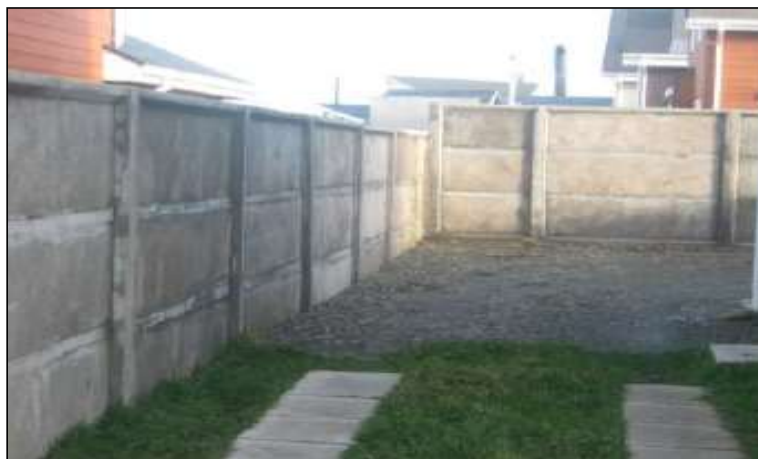
Gráfico 4. Fotografía de cerco de concreto con ladrillo pandereta. (Fuente: Mayorga R. 2010)
