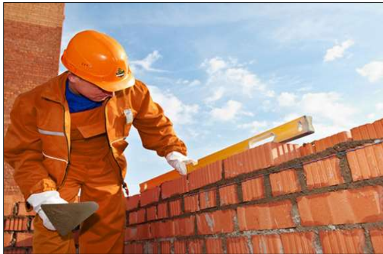
Gráfico 14. Fotografía de construcción de un muro de albañilería. (Fuente: Aplicadores. 2014).
