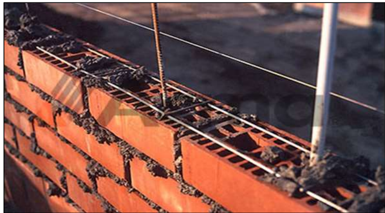
Gráfico 10. Fotografía, Muro reforzado con armadura. (Fuente: chile. Cubica. 2016)
