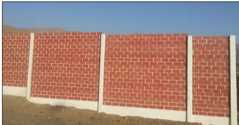
Gráfico 16. Fotografía de construcción de cerco perimétrico. (Fuente: Sipca. 2019).
