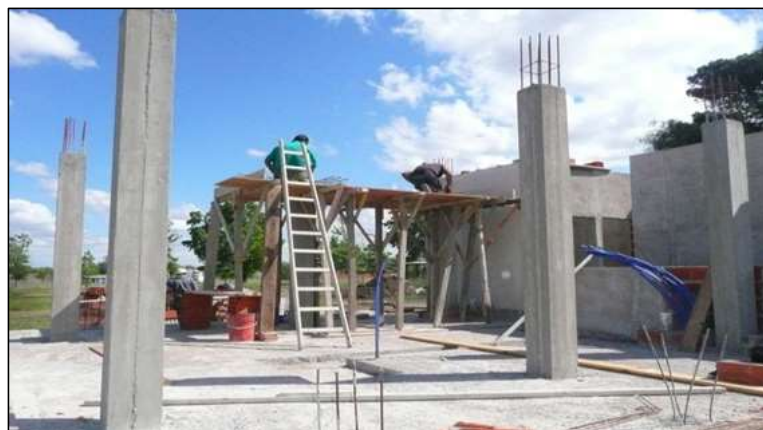
Gráfico 12. Fotografía de columnas de concreto armado. (Fuente: fmreflejos. 2010).
