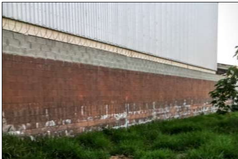
Gráfico 19. Fotografía de lesiones químicas por parte de sales y húmeda.
