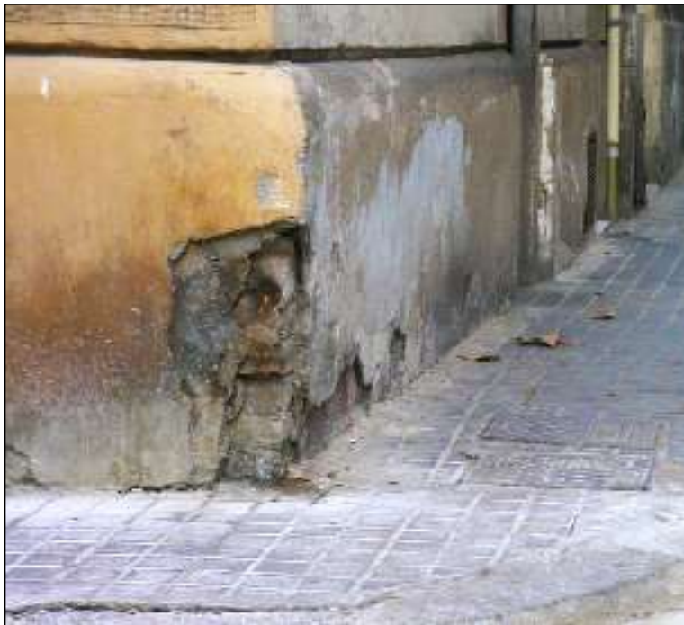
Gráfico 20. Perdida de material externo, debido al paso de personas y animales adicionado a la humedad atmosférica. (Fuente: Enciclopedia Broto. 2004).
