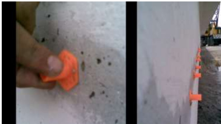
Gráfico 23. Fotografía de colocación de los puertos de inyección. (Fuente: Chema. 2019).
