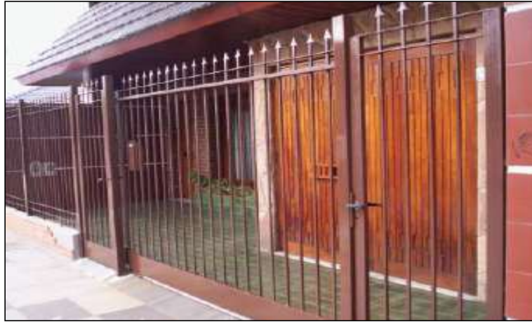
Gráfico 2. Fotografía de Cerco perimétrico con perfil de acero. (Fuente: Mayorga R. 2010)
