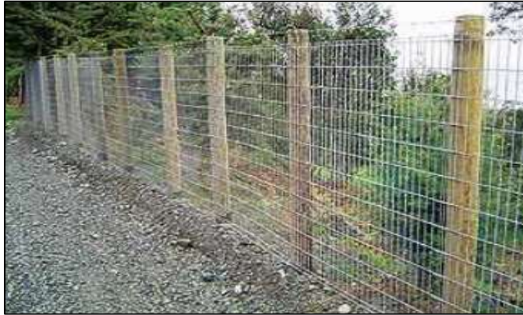
Gráfico 5. Fotografía, Cerco de madera y malla de acero. (Fuente: Mayorga R. 2010)
