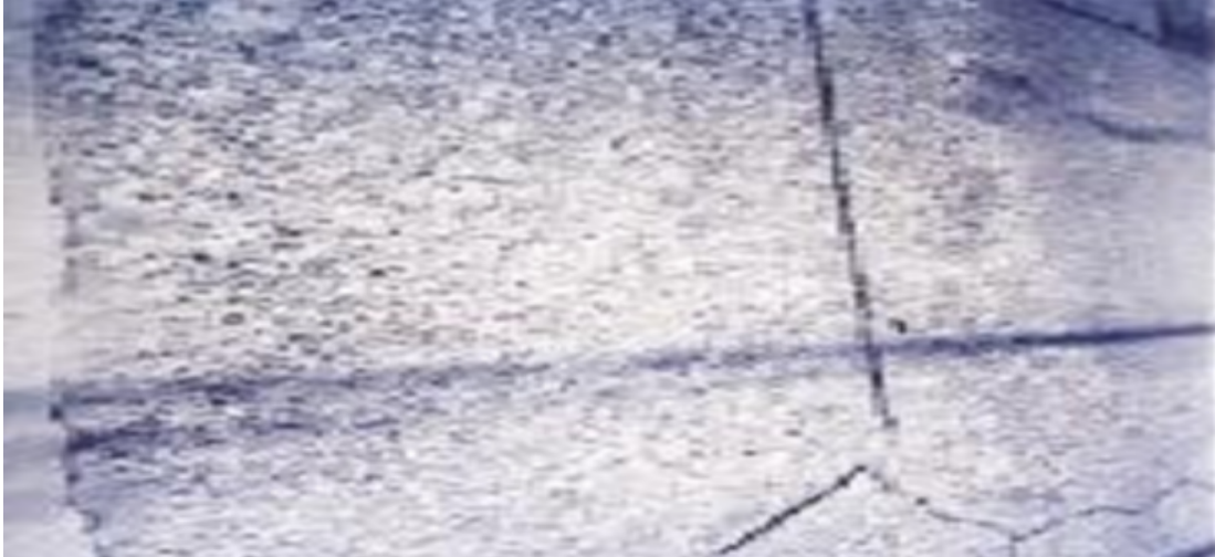
Figura 2.11: Desintegración. Fuente:(Rebolledo Valdivia, 2010).
