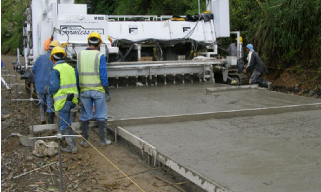
Figura 2.3: Ejecución de pavimento rígido. Fuente:(Andres Sotil, 2010).
