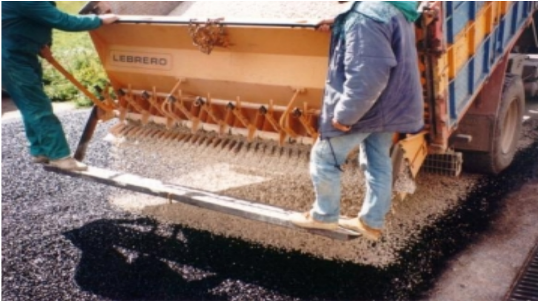
Figura 2.1: Ejecución del tratamiento superficial, pavimento flexible.
