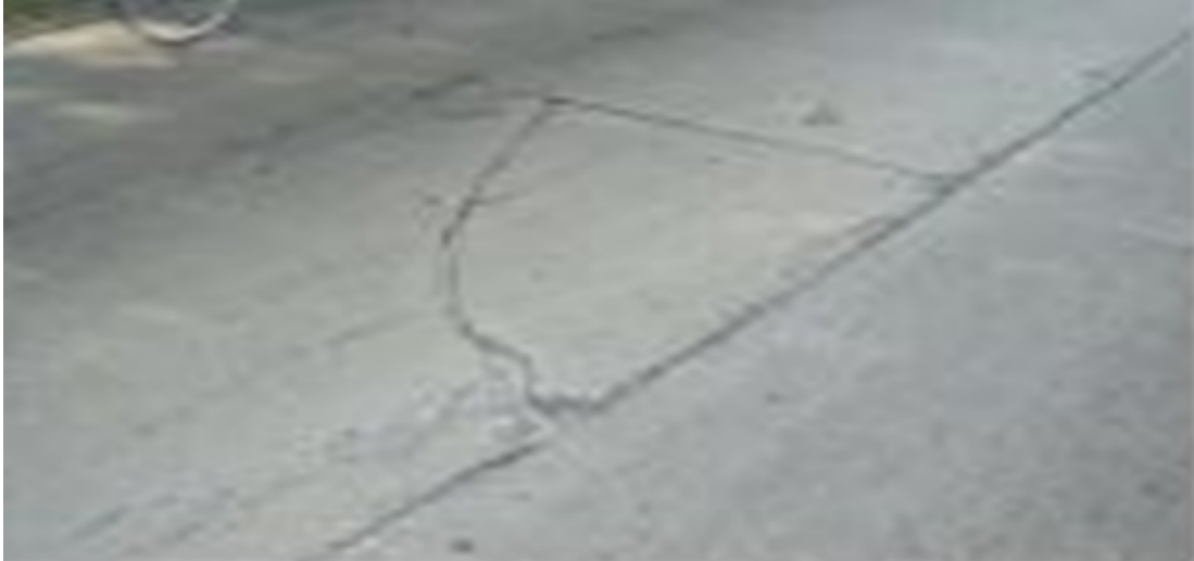
Figura 2.7: Grietas de Esquina. Fuente:(Rebolledo Valdivia, 2010).
