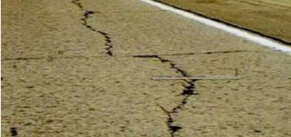
Figura 2.8: Grietas Longitudinales.
