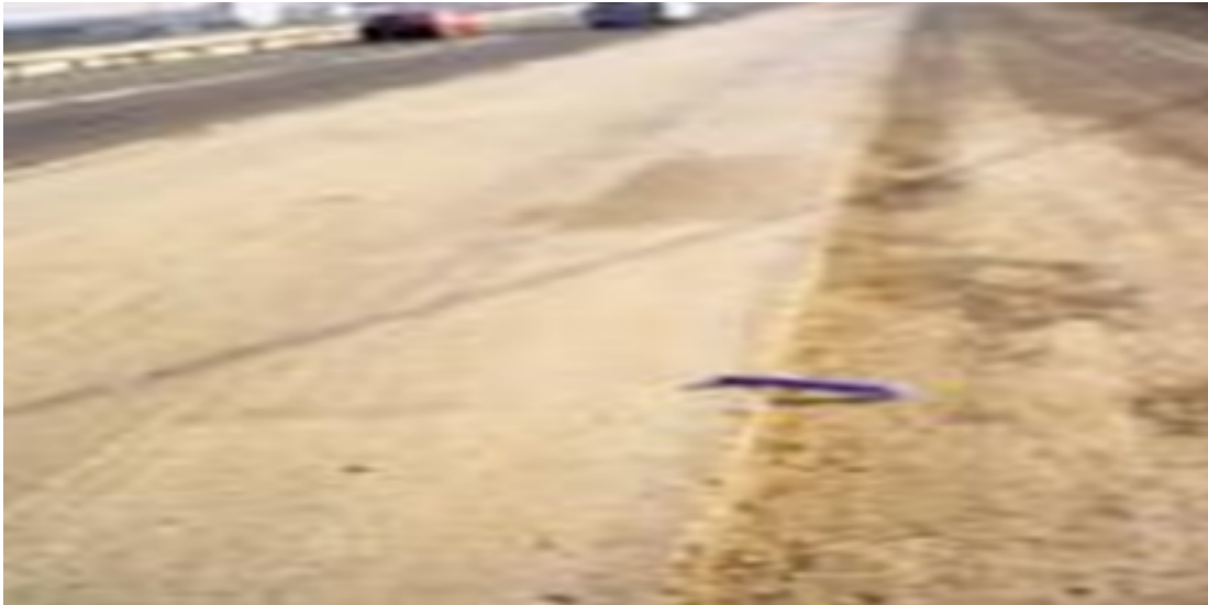
Figura 2.15: Descenso de la berma. Fuente:(Rebolledo Valdivia, 2010).
