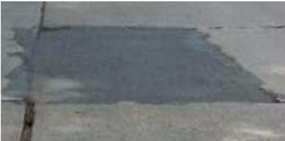
Figura 2.17: Parches deteriorados.
