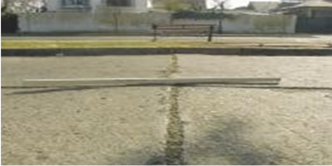
Figura 2.13: Levantamiento localizado.
