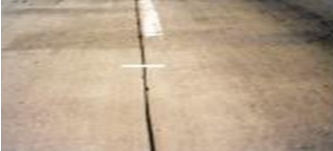
Figura 2.6: Juntas longitudinal. Fuente:(Rebolledo Valdivia, 2010).
