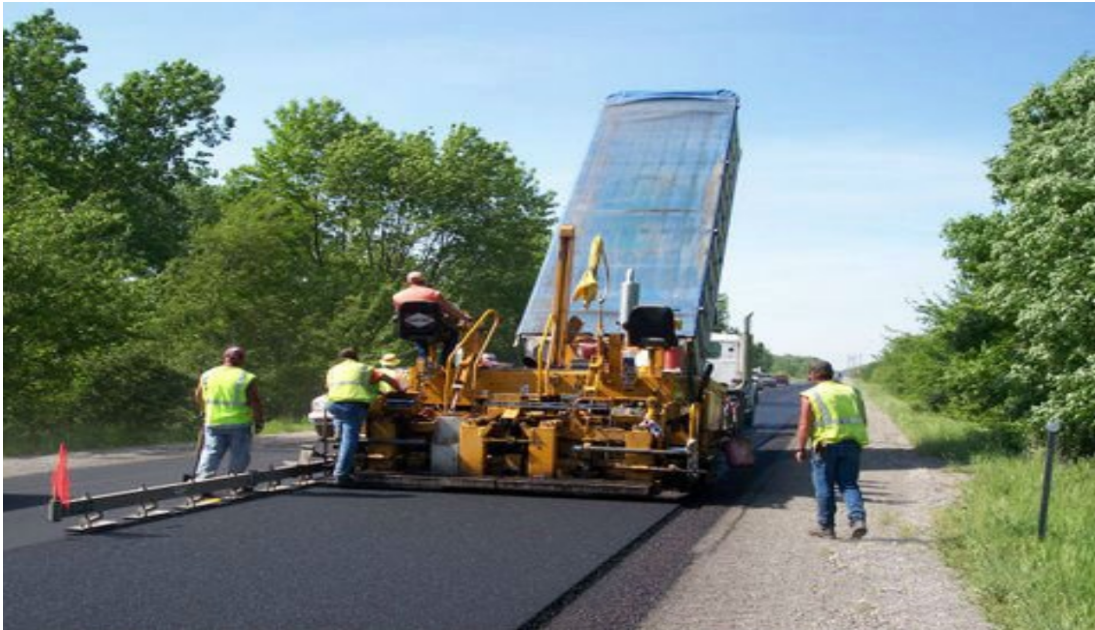
Figura 2.2: Colocación de concreto asfáltico, pavimento flexible. Fuente:(Andres Sotil, 2010).
