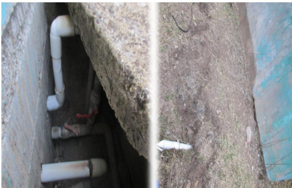
Figura 5.2: Caja de válvulas y sistema de purga del reservorio.
