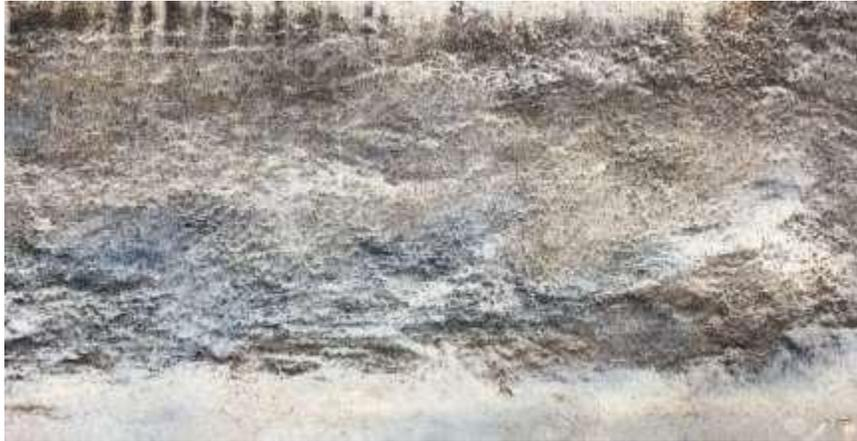
**Figura 17:** Erosión del Revestimiento.
