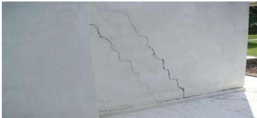
**Figura 18:** Fisuras presentes en un Muro.
