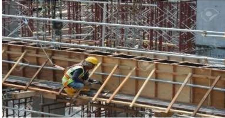
**Figura 7:** Encofrado de Vigas.
