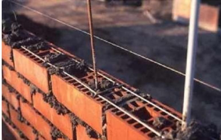
**Figura 3:** Muro de Albañilería Armada.
