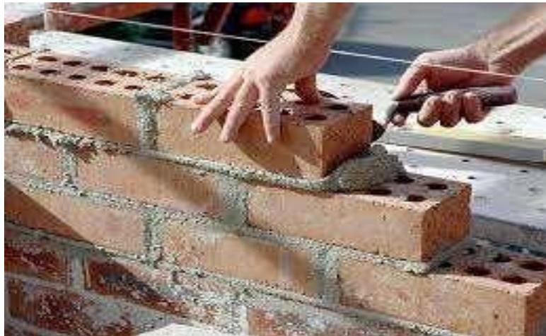
*Figura 2:* Muro de Albañilería Simple.
