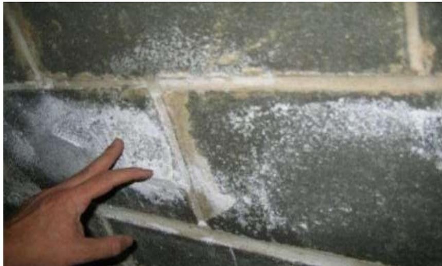
**Figura 21:** Eflorescencia en un Muro.
