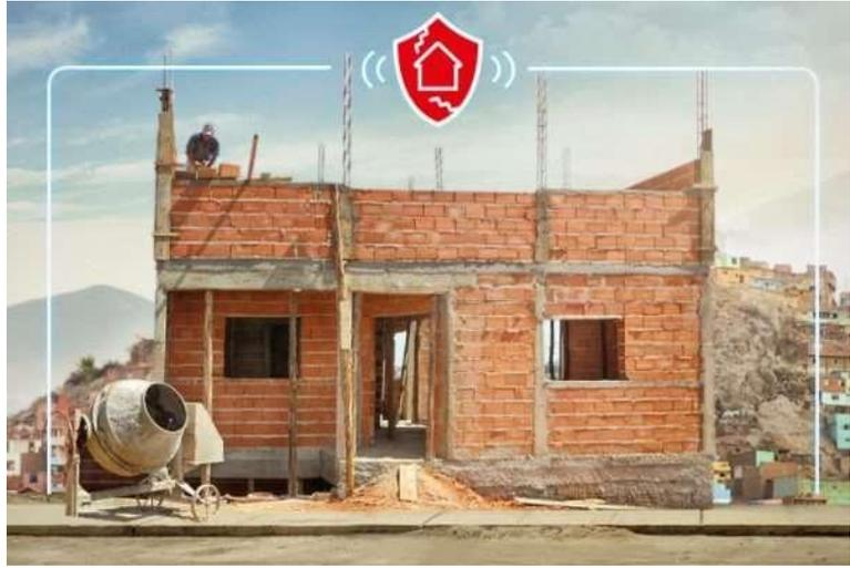
**Figura 4:** Muro de Albañilería Confinada.
