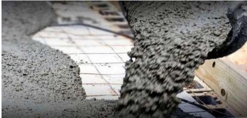
**Figura 13:** Vaceado de Concreto premezclado.
