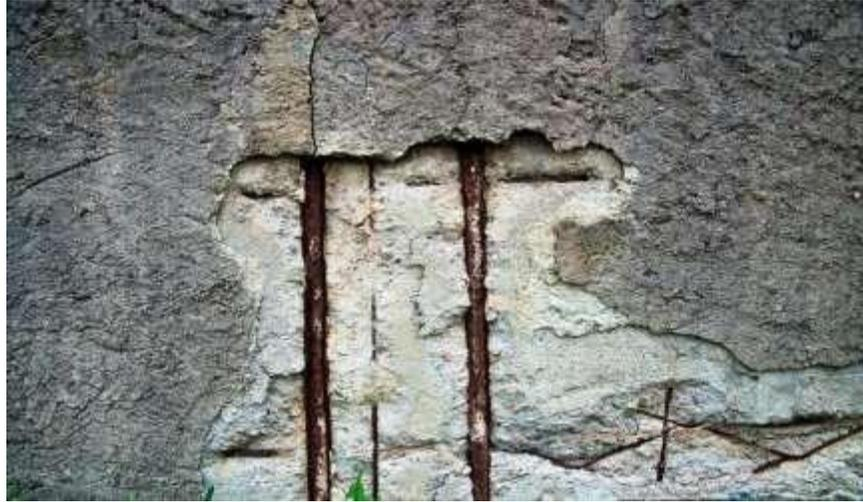
**Figura 20:** Corrosión del acero de refuerzo.
