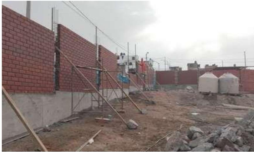
**Figura 25:** Construcción de un Cerco.
