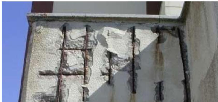
**Figura 22:** Desprendimiento del Revestimiento en un Muro.
