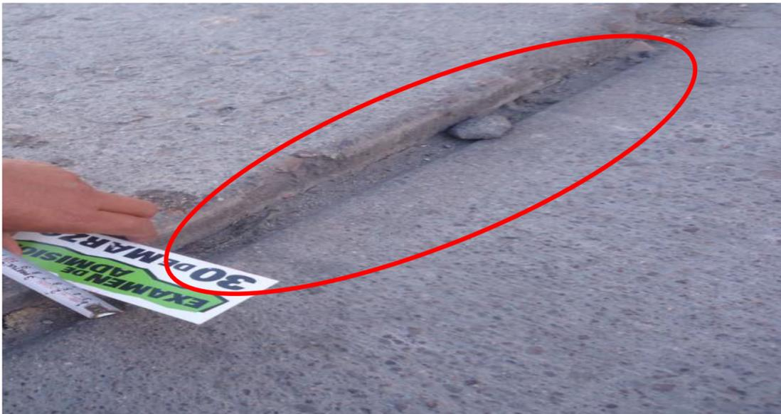
Figura 2.5: Presencia de escala en Pavimento Rígido.
