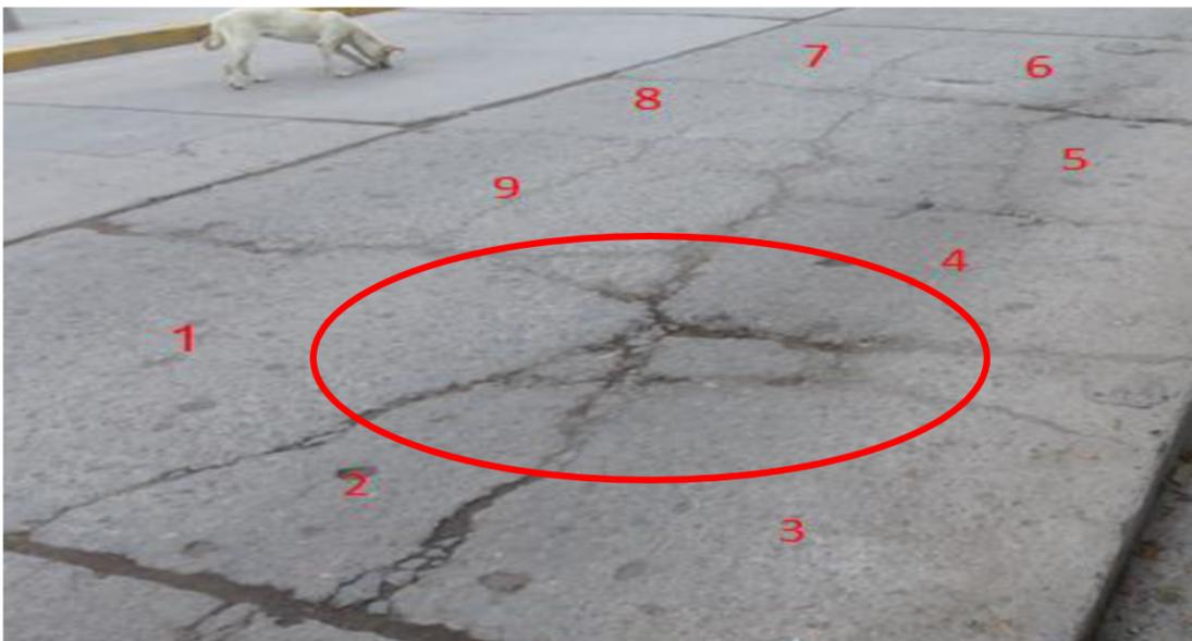
Figura 2.4: Presencia de Losa dividida en Pavimento Rígido.
