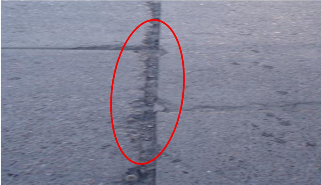
Figura 2.6: Presencia de daño de la junta en Pavimento Rígido.
