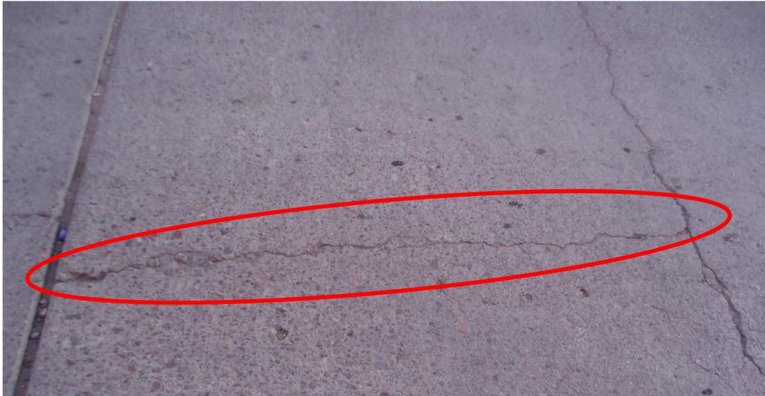
Figura 2.7: Presencia de Grietas lineales en Pavimento Rígido.
