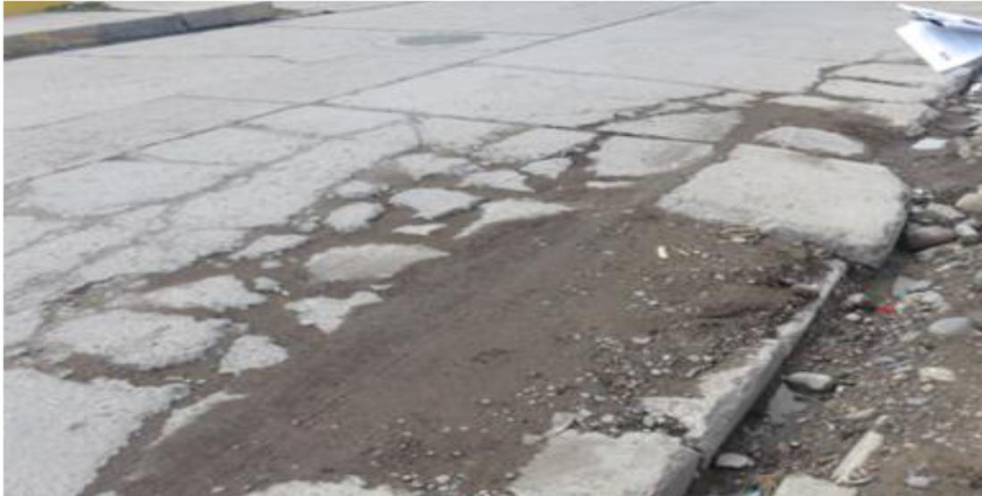
Figura 2.10: Presencia de Punzonamiento en Pavimento Rígido.
