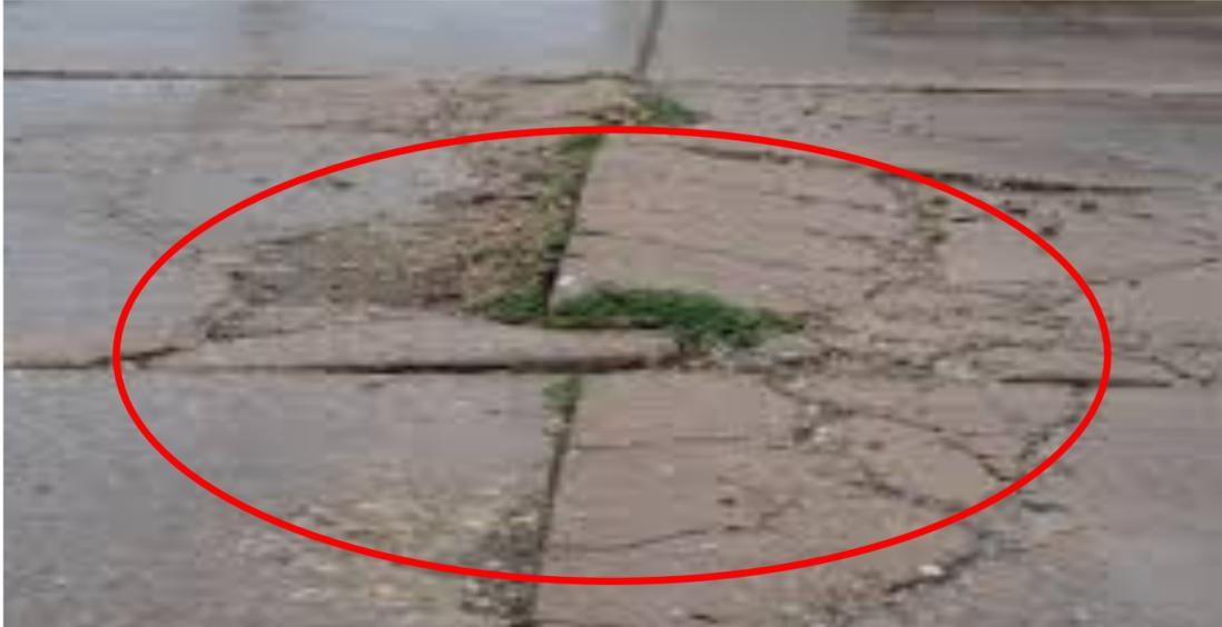
Figura 2.2: Presencia de Blowup-Buckling en Pavimento Rígido.
