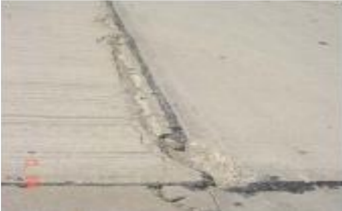
Figura 2.3: Junta saltada del pavimento rígido.
