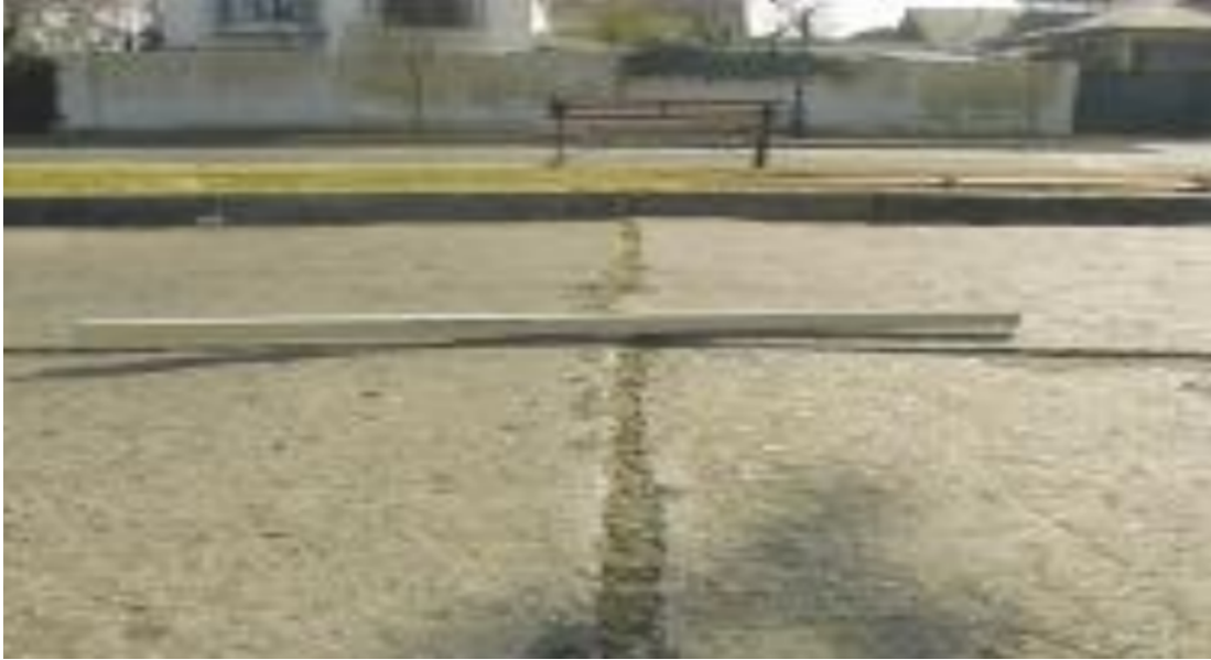
Figura 2.11: Levantamientos localizados del pavimento rígido.
