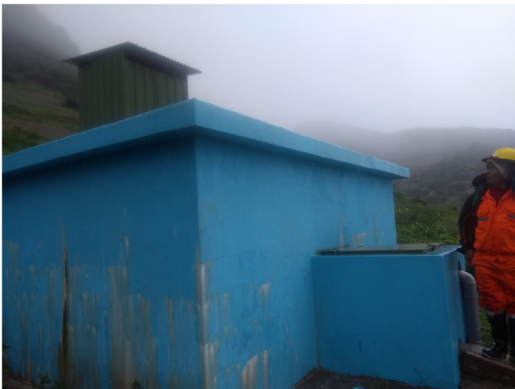
Figura 2.15: Presidente del JASS supervisando un Reservorio. Fuente: Elaboración propia.
