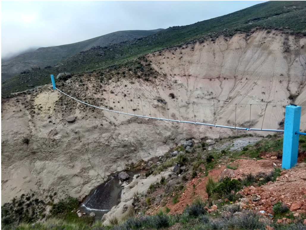
Figura 5.6: Vista aérea de un cruce aéreo. Fuente: Elaboración propia.
