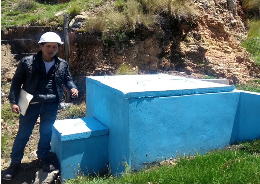
Fotografía 1: Vista frontal de la Captación Sacaramayo
