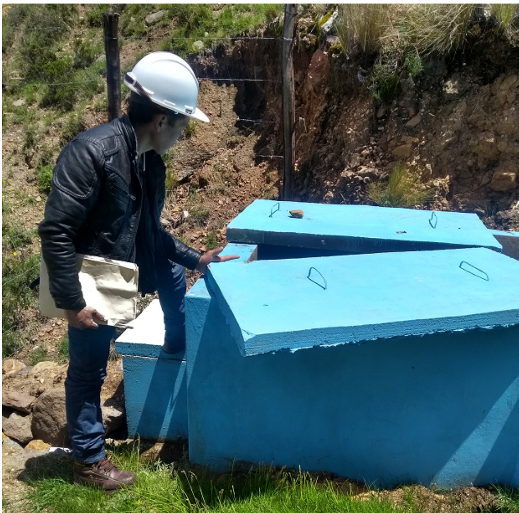
Figura 5.3: Cámara de captación.
