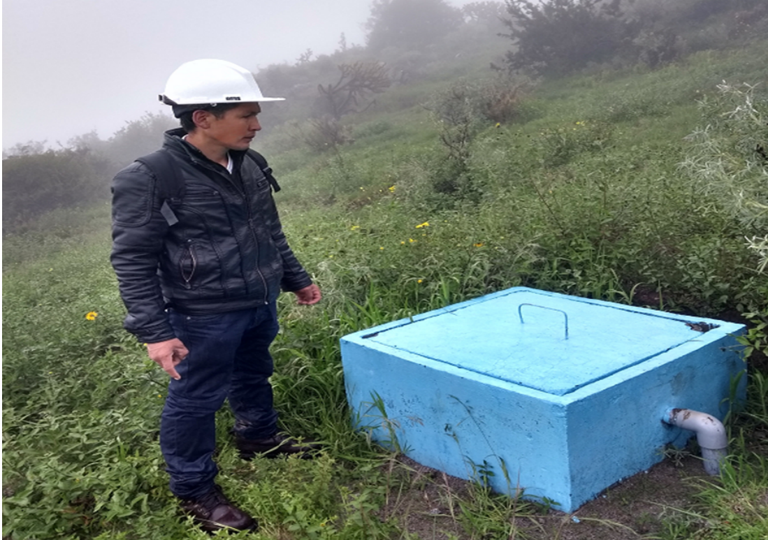
Fotografía 5: Cámara rompe presión tipo 6.
