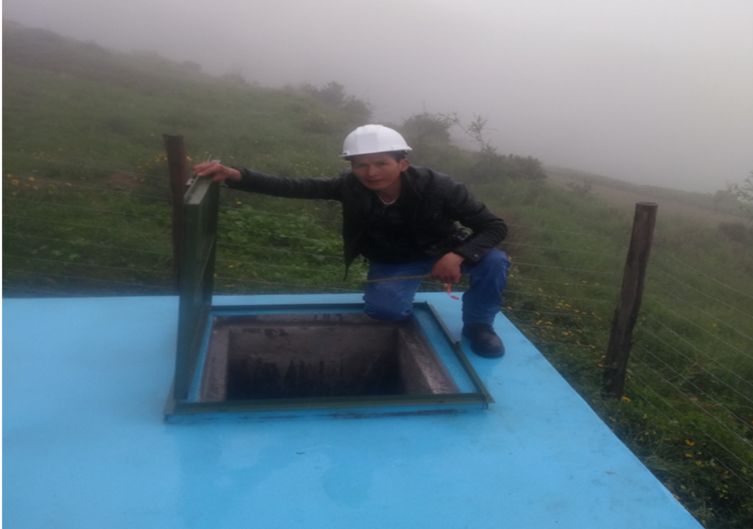
Fotografía 11: Tapa sanitaria del Reservorio.
