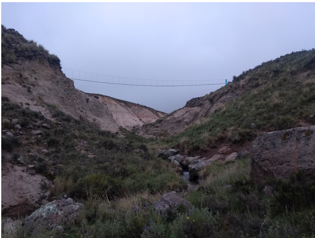
Figura 5.4: Vista lateral de un cruce aéreo. Fuente: Elaboración propia.
