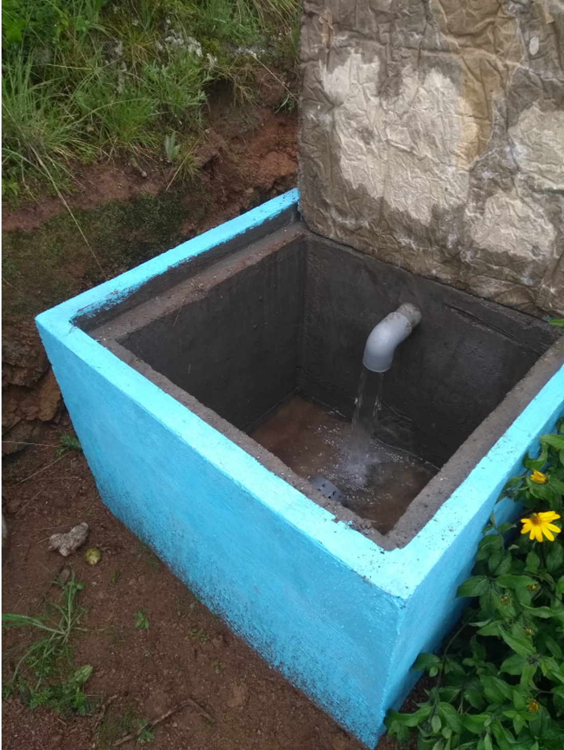
Figura 2.21: Vista interna de un CRP - 6. Fuente: Elaboración propia.
