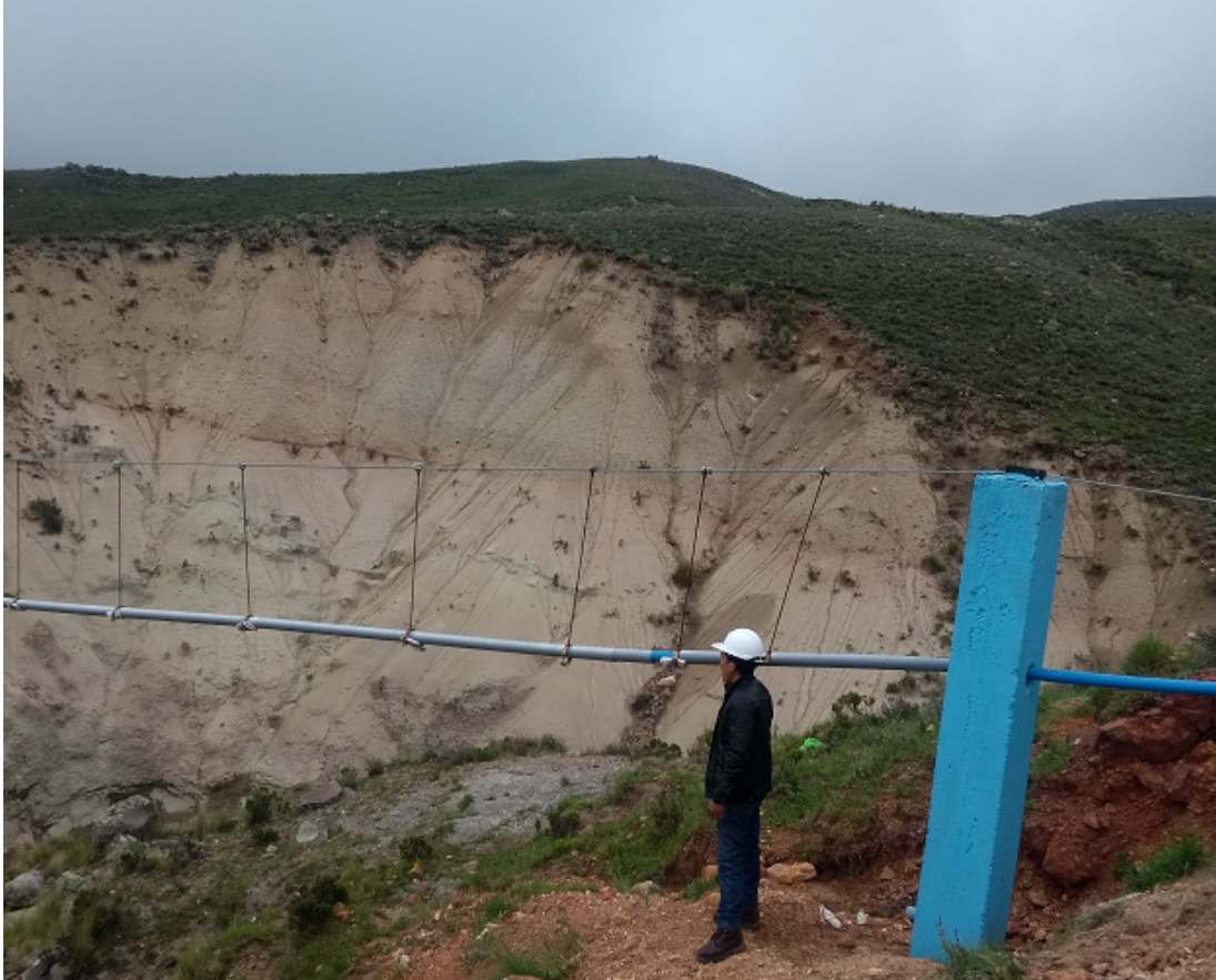
Figura 2.12: Vista lateral de un cruce aéreo. Fuente: Elaboración propia.
