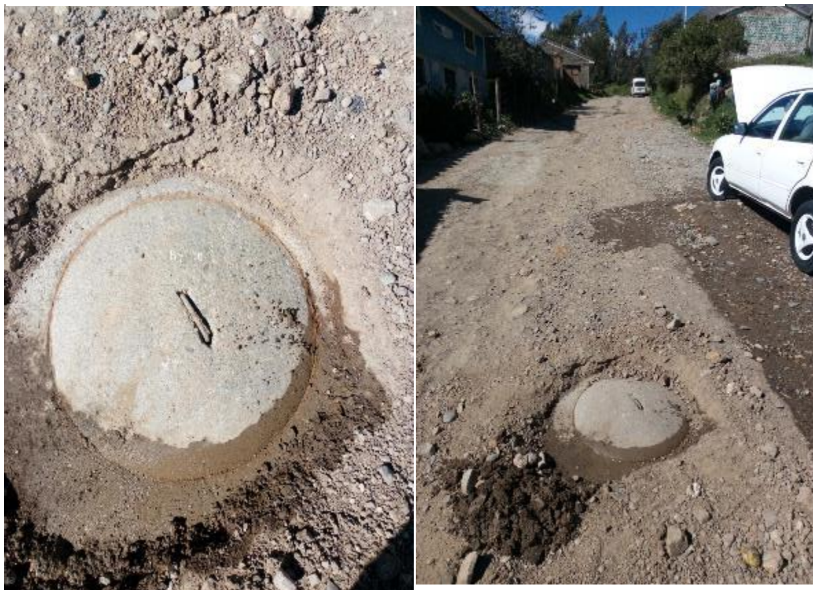
Fotografía 34. Sistema de desagüe – Buzones N°11
