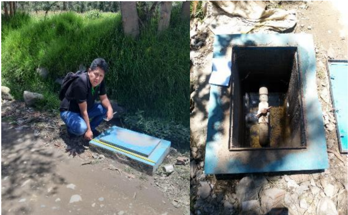
Fotografía 21. Sistema de Agua potable – Caja de Válvulas N° 02
