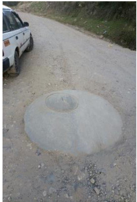
Fotografía 52. Sistema de desagüe – Buzones N° 29
