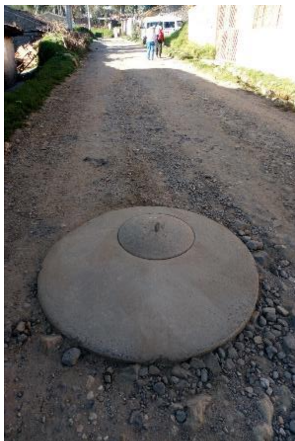
Fotografía 44. Sistema de desagüe – Buzones N°21
