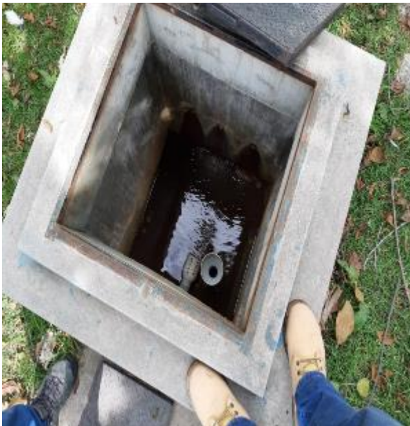
Fotografía 6. Sistema de Agua potable – Captación N° 03 (Parte Interna)
