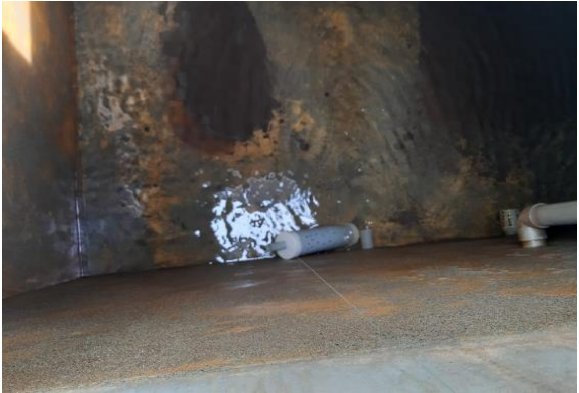
Fotografía 14. Sistema de Agua potable – Reservorio N° 01 (Parte Interna)
