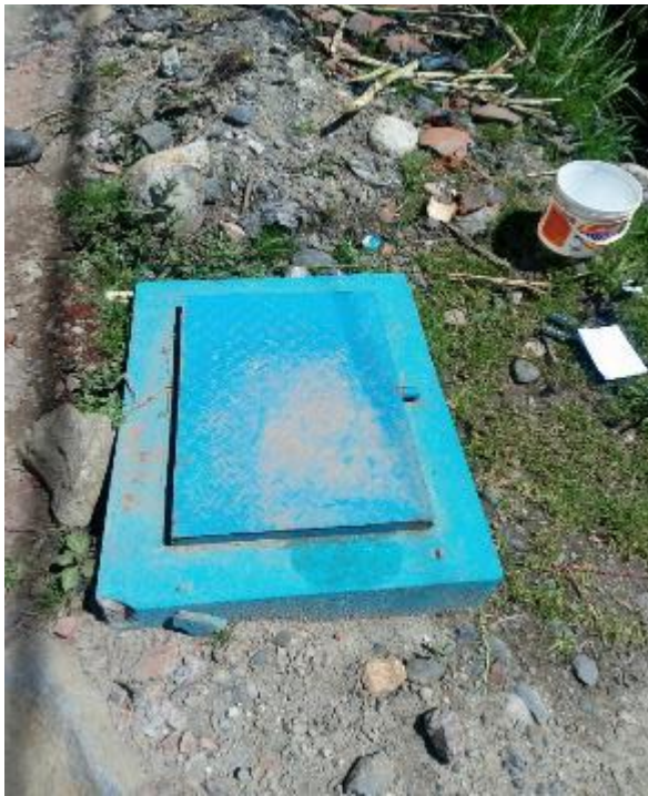
Fotografía 23. Sistema de Agua potable – Caja de Válvulas N° 04
