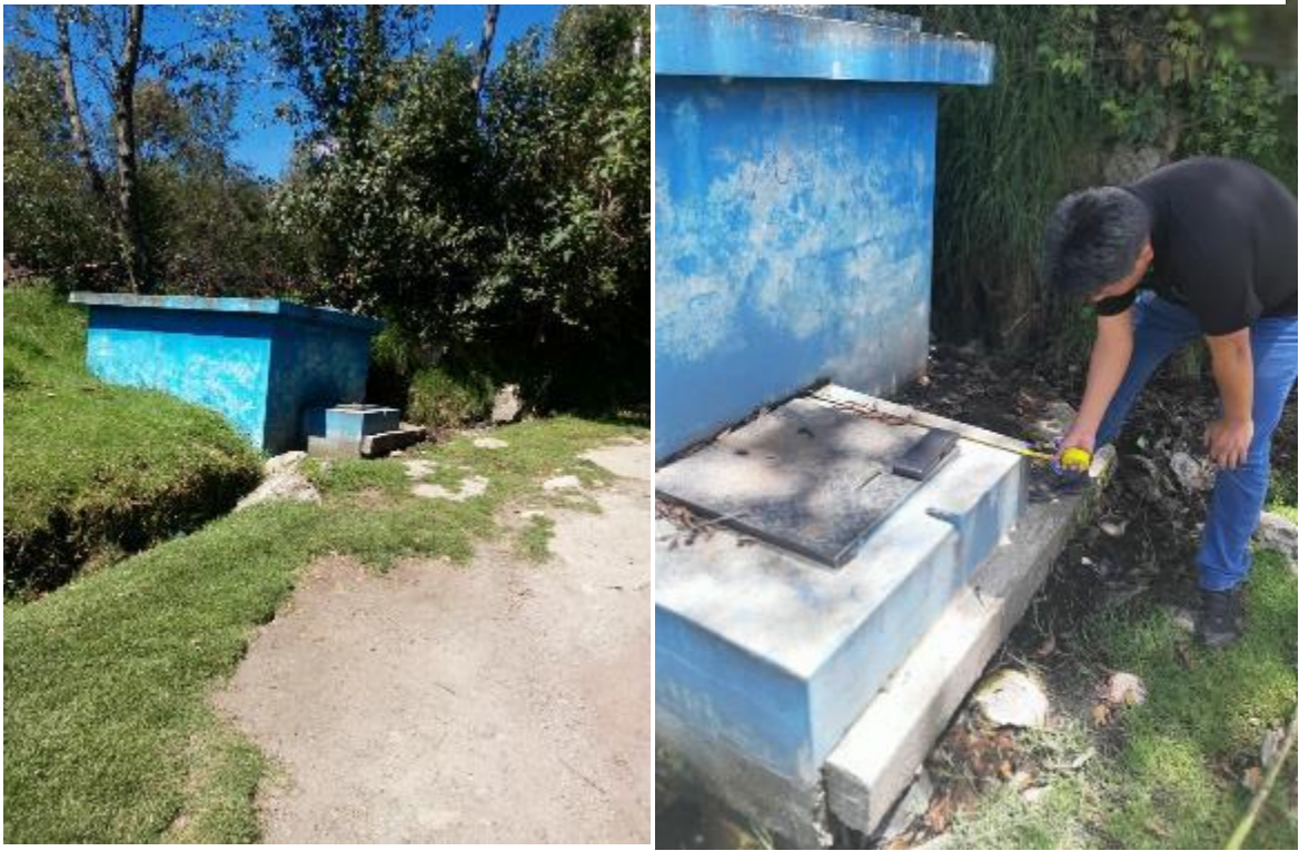
Fotografía 20. Sistema de Agua potable – Caja de Válvulas N° 01
