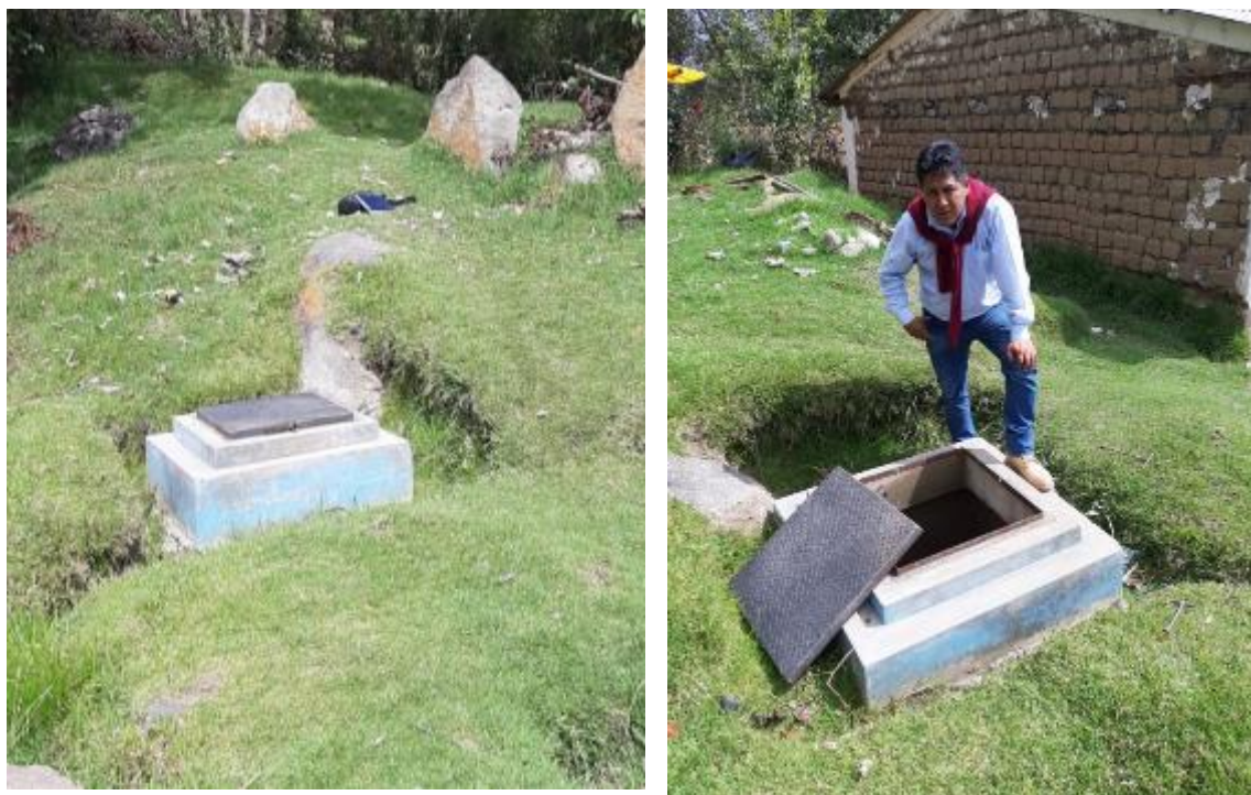
Fotografía 12. : Sistema de Agua potable – cámara de reunión del reservorio N° 01
