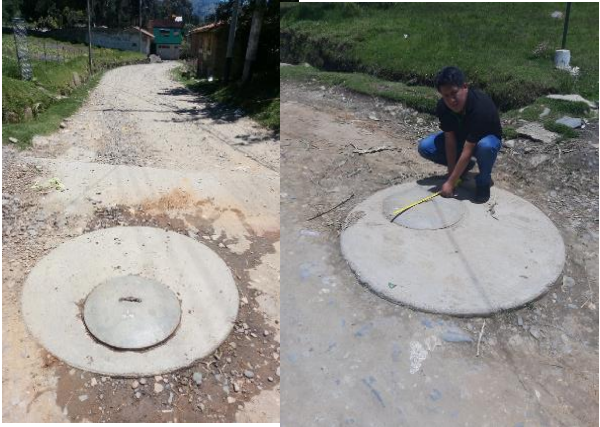
Fotografía 24. Sistema de desagüe – Buzones N°01
