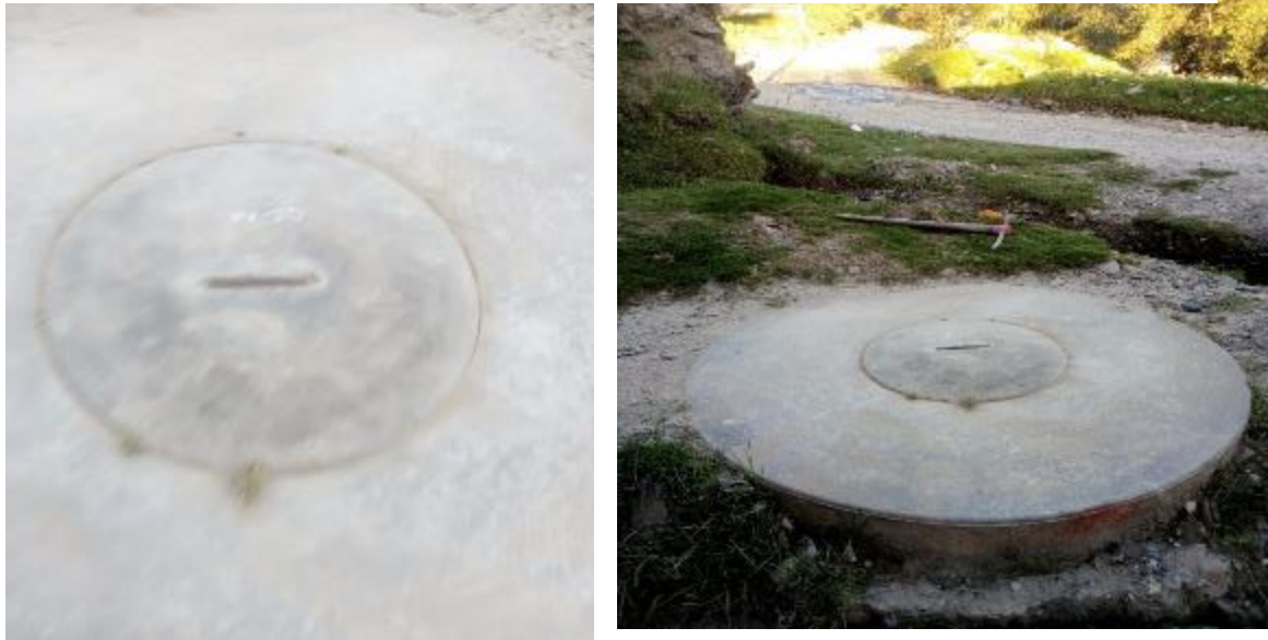
Fotografía 56. Sistema de desagüe – Buzones N° 33
