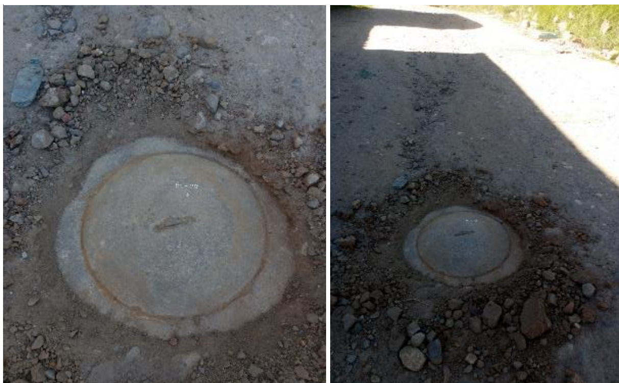
Fotografía 32. Sistema de desagüe – Buzones N°09
