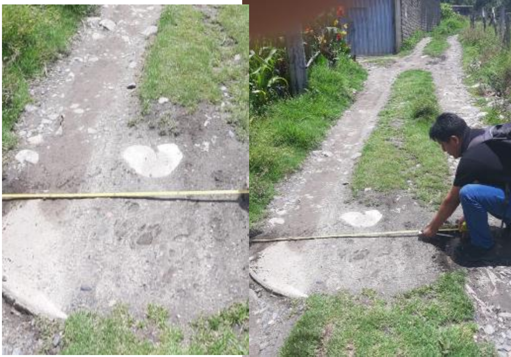
Fotografía 35. Sistema de desagüe – Buzones N°12
