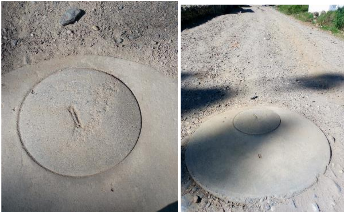
Fotografía 36. Sistema de desagüe – Buzones N°13
