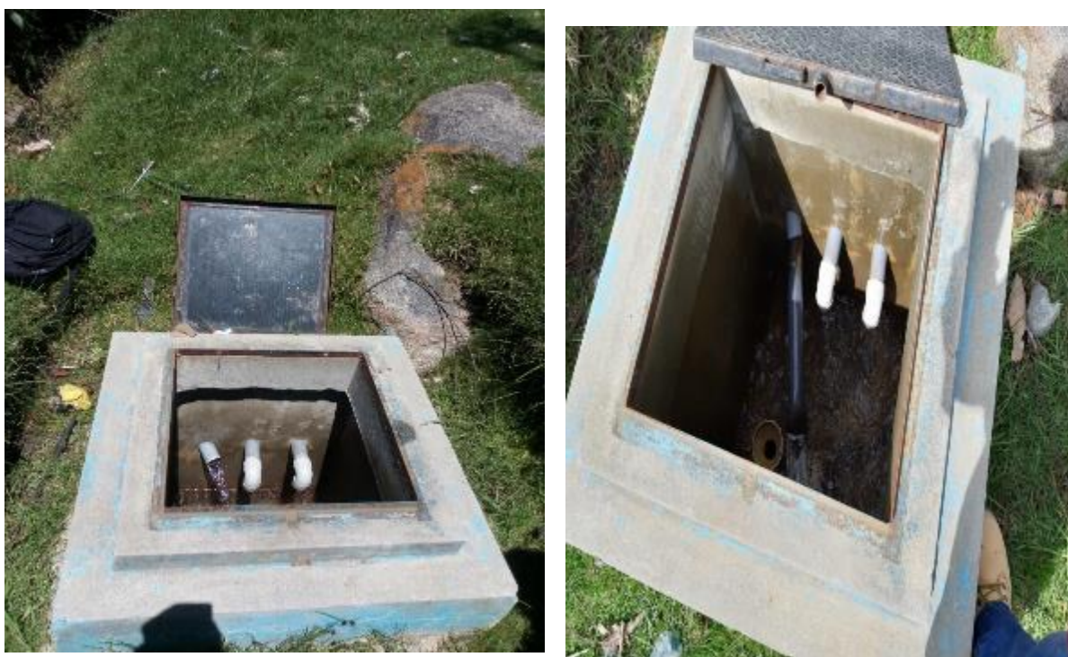
Fotografía 12. : Sistema de Agua potable – cámara de reunión del reservorio N° 01
