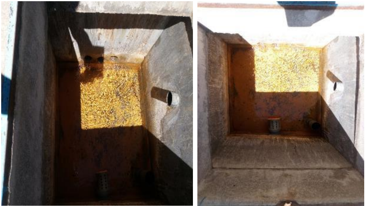
Fotografía 2. Sistema de Agua potable – Captación N° 01 (Parte Interna)
