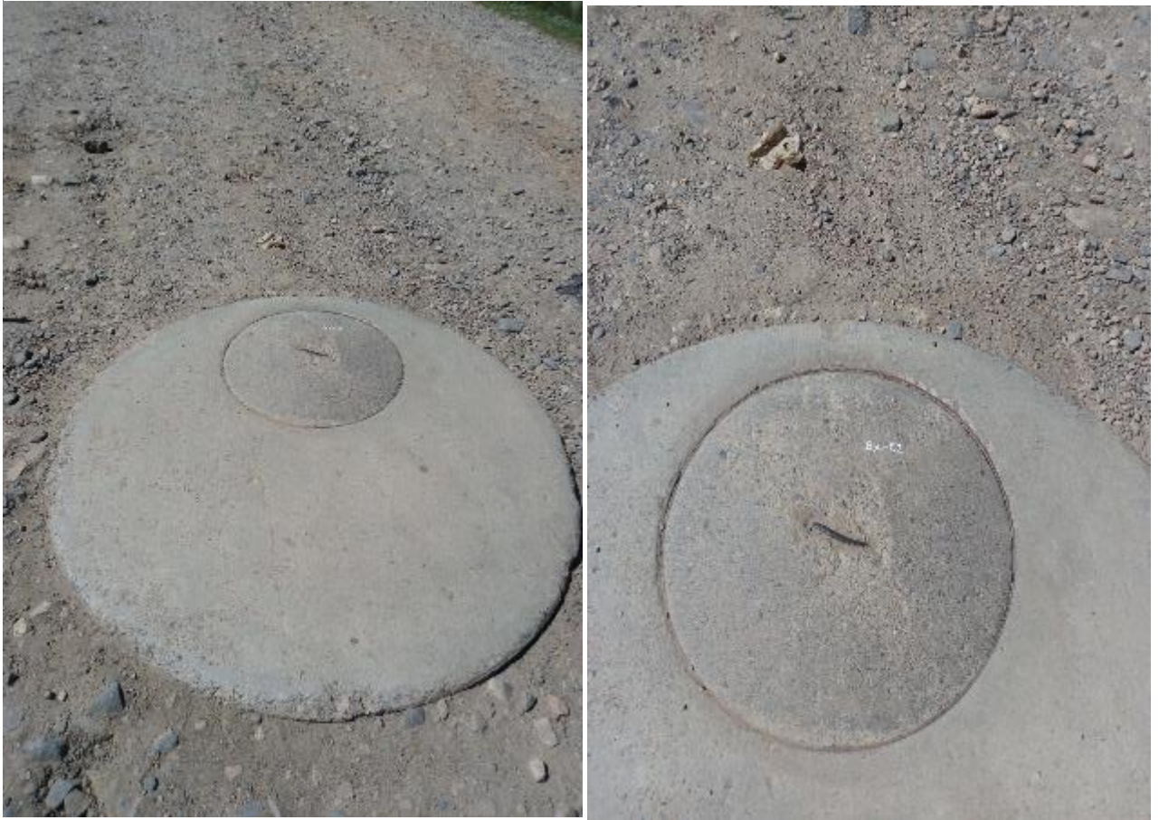
Fotografía 25. Sistema de desagüe – Buzones N°02
