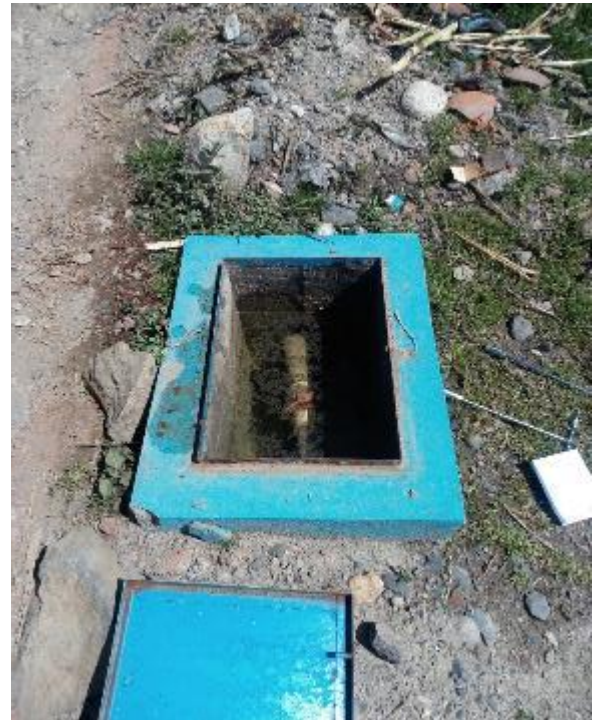
Fotografía 23. Sistema de Agua potable – Caja de Válvulas N° 04
