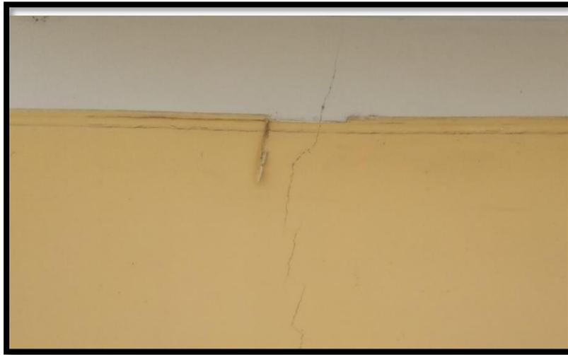
**Figura 3.** Fisura en revestimiento de Muro
