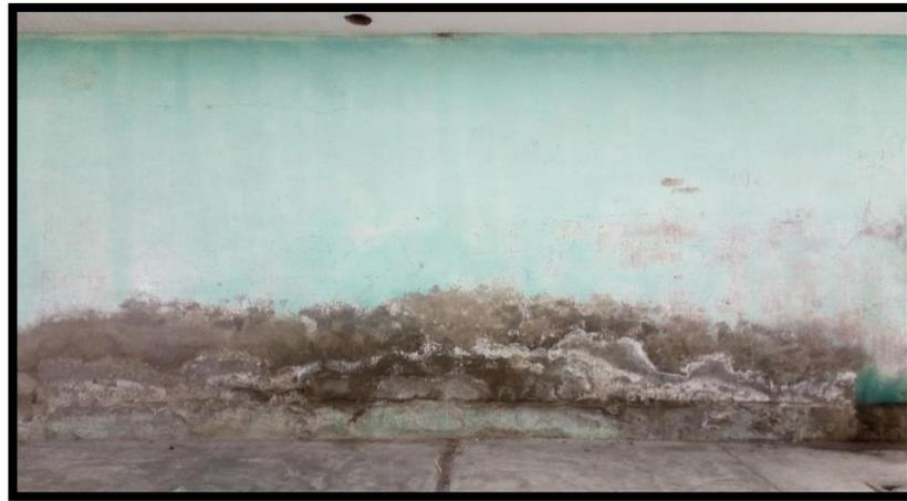
*Figura 5.* Eflorescencia en parte inferior del muro
