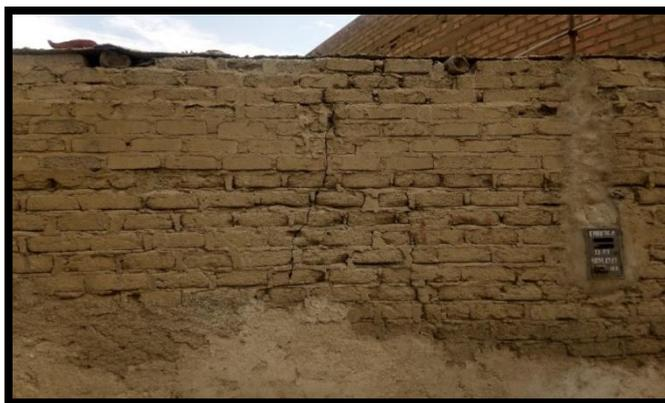
**Figura 2.** Grieta vertical en Muro
