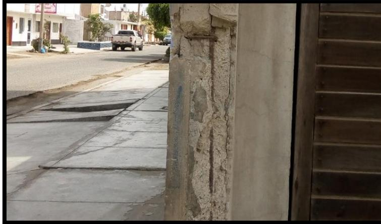
**Figura 6.** Corrosión en Columna de vivienda
