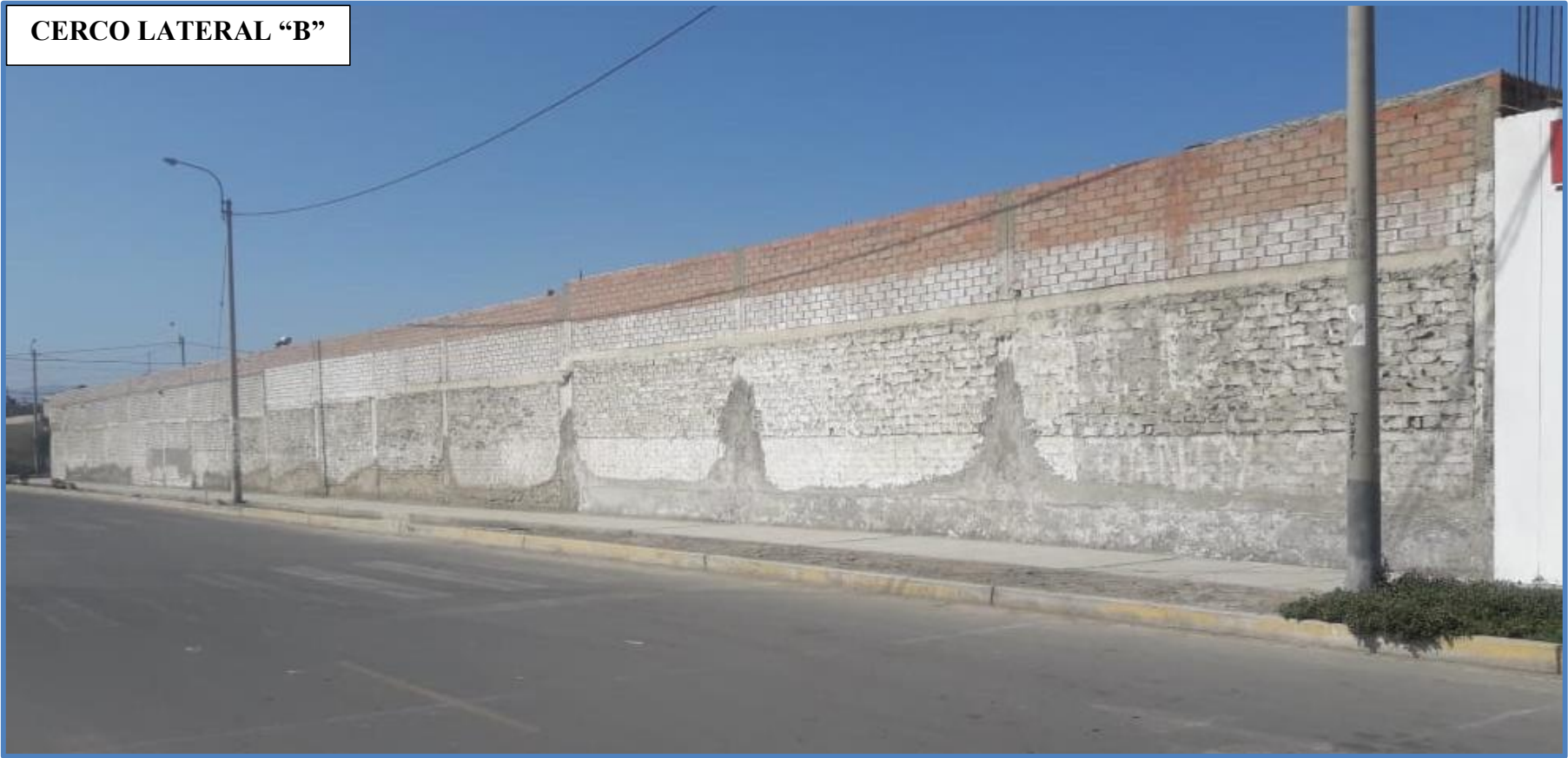
Fotografía 03: Fotografía panorámica del cerco lateral “B” de la empresa Transportes Mendoza S.R.L.
