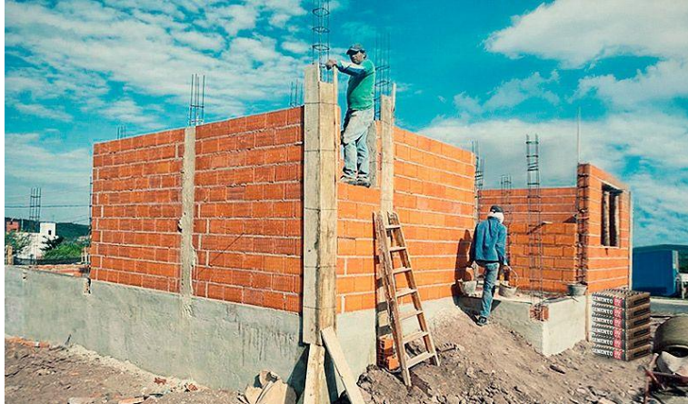
Gráfico 4. Albañilería confinada. Fuente: Cementos INKA (2018).
