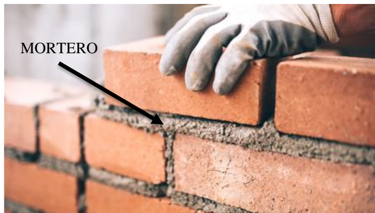
Gráfico 14. Mortero para asentar ladrillos. Fuente: RPP (2018).
