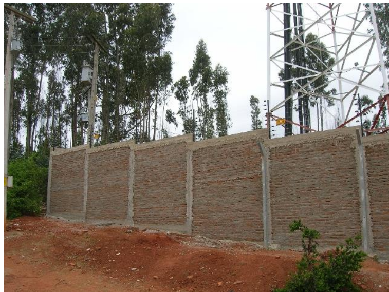
Gráfico 1. Cerco de albañilería confinada.
