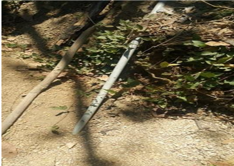
Tubería existente que viene del reservorio
