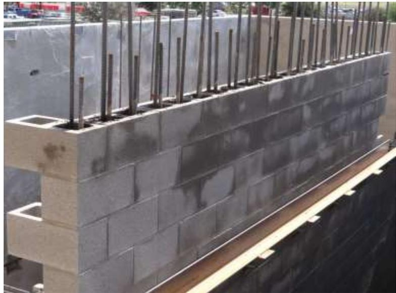
**Imagen 09:** Albañilería armada.
