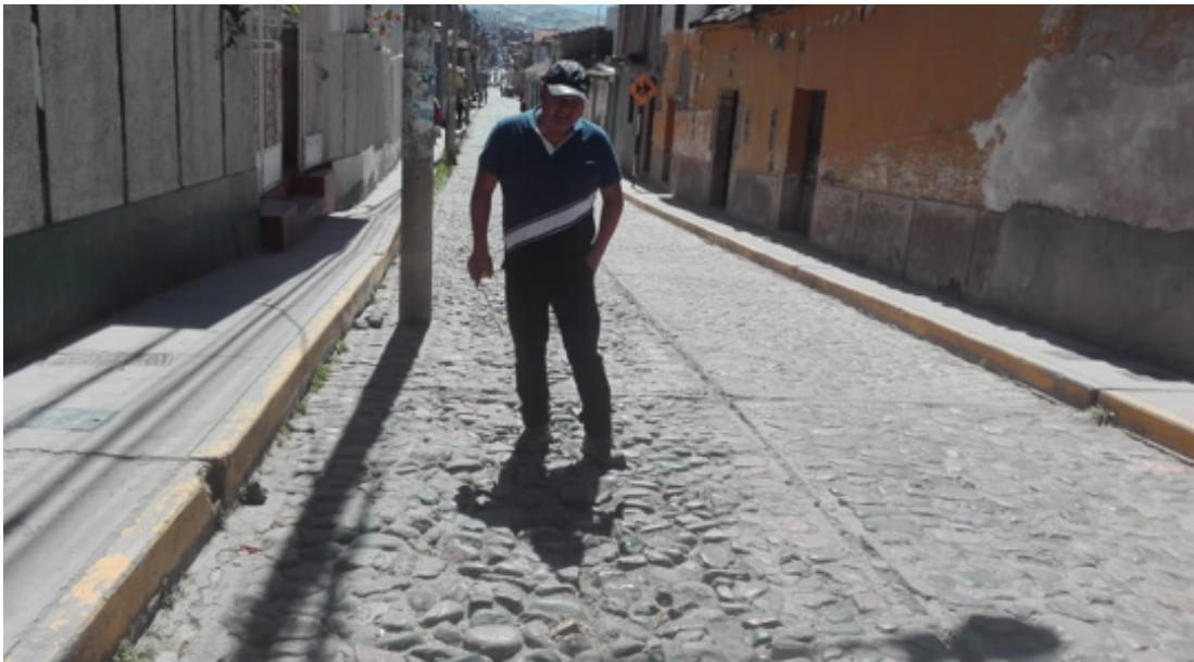
Fotografía 2: Fotografía del tramo 4.
