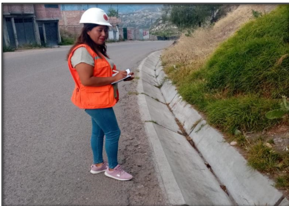
Fotografía 2: Falla tipo grieta borde encontrado en el Km 000+574 en de la carretera Emp. Pe-3s (Ayacucho)-Socos.
