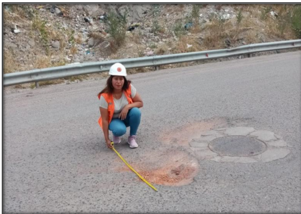
Fotografía 4: Falla tipo baches encontrado en el Km 000+657 de la carretera Emp. Pe-3s (Ayacucho)-Socos.
