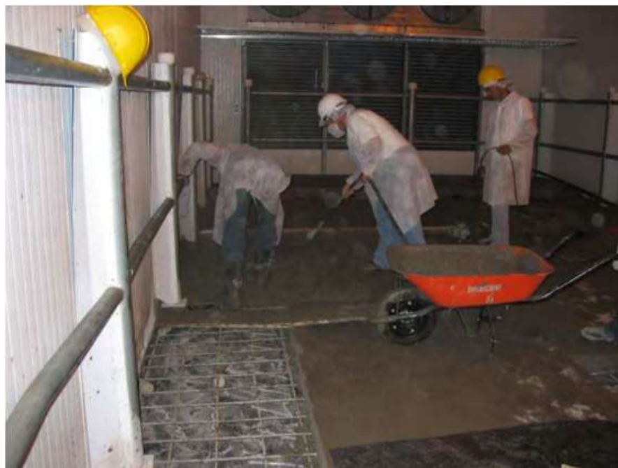
Imagen 3: Colocación del Concreto de Reparación Fuente: Tesis en mención
