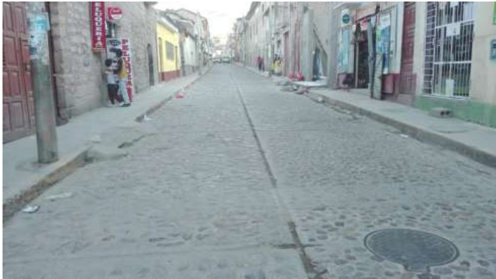
Imagen 20: Tramo 2 de la 6ta cuadra Jr. Grau Fuente: Elaboración Propia
