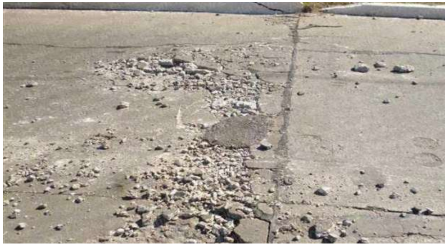
Imagen 7: Aspecto Actual de la Av. Arenales Fuente: Tesis en mención
