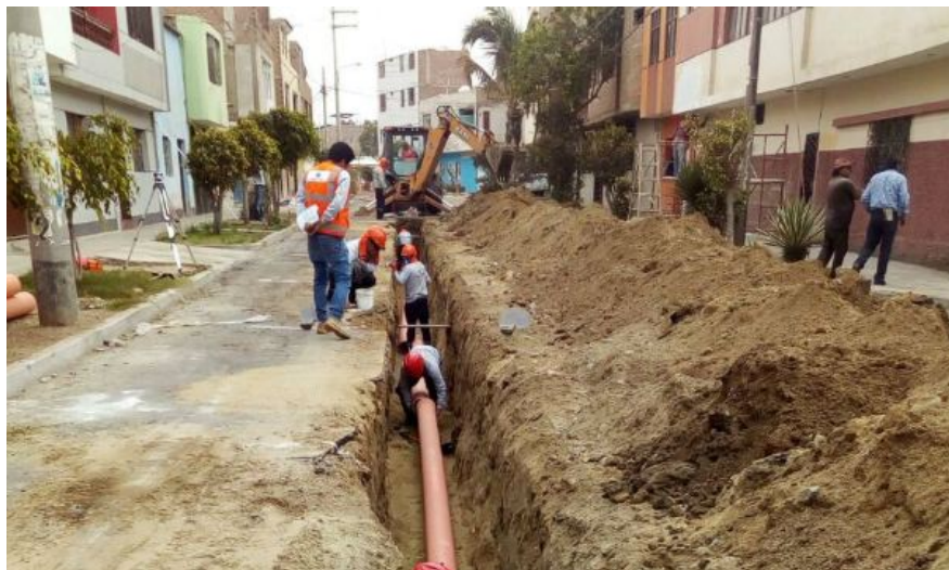
Figura 2.5: Instalación del Alcantarillado.
