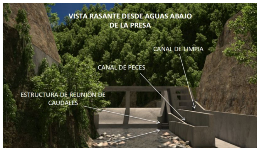
Figura 2.1: Obra de Captación de Agua.
