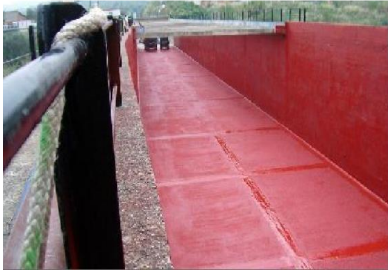
Figura 6: Juntas longitudinales de contracción
