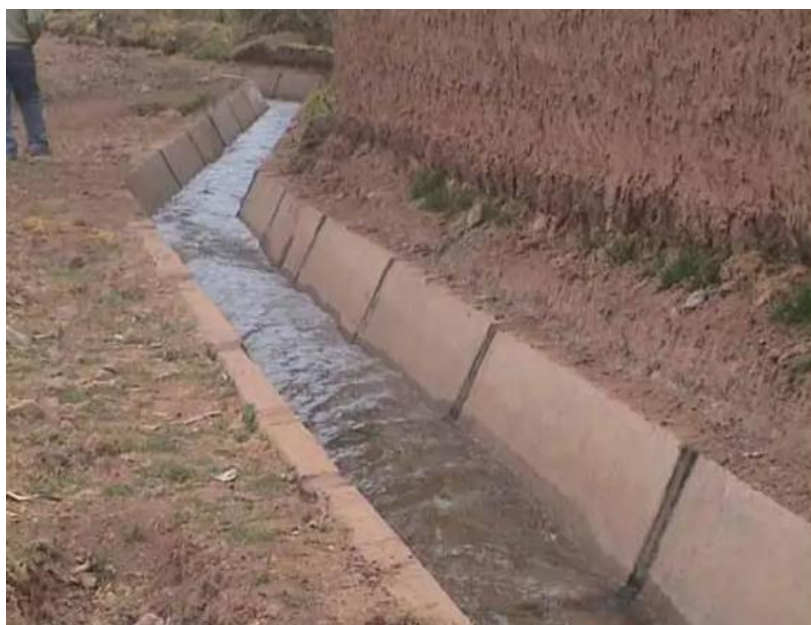
Figura 5: Juntas transversales de contracción
