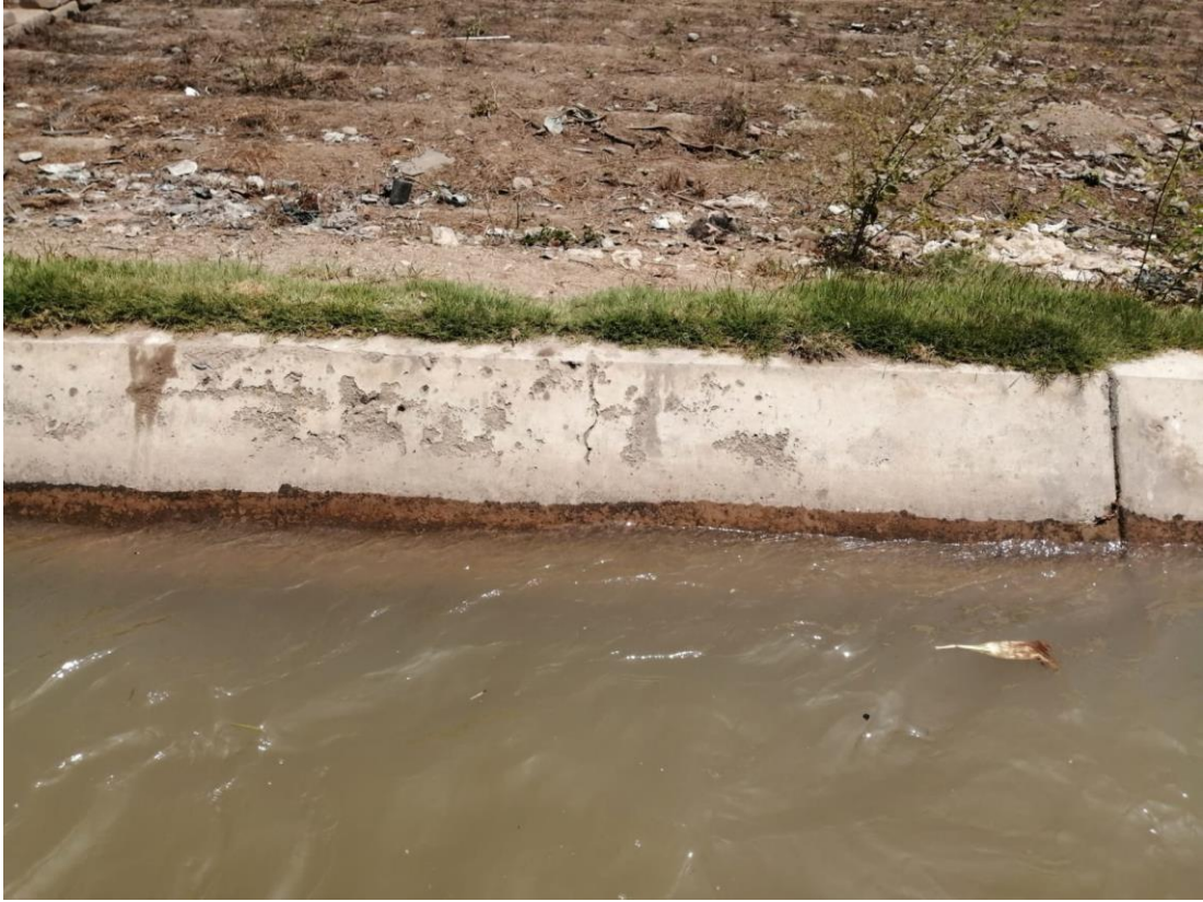
Fotografía 02: Tomando medidas grietas.
