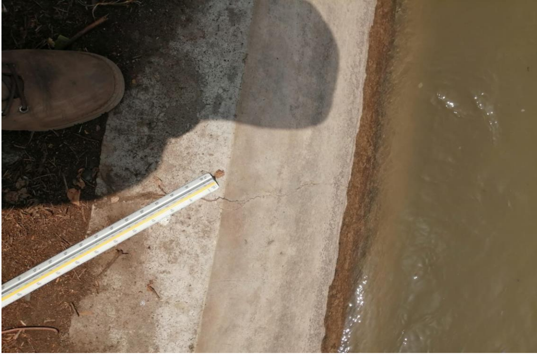
Fotografía 04: Tomando medidas fisura.
