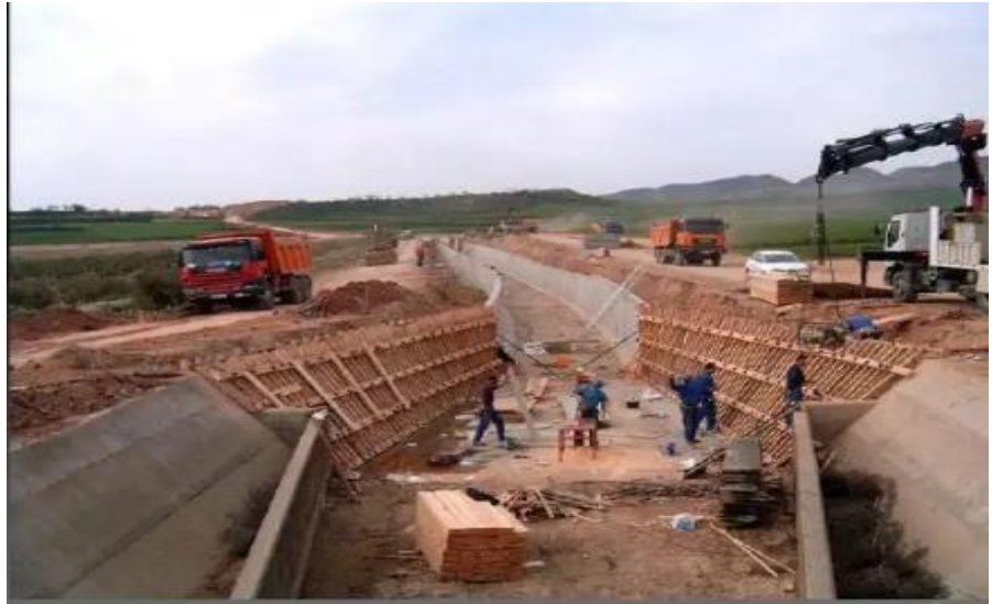
Figura 4: Junta de construcción
