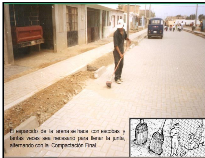
Grafico N° 09: Relleno de las Juntas con Arena
