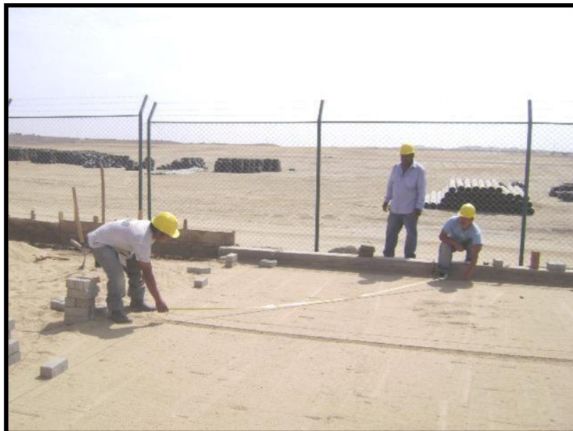
Gráfico N° 06: Extendido y Nivelación de la Capa de Arena
