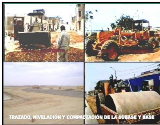
Gráfico N° 05: Preparación de la Sub-base y/o base
