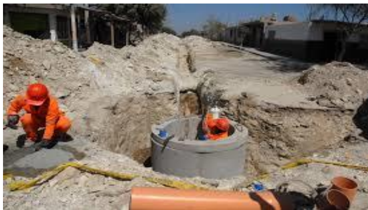
Fuente: buzones de alcantarillado.
