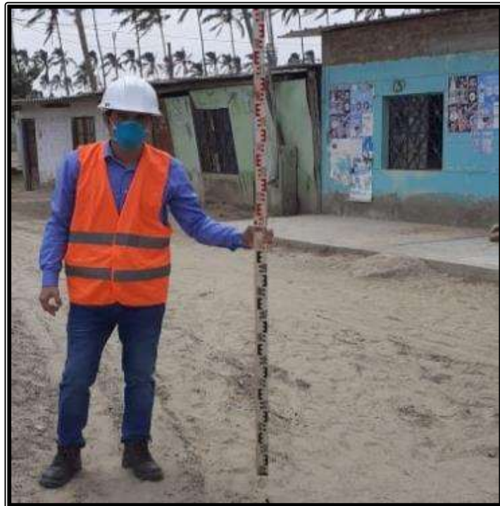
Figura 25: Determinación de ejes y cotas en terreno natural. Fuente: Elaboración propia (2020).
