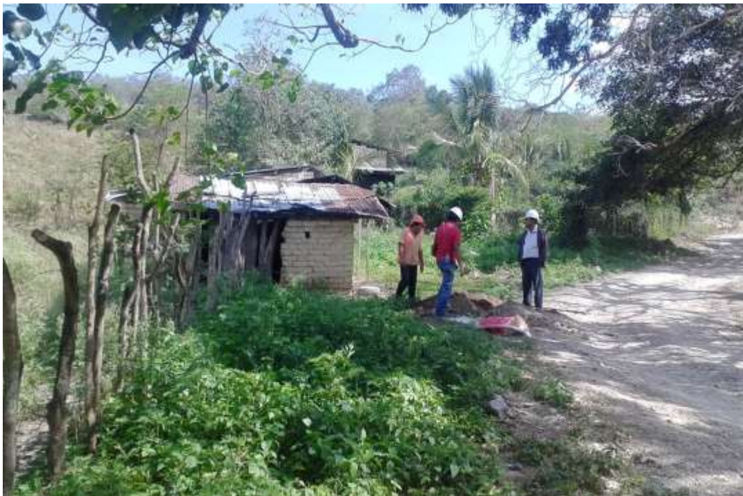
Ubicación de la excavación de calicata.
