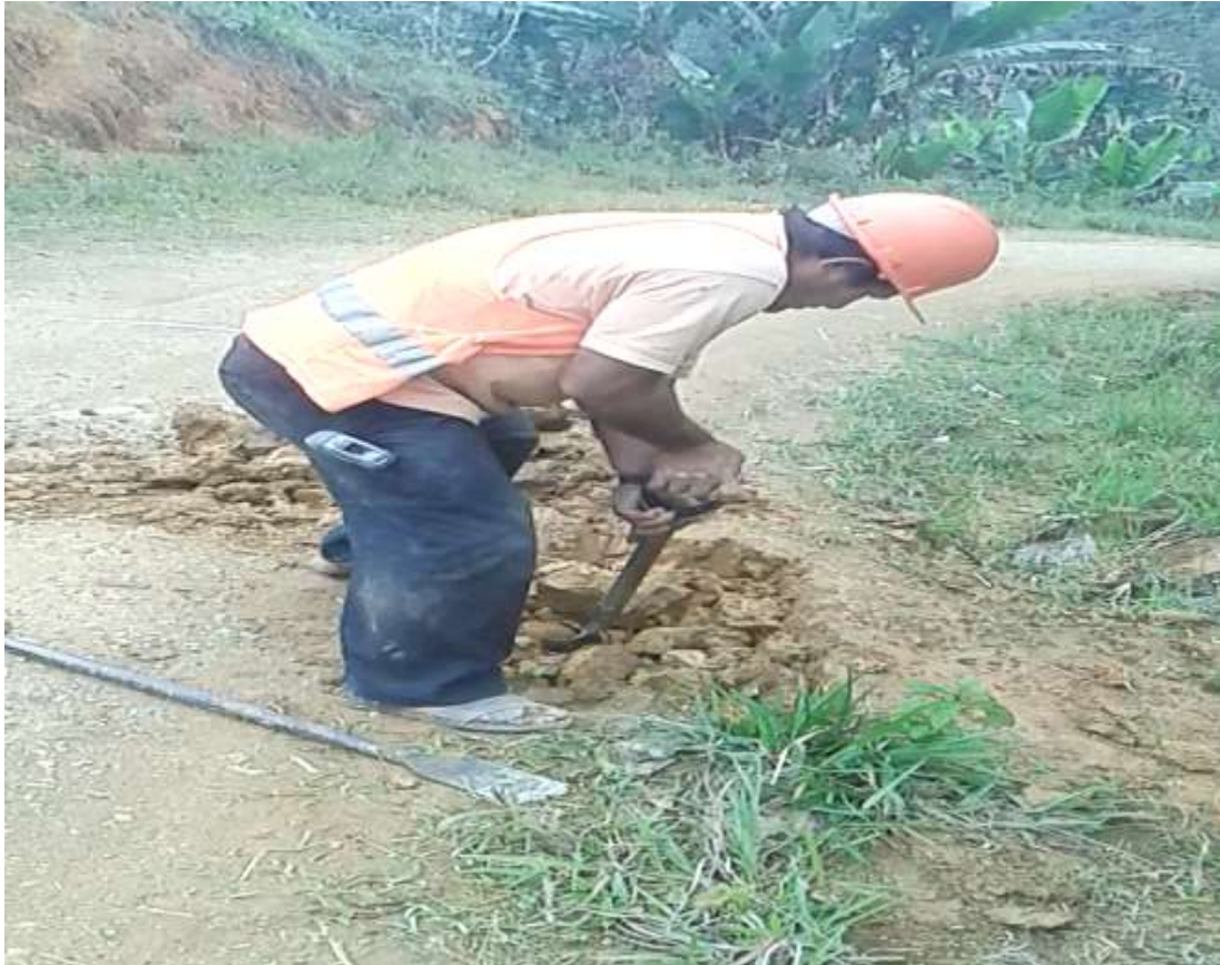
TRABAJOS PARA EXCAVACIÓN DE CALICATA PARA ESTUDIO DE SUELOS (2020)
