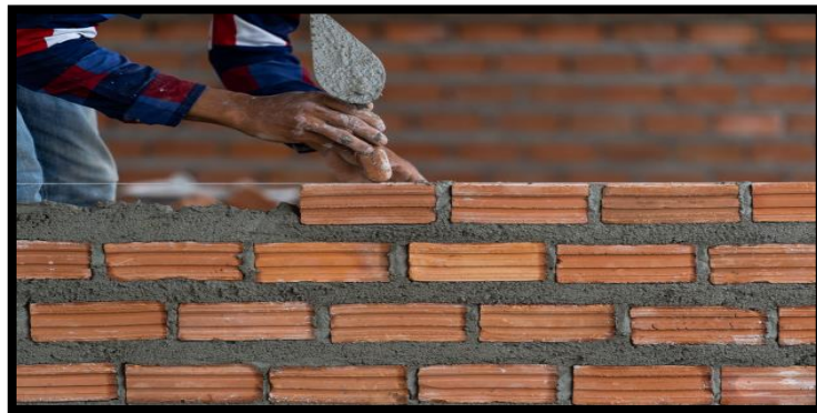
Gráfico 1: Muro de albañilería simple Nota: Freepik (2010).
