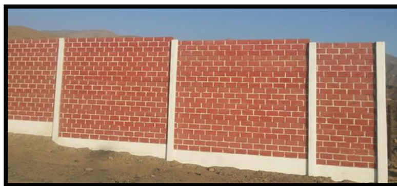
Gráfico 6: Muro de ladrillo en cerco Fuente: Sipca (2010)
