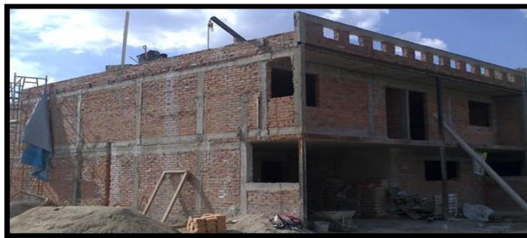
Gráfico 3: Construcción de albañilería confinada. Fuente: Habitissimo (2019).
