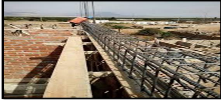
Gráfico 5: Viga de concreto armado Fuente: Fernando Plasencia (2015)
