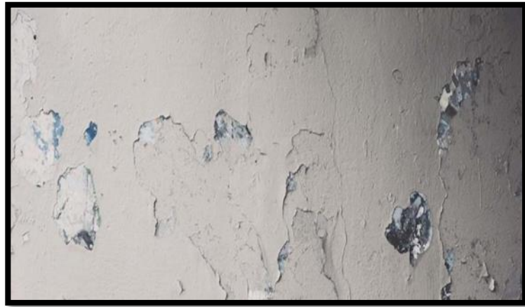
Gráfico 10: Muro con Desconchamiento Fuente: Bricopared (2013).
