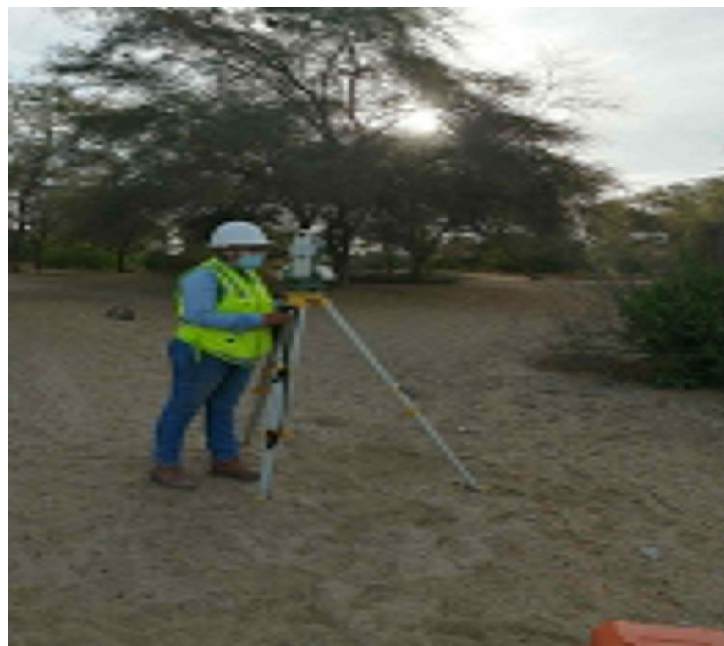
Imagen 12: Colocando la estación Total para realizar la topografía
