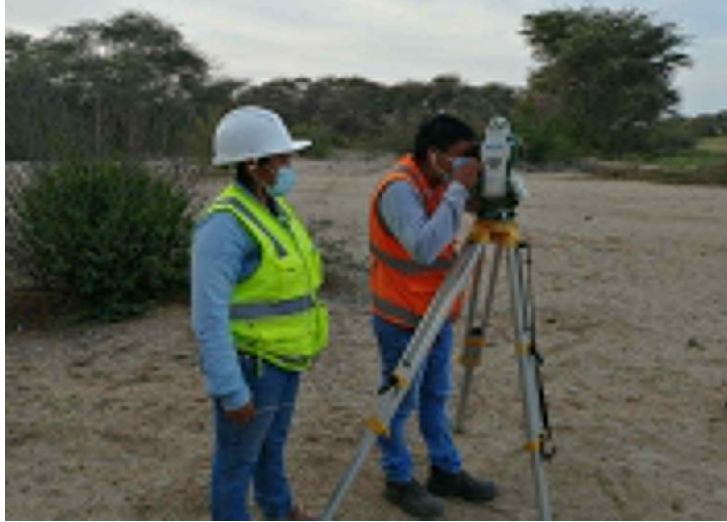
Imagen 13: Realizando lectura durante el proceso de levantamiento topográfico
