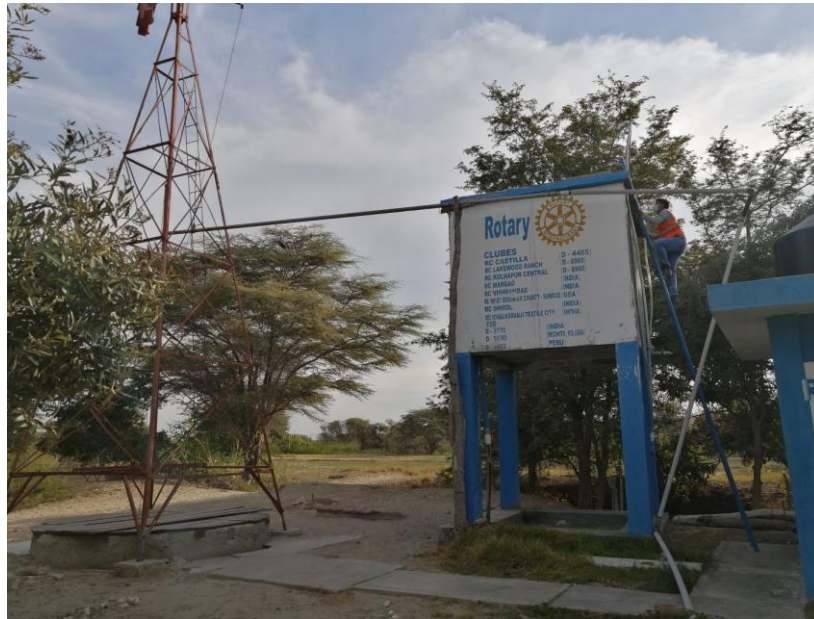
Imagen 5: Sistema de tanque elevado existente
