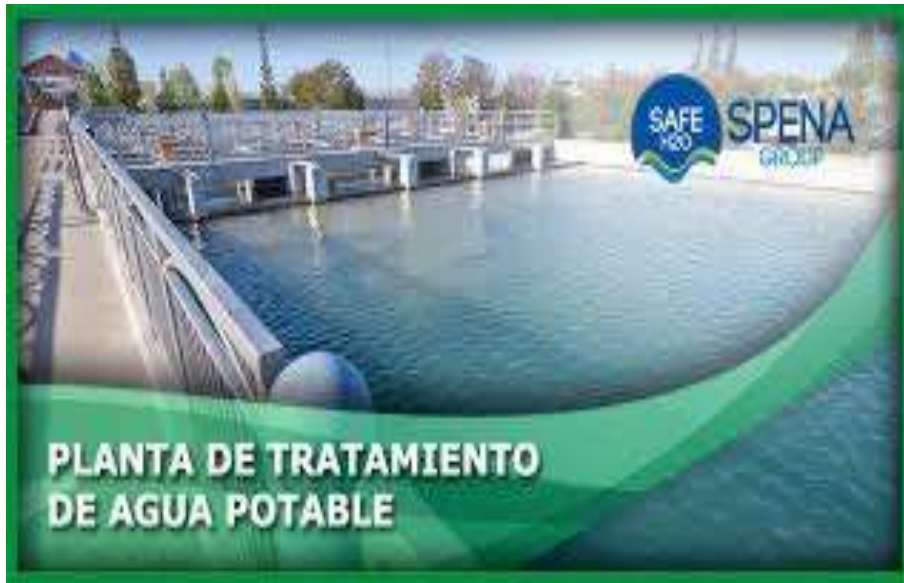
Imagen 3: Planta De Tratamiento
