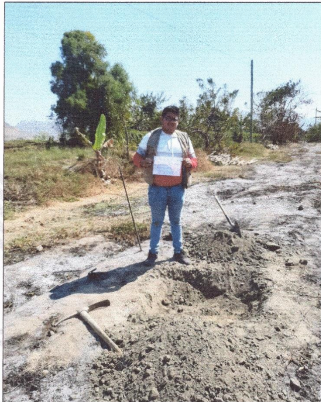
Foto N° 07.- Se aprecia la vista panorámica de calicata C-04 del Reservorio
