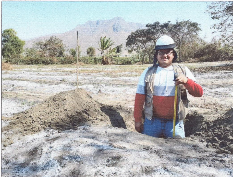
Foto N° 03.- Se aprecia en detalle la profundidad de la calicata C-02 de la LÍNEA DE CONDUCCIÓN (Tramo 01)
