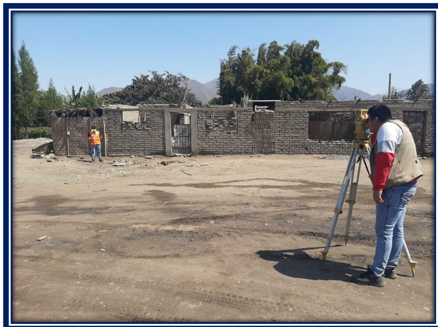
Imagen 7. Levantamiento topografico en el caserío Breña Isco.
