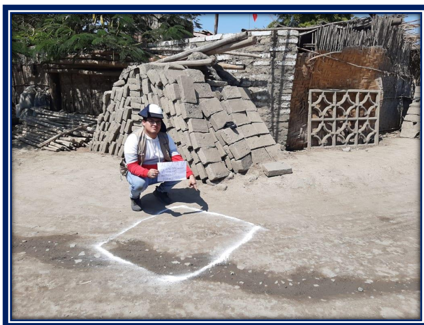
Imagen 8. Marcando el lugar donde se realizara la calicata de 1.00 m x 1.00 m para el estudio de suelo del caserío Breña Isco.
