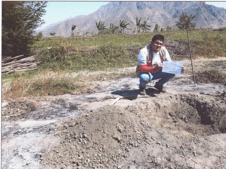
Foto N° 04.- Se aprecia la vista panorámica de calicata C-03 de la LÍNEA DE CONDUCCIÓN (Tramo 02)
