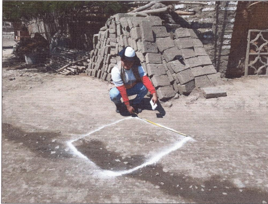
Foto N° 10.- Se aprecia la vista panorámica de calicata C-06 del Pueblo 02
