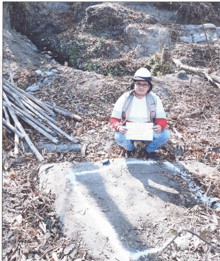
Foto N° 01.- En la toma se aprecia una vista panorámica del lugar donde se excavó la Calicata C-01.
