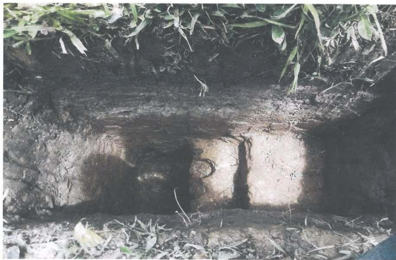
VISTA DE LA CALICATA N° 22 – RED N° 02 – KM. 0+400 – SECTOR LOS MEDIOS
