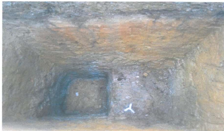
VISTA DE LA CALICATA N° 10 - LINEA DE ADUCCION - KM. 1+200
