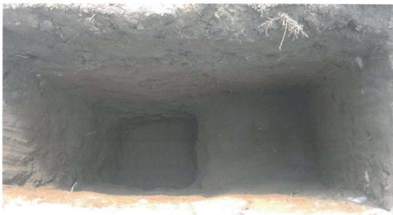
VISTA DE LA CALICATA N° 14 – LINEA DE ADUCCION – KM. 2+800
