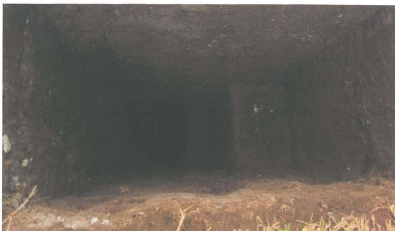
VISTA DE LA CALICATA N° 23 – RED N° 03 – KM. 0+200 – SECTOR LOS MEDIOS
