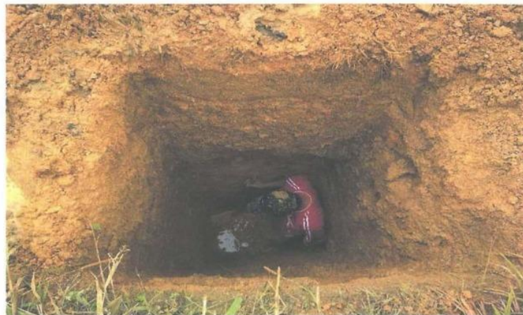
VISTA DE LA CALICATA N°18, H=3.00m – E DE LA PLANTA DE TRATAMIENTO DE AGUA POTABLE (PTAR)
