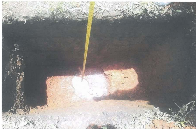
VISTA DE TES. DE PERCOLACION N° 01 – SECTOR LOS MEDIOS
