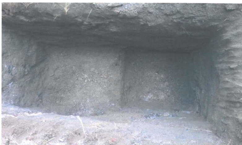
VISTA DE LA CALICATA N° 24 - RED 04 - KM 0+400 SECTOR ALTO
