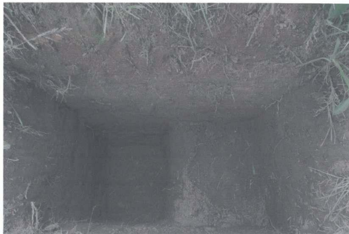
VISTA DE LA CALICATA N° 02 – CAPTACION N° 02
