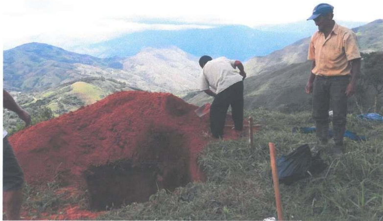
VISTA PANORAMICA DE LA CALICATA N° 07 – RESERVORIO
