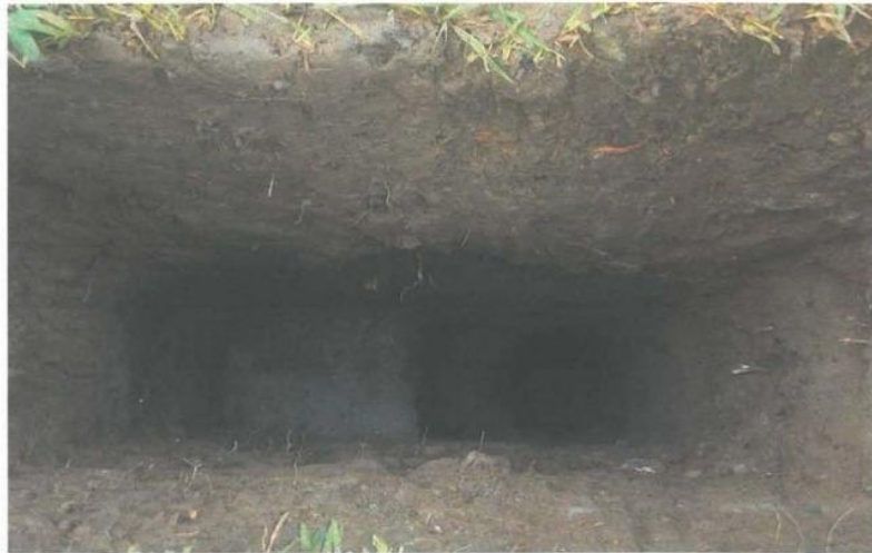
VISTA DE LA CALICATA N° 17 – RED DE AGUA POTABLE – SECTOR AHUYACA
