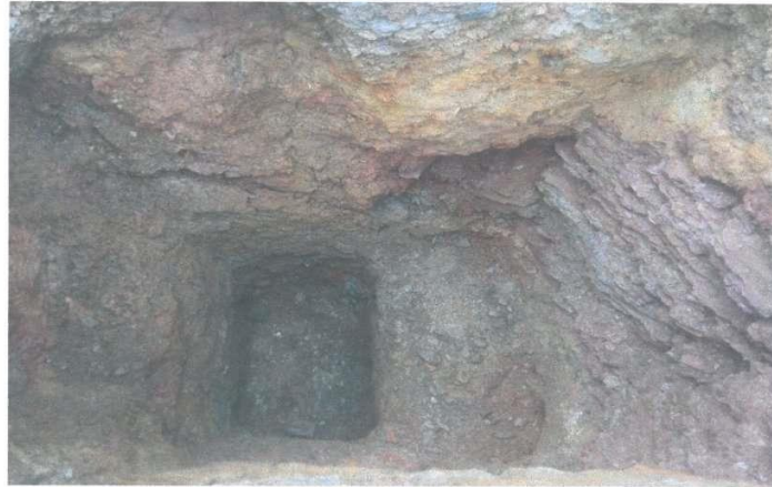
VISTA DE LA CALICATA N° 11 – LINEA DE ADUCCION – KM. 1+600
