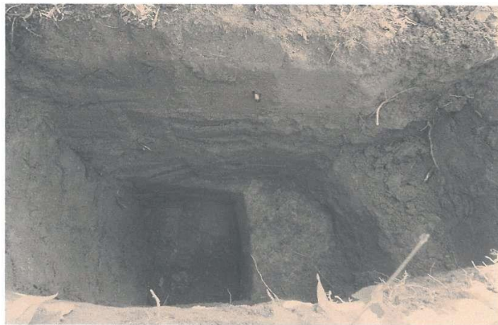
VISTA DE LA CALICATA N° 01 – CAPTACION N° 01
