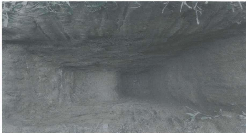
VISTA DE LA CALICATA N° 04 - LINEA DE CONDUCCION - KM. 1+200
