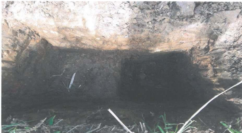
VISTA DE LA CALICATA N° 16 – RED DE DISTRIBUCION – SECTOR AHUYACA
