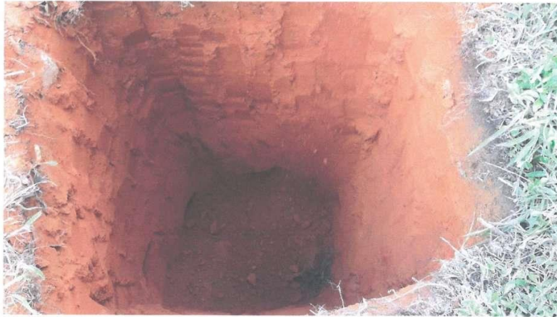
VISTA DE LA CALICATA N° 21 – LINEA DE ADUCCION – KM. 1+000 – SECTOR LOS MEDIOS
