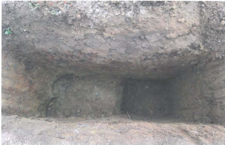
VISTA DE LA CALICATA N° 13 – LINEA DE ADUCCION – KM. 2+400
