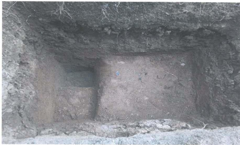
VISTA DE LA CALICATA N° 06 – PLANTA DE TRATAMIENTO DE AGUA POTABLE
