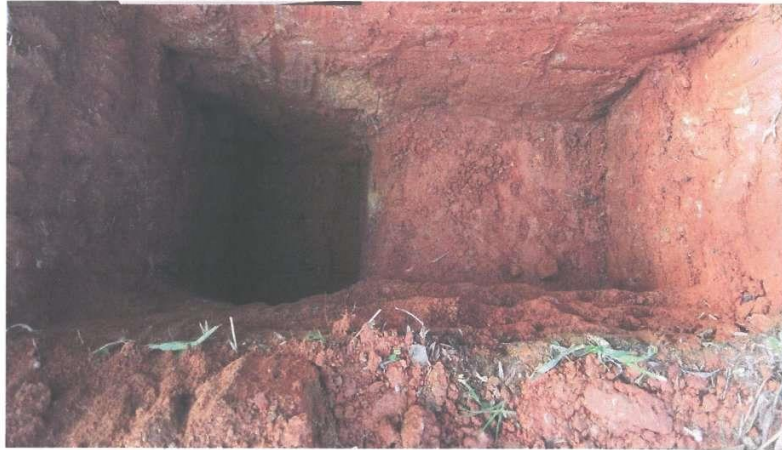
VISTA DE LA CALICATA N° 09 - LINEA DE ADUCCION - PASE AEREO N° 01 - KM.0+940
