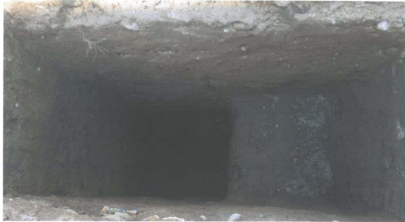
VISTA DE LA CALICATA N° 15 – LINEA DE ADUCCION – KM. 3+200
