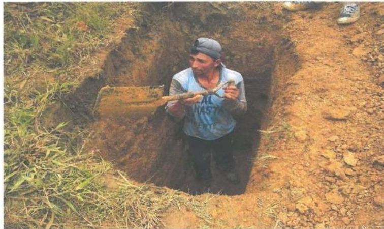
VISTA DE LA CALICATA N°25, H=2.00m – LECHO DE SECADO DE LA PLANTA DE TRATAMIENTO DE AGUA POTABLE (PTAP)
