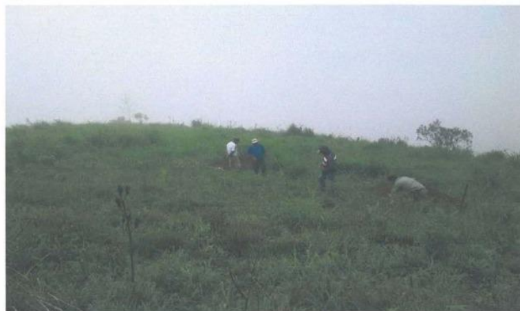
VISTA PANORAMICA DE LA CALICATA N°26 – PREFILTRO DE LA PLANTA DE TRATAMIENTO DE AGUA POTABLE (PTAP)
