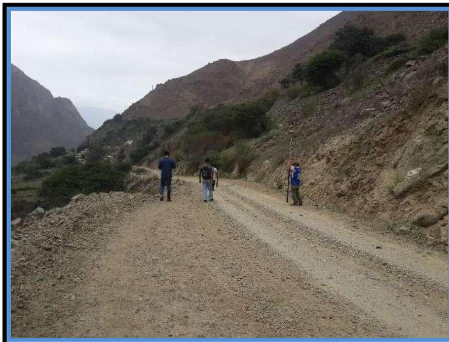
**FOTOGRAFIA N°08: SE PUEDE OBSERVAR LOS TRABAJOS DE TOPOGRAFIA EN LA CARRETERA POR LA CUAL PASARA LA LINEA DE CONDUCCION**
