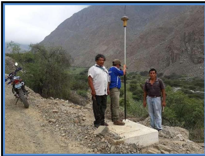
**FOTOGRAFIA N°07: SE PUEDE OBSERVAR LOS TRABAJOS DE TOPOGRAFIA EN EL CRUCE DE LA LINEA DE CONDUCCION Y LA CARRETERA**
