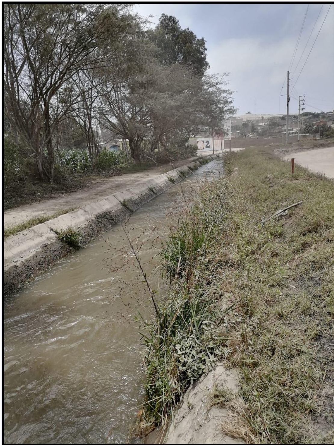
Figura 1: foto panorámica del canal CARLOS LEIGHT
