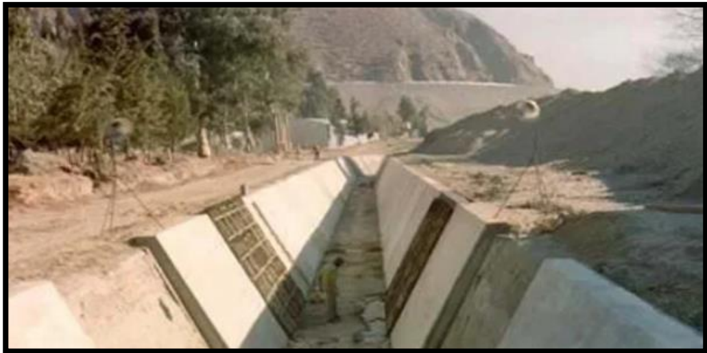
Figura 2: Construcción del canal
