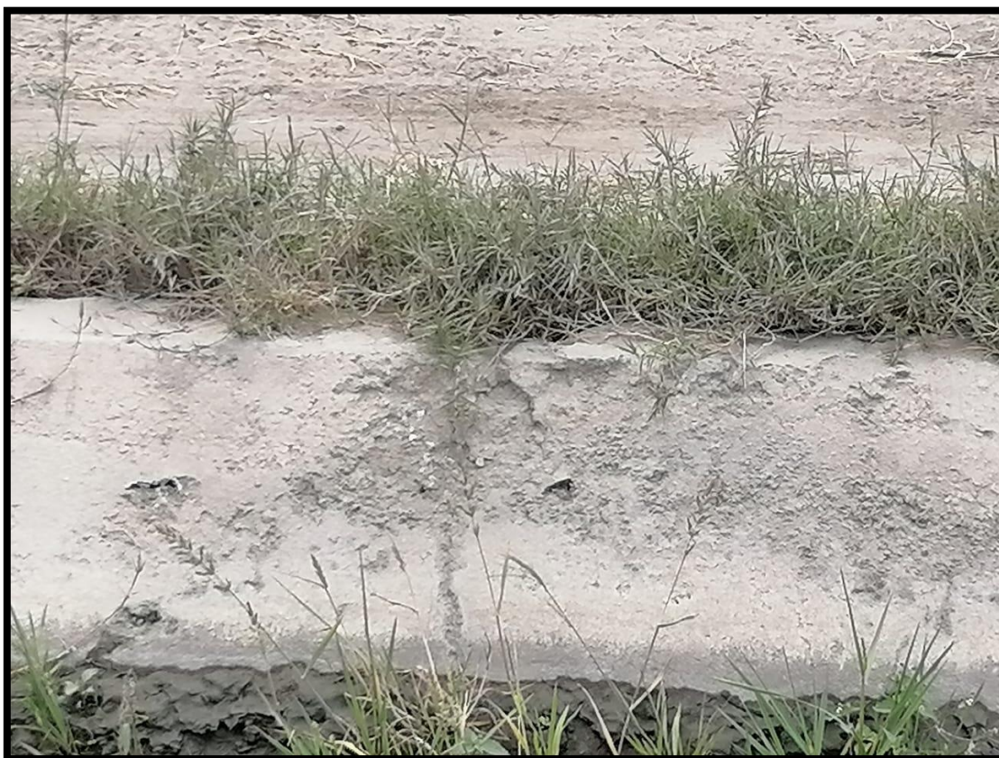
Figura 2: se observa falla de descascaramiento y fisuración en el la muestra
