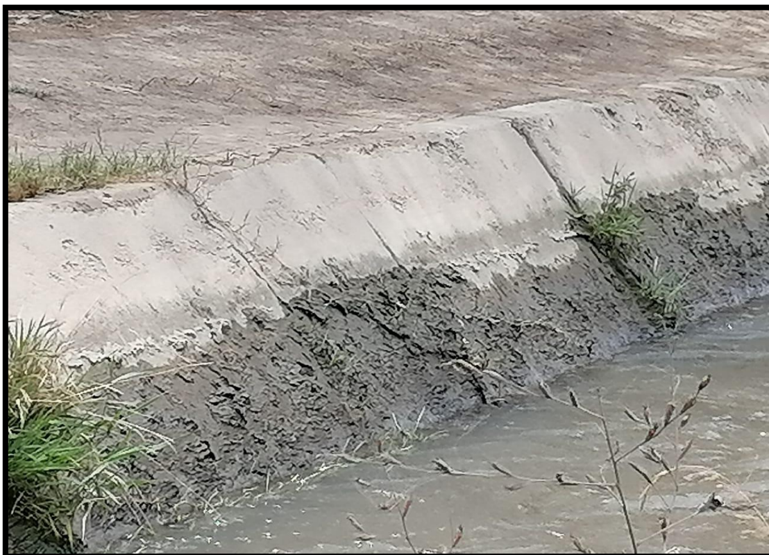
Figura 2: se observa falla de descascaramiento y fisuración en el la muestra
