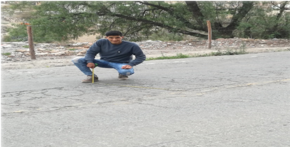
Fotografía 2: Grietas de piel de cocodrilo.
