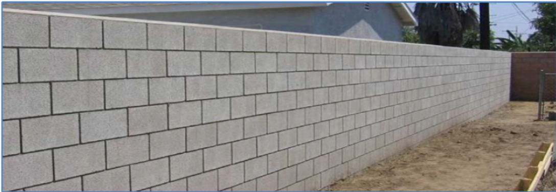
Figura 2.1: Muros no portantes. Fuente:(tomada desde (encuentra24 2018))
