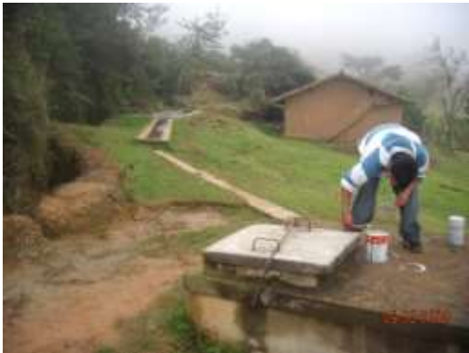
Se aprecia la captación de Agua existente.
