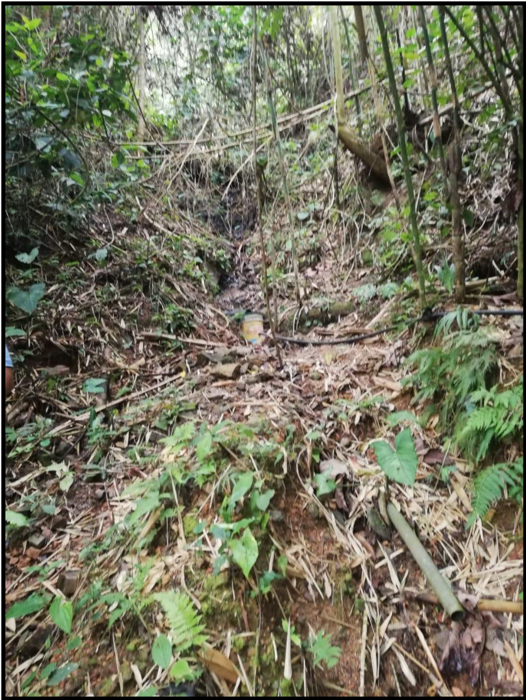
fotografía 2: captacion artesanal improvisada
