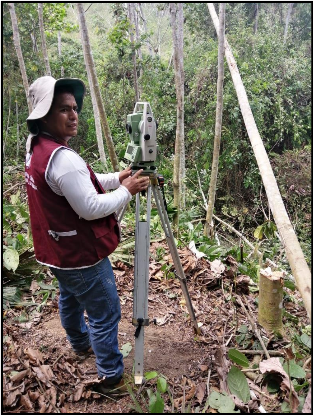
fotografía 5: levantamiento topográfico de la línea de conducción.
