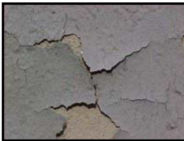
Gráfico 15: Descascaramiento
