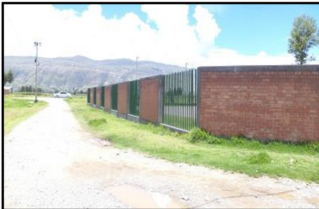
Foto 04: Vista panorámica del Cerco Perimétrico Jirón: Eucalipto (Sur) - Exterior
