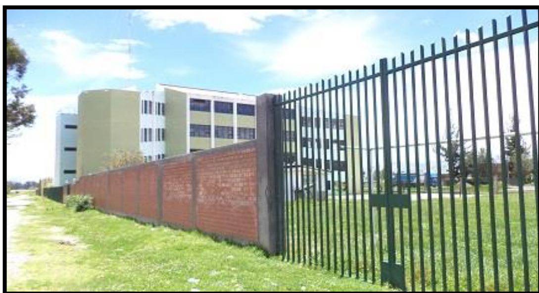
Foto 03: Vista panorámica del Cerco Perimétrico Jirón: San Marcos (Este) - Exterior
