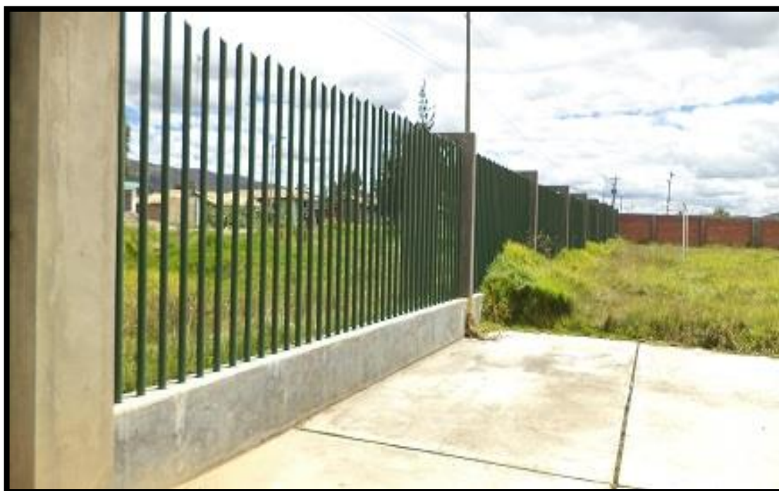
Foto 05: Vista panorámica del Cerco Perimétrico Carretera Central (Oeste) – Exterior
