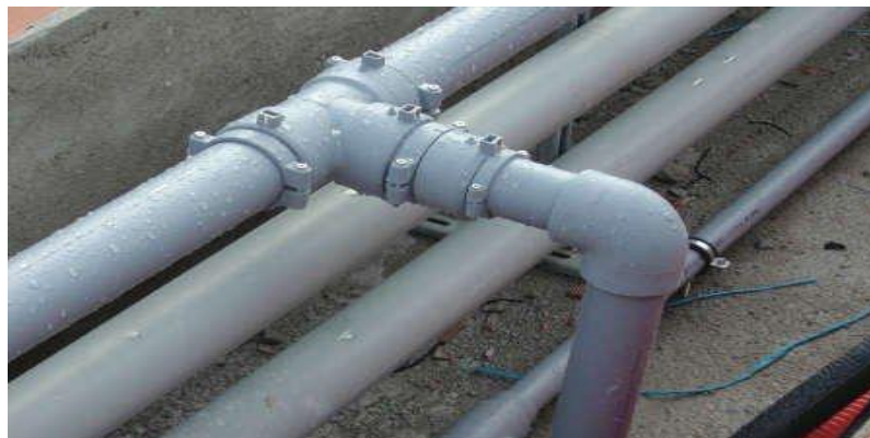
Imagen 4: Tubería de PVC.
