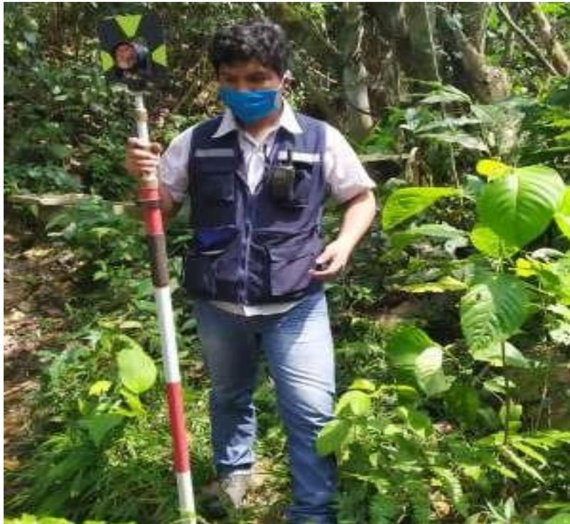
*Figura 29: levantamiento topográfico en la línea de conducción*
