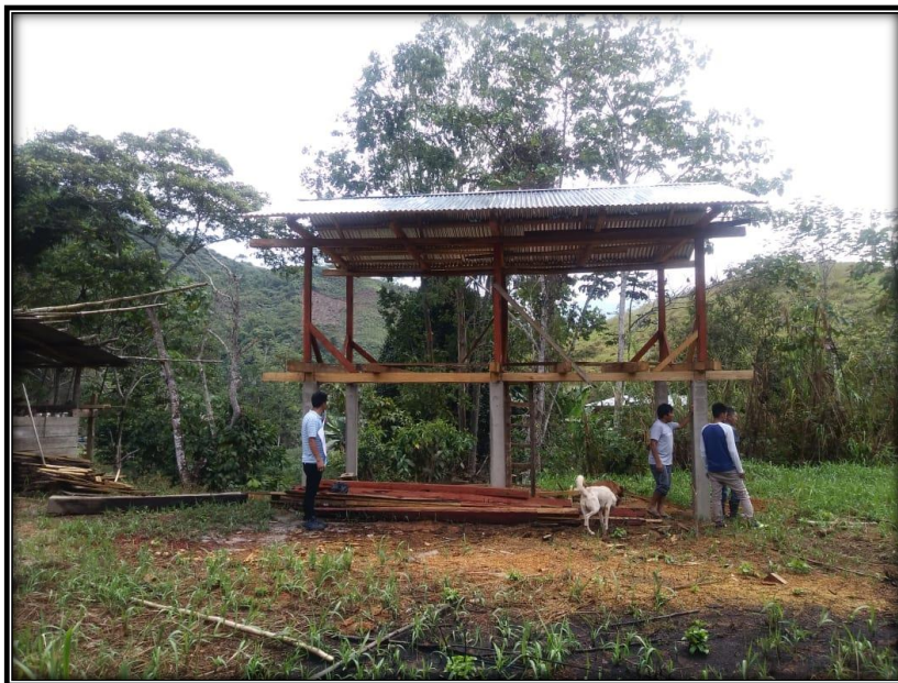
Fotografía 16: Levantamiento de las viviendas beneficiarias donde se proyectarán agua potable
