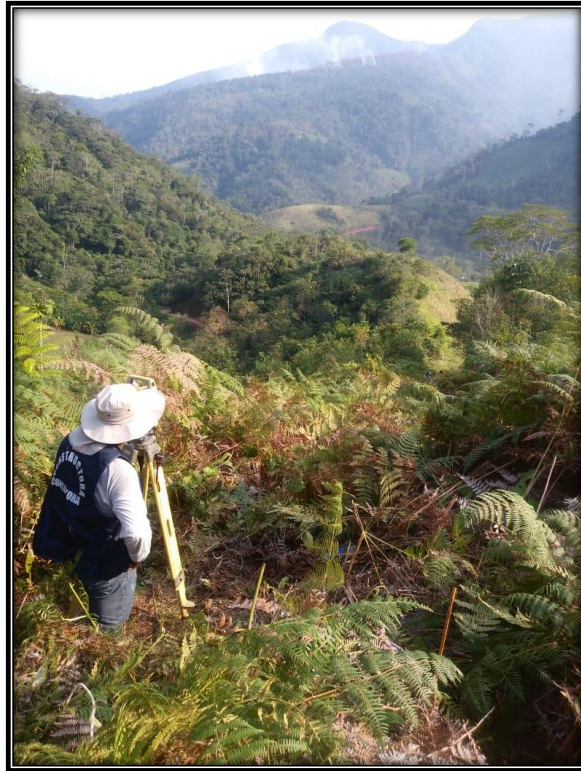
Fotografía 09: Vista levantamiento topográfico en la línea de aducción
