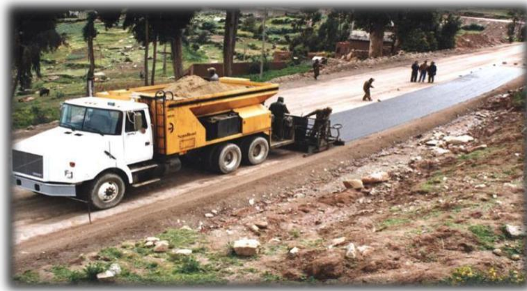
Figura 03. Proceso constructivo del pavimento flexible (Bolivia)
