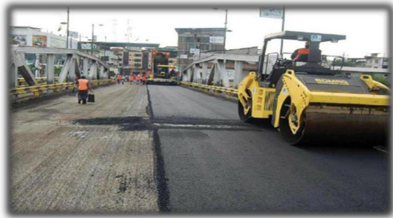
Figura 01. Proceso constructivo del pavimento flexible
