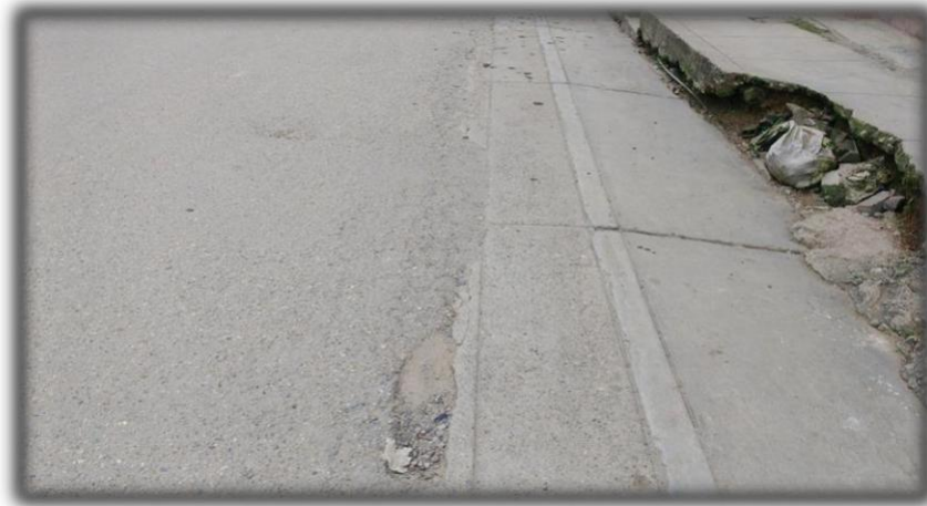
Figura 137. Huecos de severidad media (U-02)
