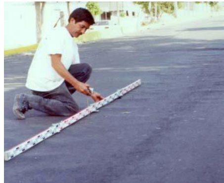
Figura 23. Falla de severidad media (corrugación)
