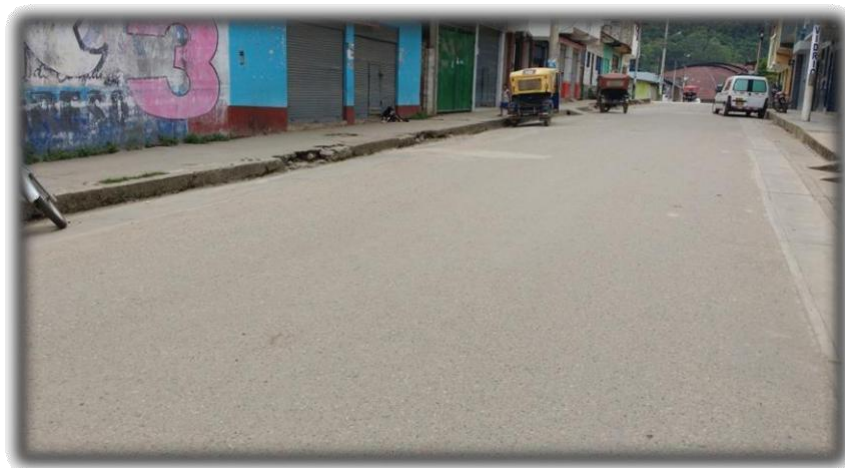
Figura 151. Pulimiento de agregados (U-03)
