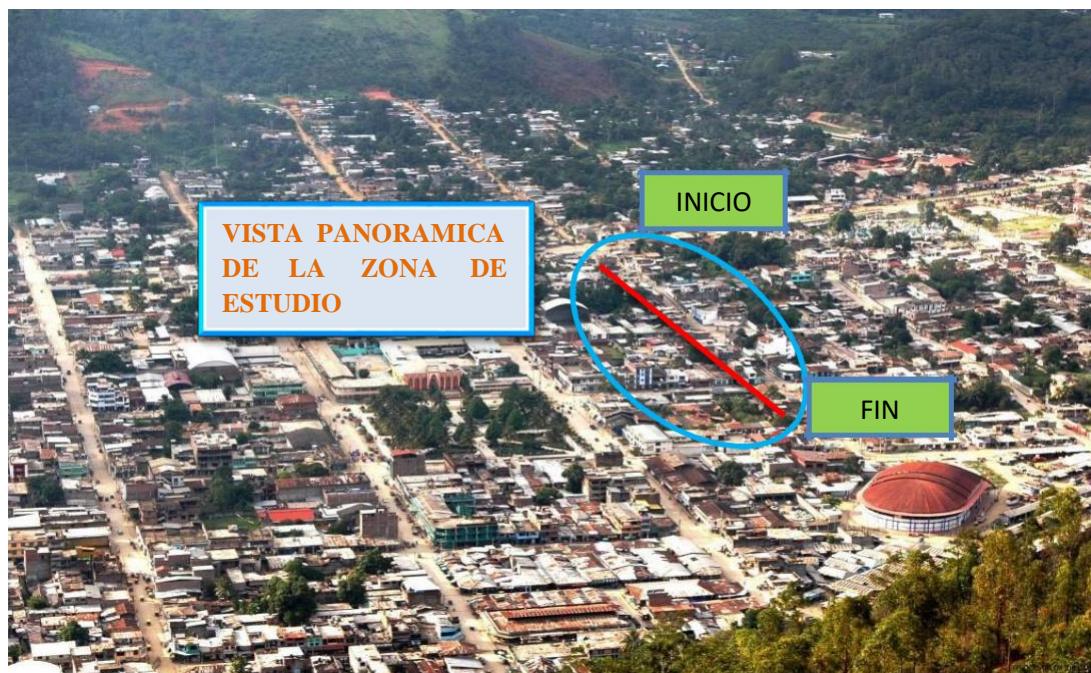
Figura 63. Vista panorámica de la zona de estudio del Jirón Francisco Bolognesi (cuadra 02 – cuadra 04)
