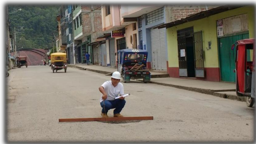
Figura 148. Huecos de severidad alta (U-03)
