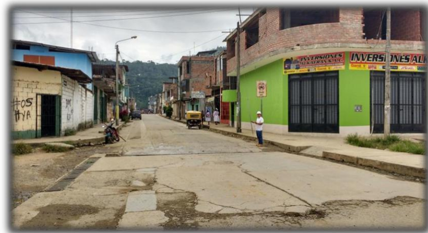
Figura 105. Inicio de inspección de la unidad de muestra U-01
