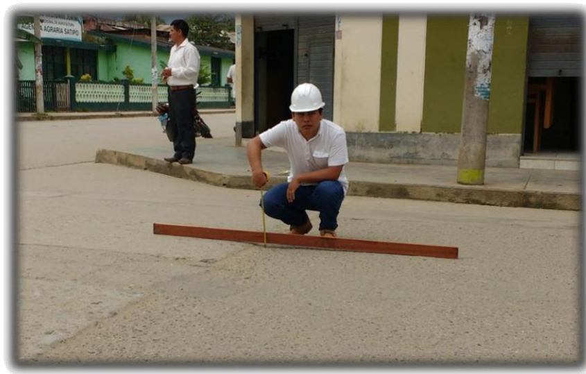
Figura 157. Abultamientos y hundimientos de severidad media (U-03)
