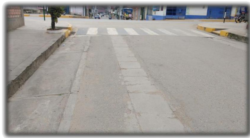
Figura 135. Parches de severidad media (U-01)
