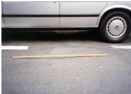
Figura 19. Falla de severidad baja (abultamientos y hundimientos)
