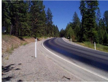
Figura 15. Falla de severidad alta (exudación)
