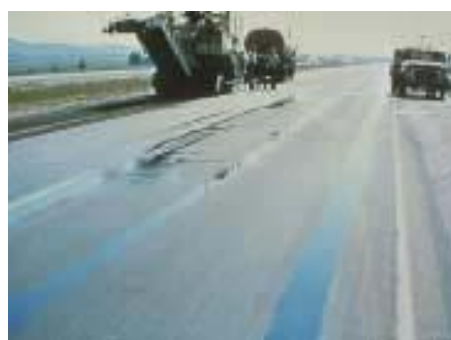
Figura 50. Falla de severidad media (ahuellamiento)
