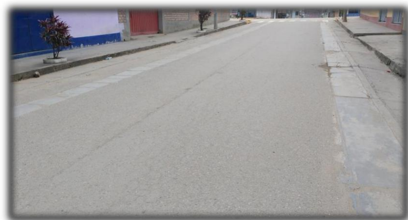
Figura 136. Pulimiento de agregados (U-01)
