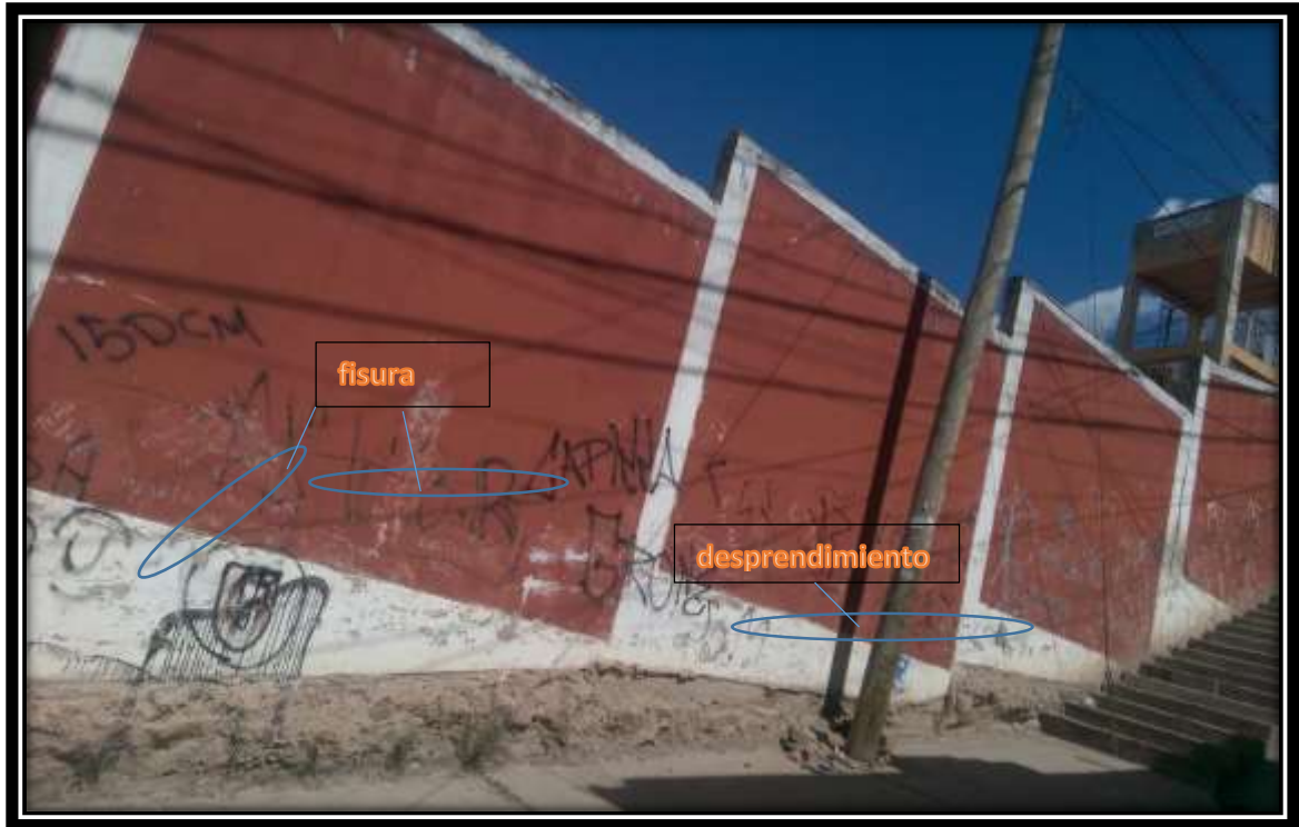
Fotografía 17: Vista panorámica de la unidad de muestra 16
