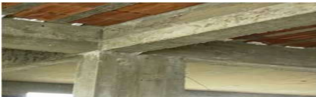
Gráfico 6: Viga peraltada de concreto.
