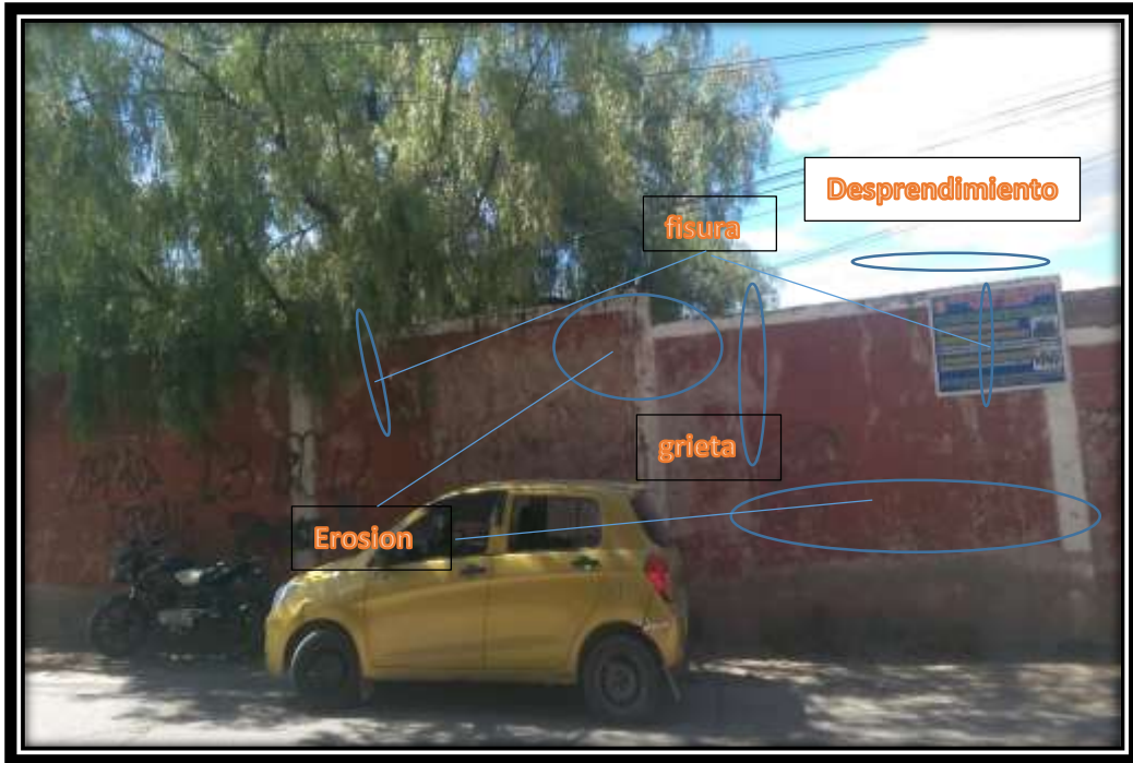
Fotografía 11: Vista panorámica de la unidad de muestra 10
