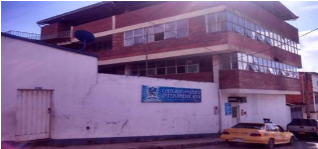
Gráfico 1. Fachada de la Edificación.
