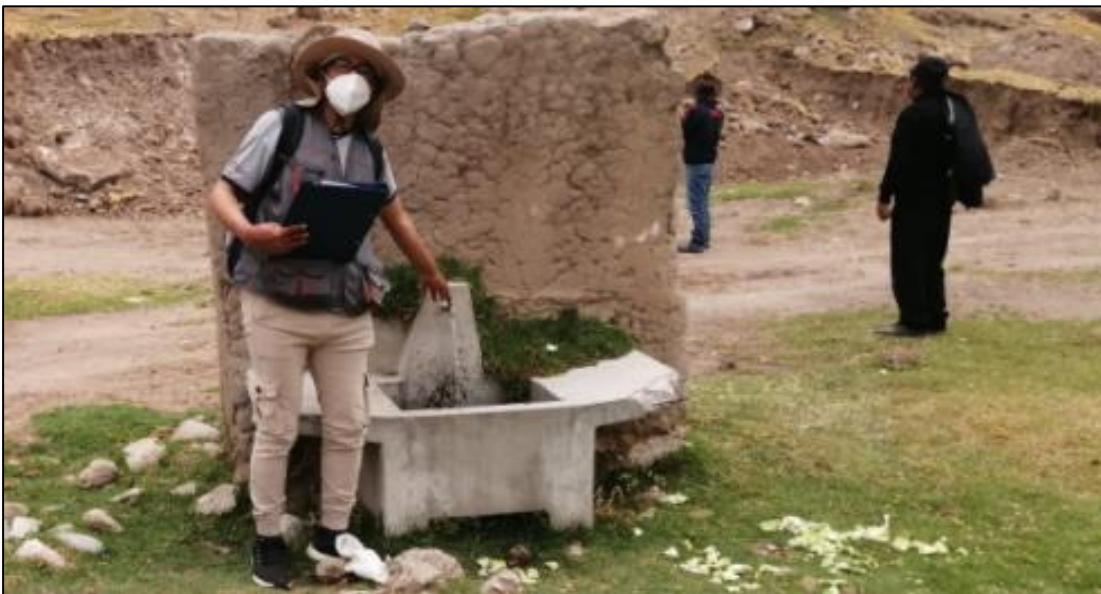
Foto N° 10 situación actual de las conexiones domiciliarias
