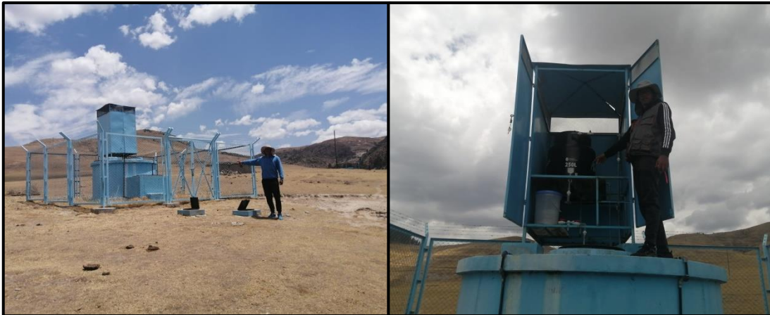
Fotografía N° 05 y 06 situación actual del reservorio de almacenamiento
