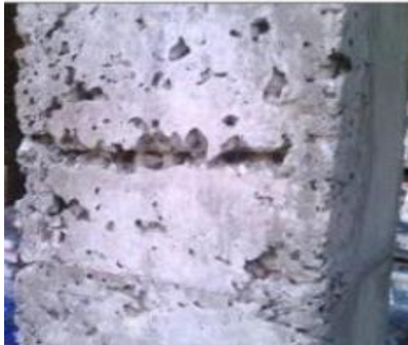
Figura 27 picadura en columna (Muñoz H. 2001) 25
