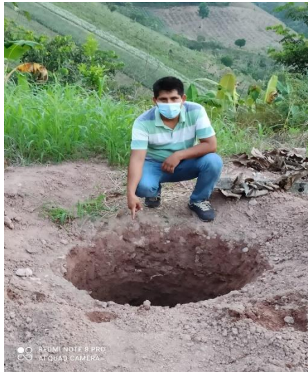
Figura 37. Se muestra la excavación de calicata de 2 m de profundidad.
