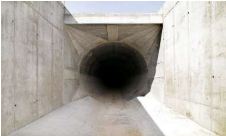
Figura 9: Canal de Sección Circular.
