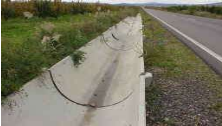
Figura 8: Canal de Sección Parabólica.
