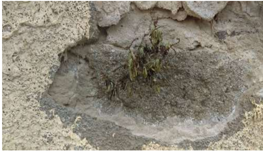
Figura 19: Presencia de Vegetación en el Canal.
