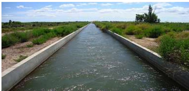
Figura 6: Tramo del Canal Rectangular San Martin.
