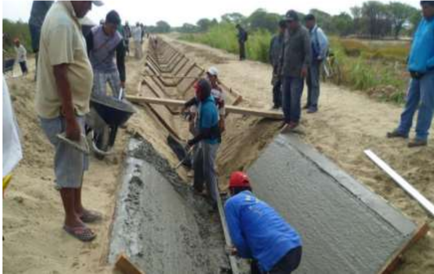
Figura 12: Vaceado de Concreto en Canales.
