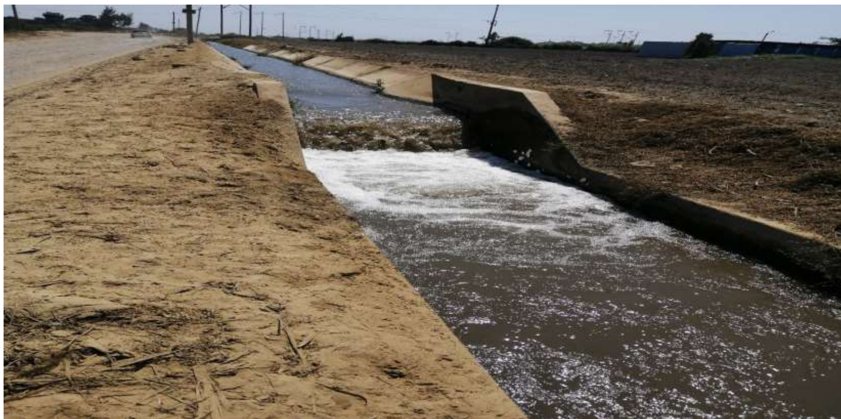
Imagen 1: Canal Monte Chimbote de Cambio Puente, Distrito de Chimbote, provincia del Santa, región Áncash.
