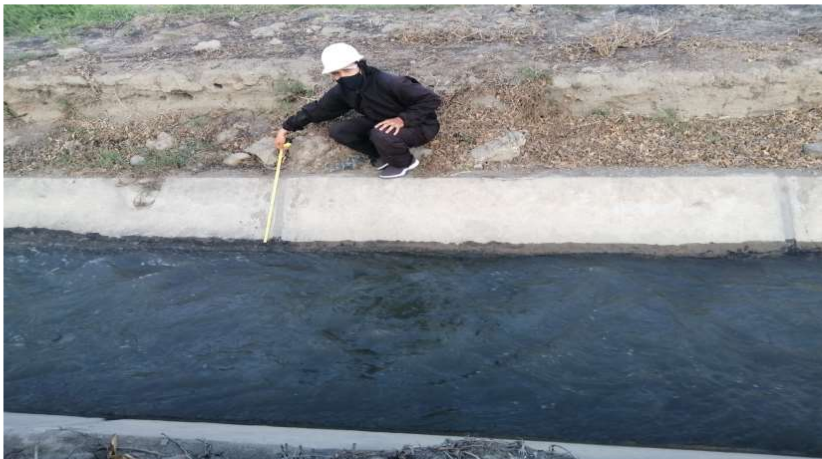
Imagen 3: Presencia de Sello de Junta en el Canal Monte Chimbote de Cambio Puente, Distrito de Chimbote, provincia del Santa, región Áncash.
