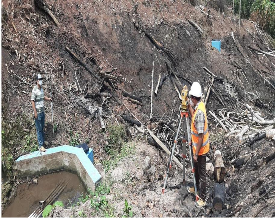
**Foto 9.** Levantamiento topográfico de la captación existente
