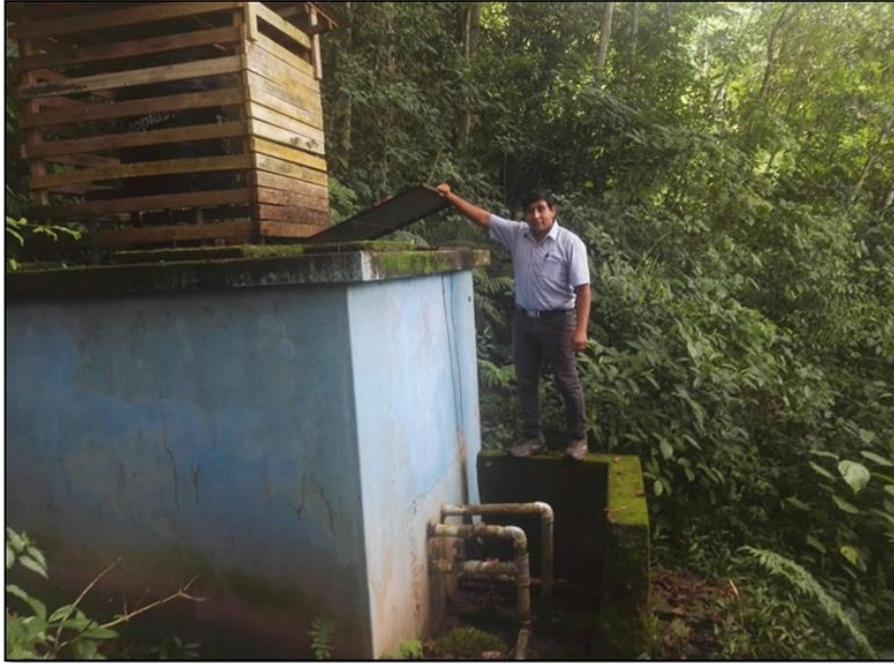
**Foto 15:** Reservorio existente de 15 m<sup>3</sup> con su dosificación de desinfección.
