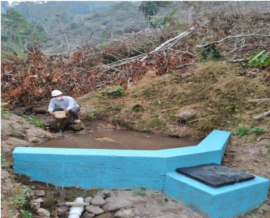
**Foto 4.** Aforo en la captación existente
