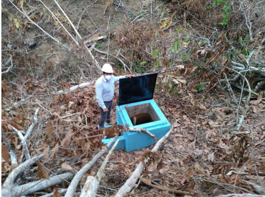
**Foto 5:** Válvula de purga ubicada en el tramo de la línea de conducción
