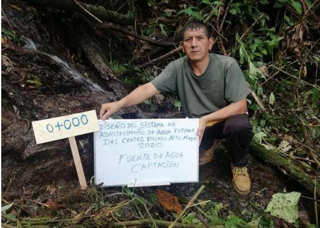
Foto 8: Se aprecia el estaqueado que inicia en a la proyección de la estructura de la captación con la progresiva 0+000
