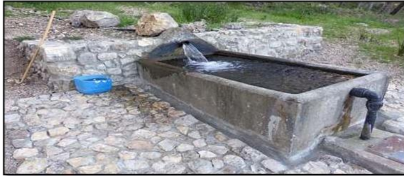
Figura 2: Captación. Fuente: Extraído del PNSR (16)
