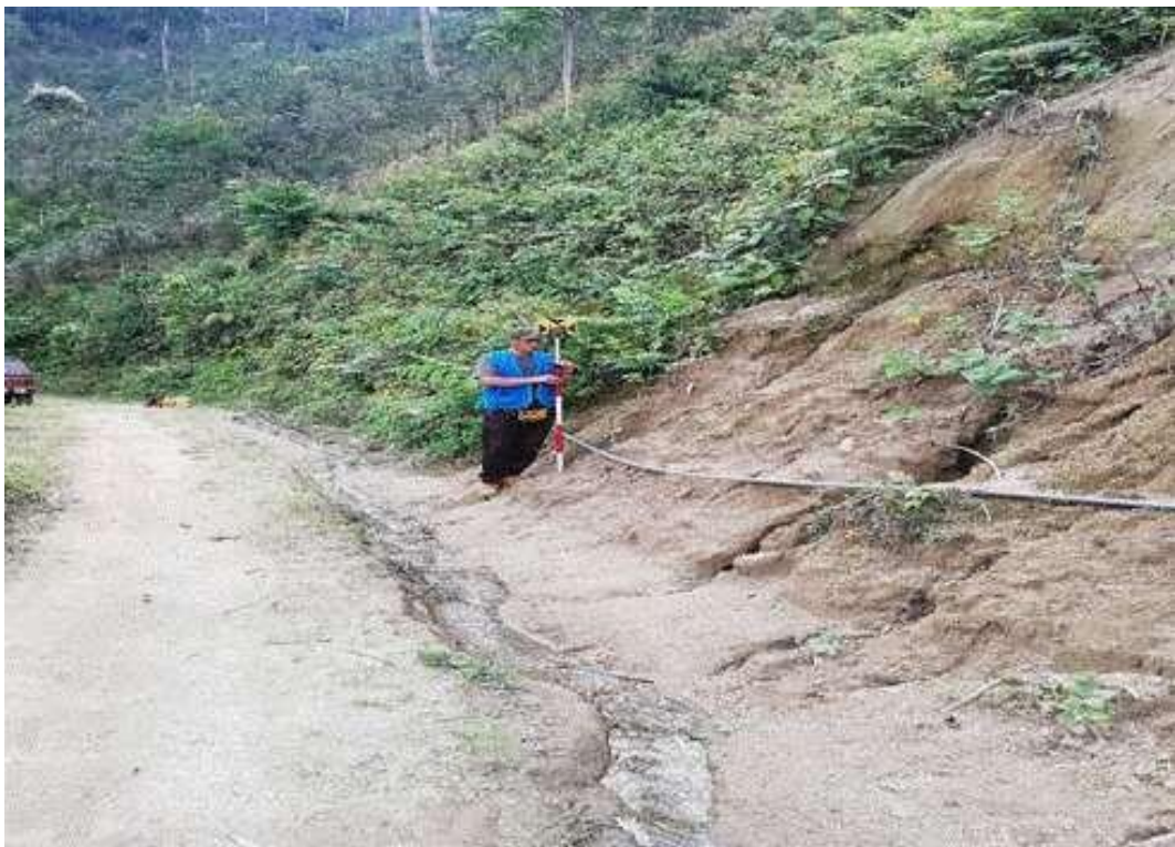
Foto 24: Levantamiento topográfico en la red de distribución
