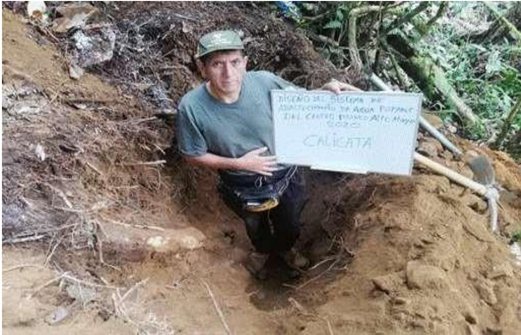
Foto 19: Excavación de Calicata en el lugar donde se realizará el reservorio
