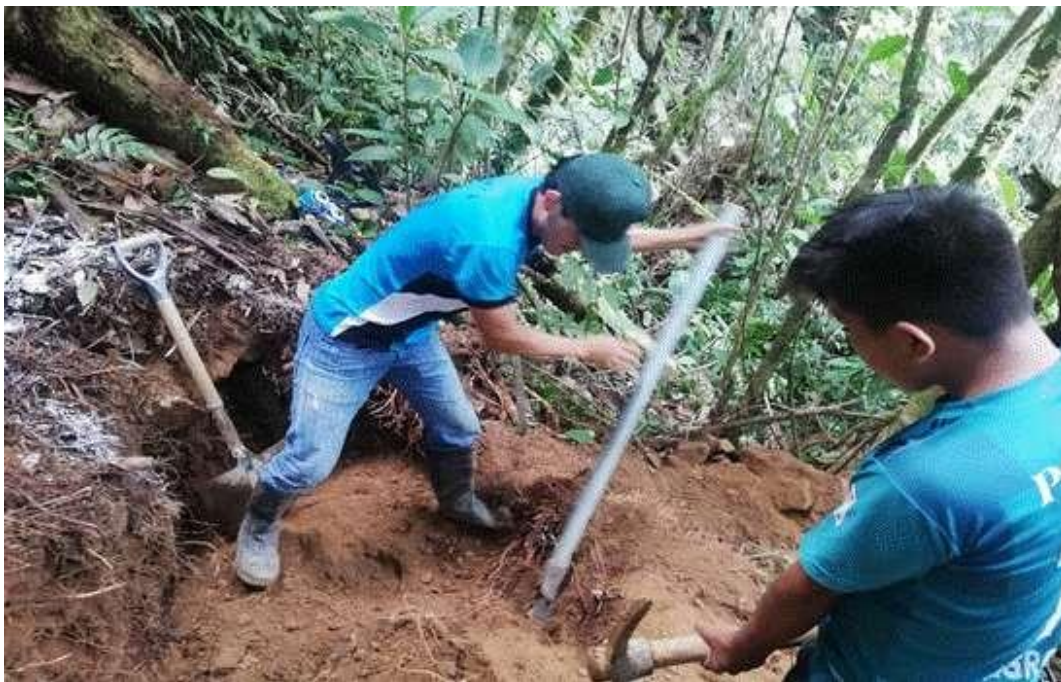
Foto 20: Proceso de excavación de la calicata
