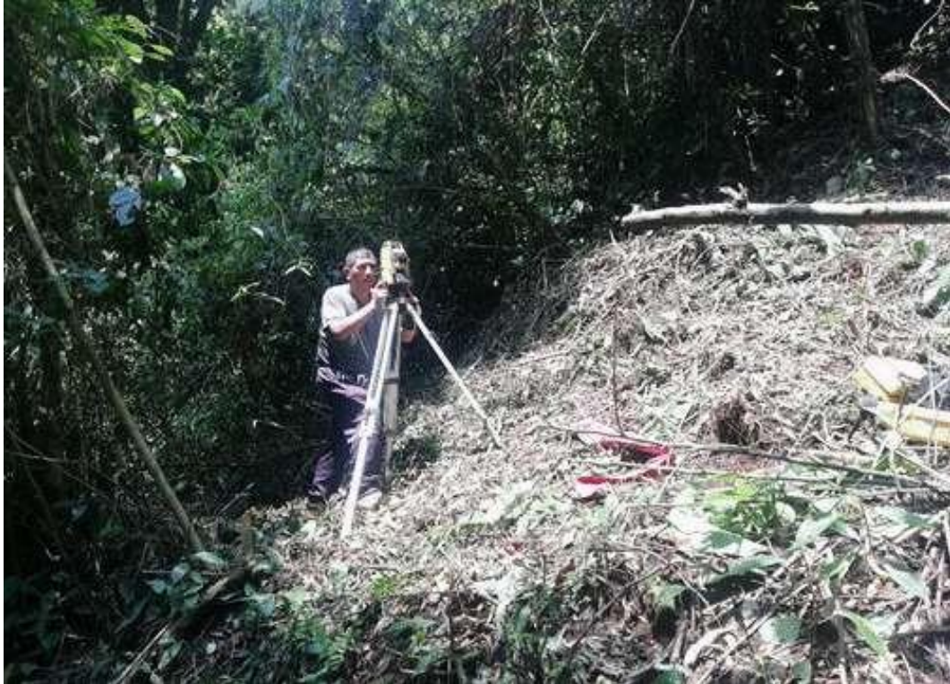
Foto 5: Levantamiento topográfico en la línea de aducción
