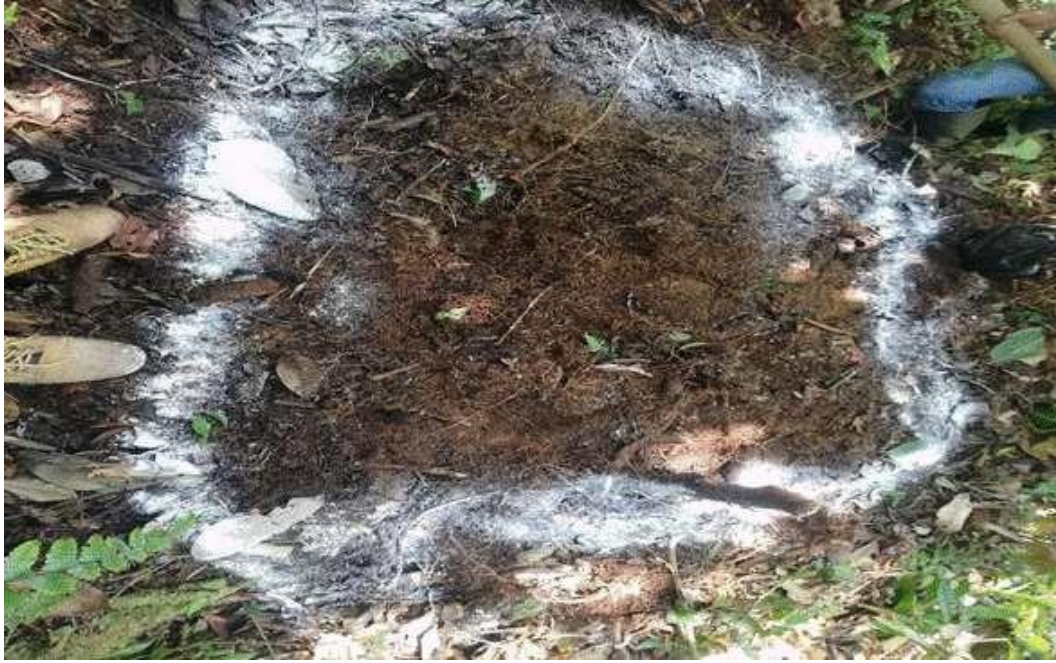
Foto 23: Trazo del área de excavación para la calicata
