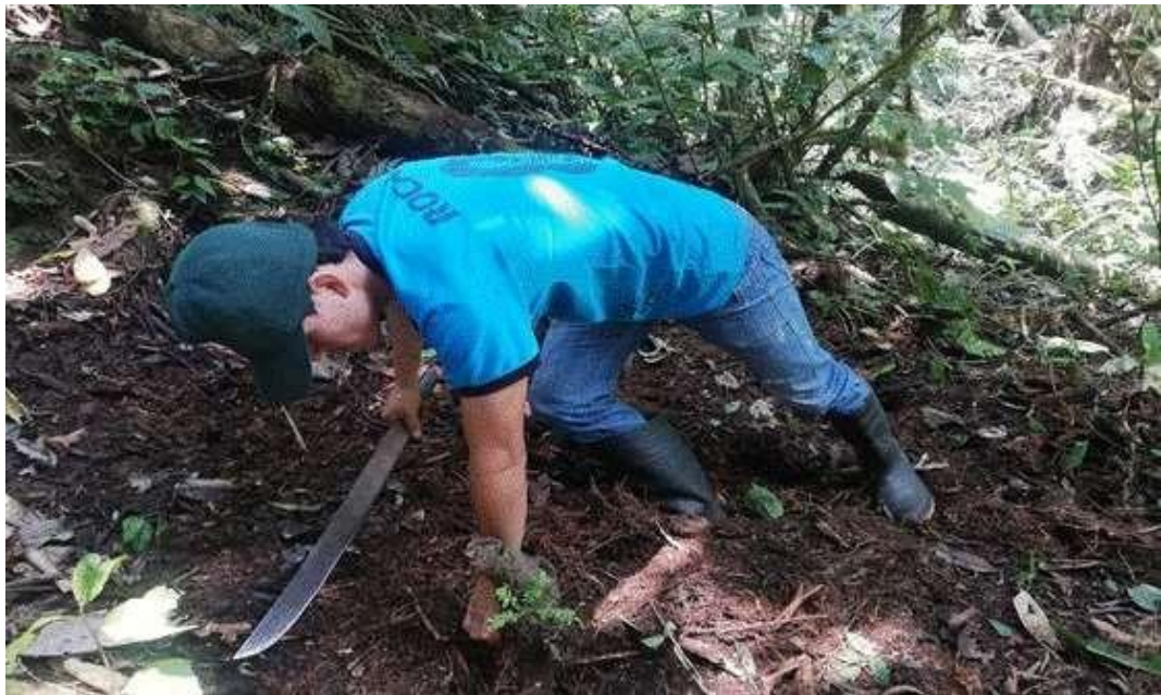
Foto 22: Limpieza de trayecto de la línea de conducción
