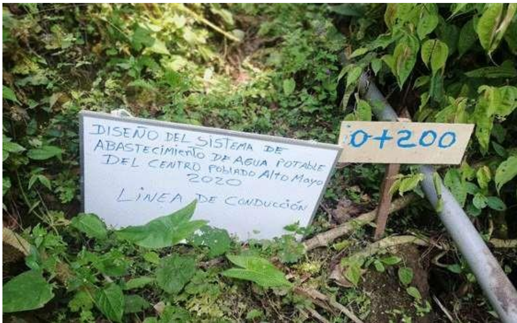
Foto 8: Se visualiza el estaqueado en línea de conducción
