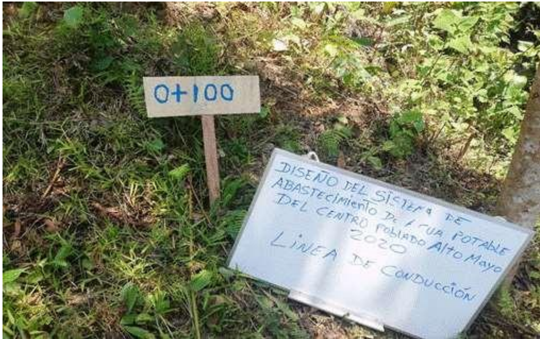
Foto 16: Se aprecia el estaqueado en la línea de conducción de la progresiva 0+100
