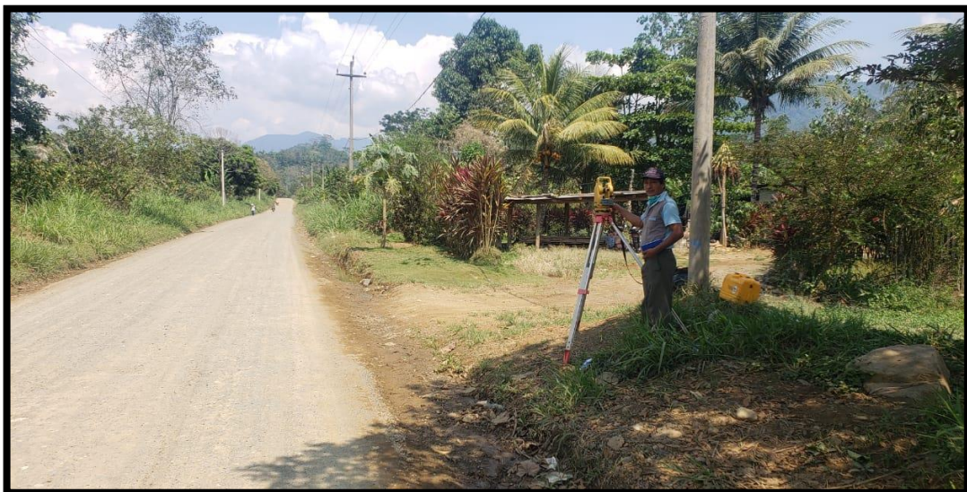
Figura 35: Levantamiento topografico de la red de distribución.
