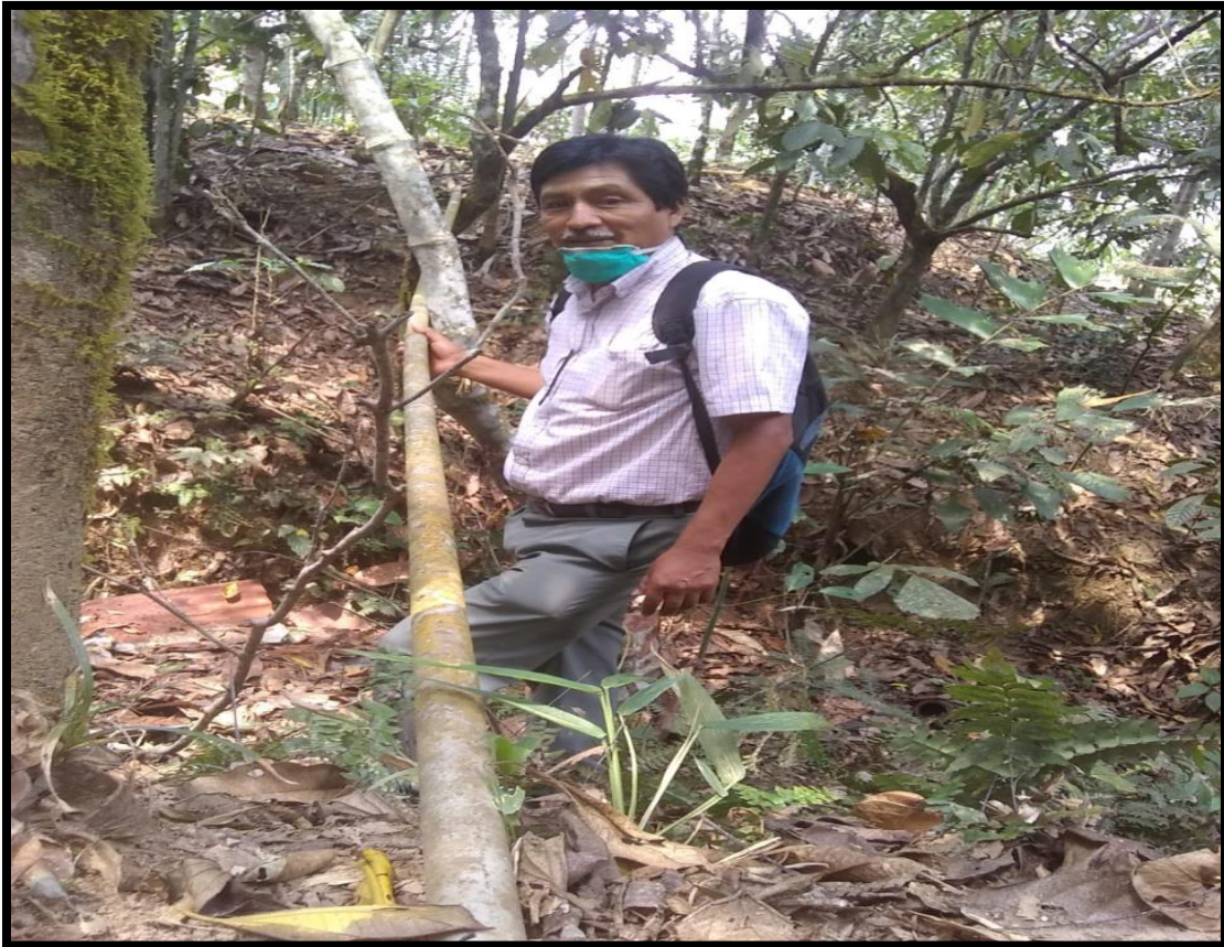
Figura 30: Estado de la línea de conducción.
