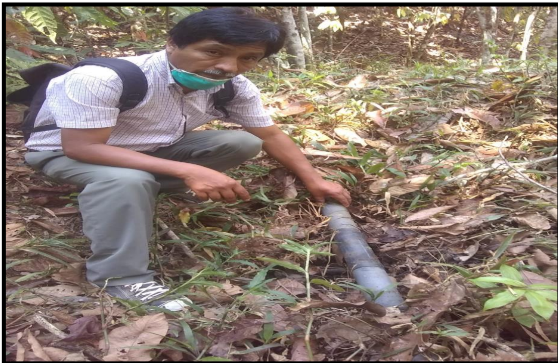
Figura 31: Estado de la línea de aducción.
