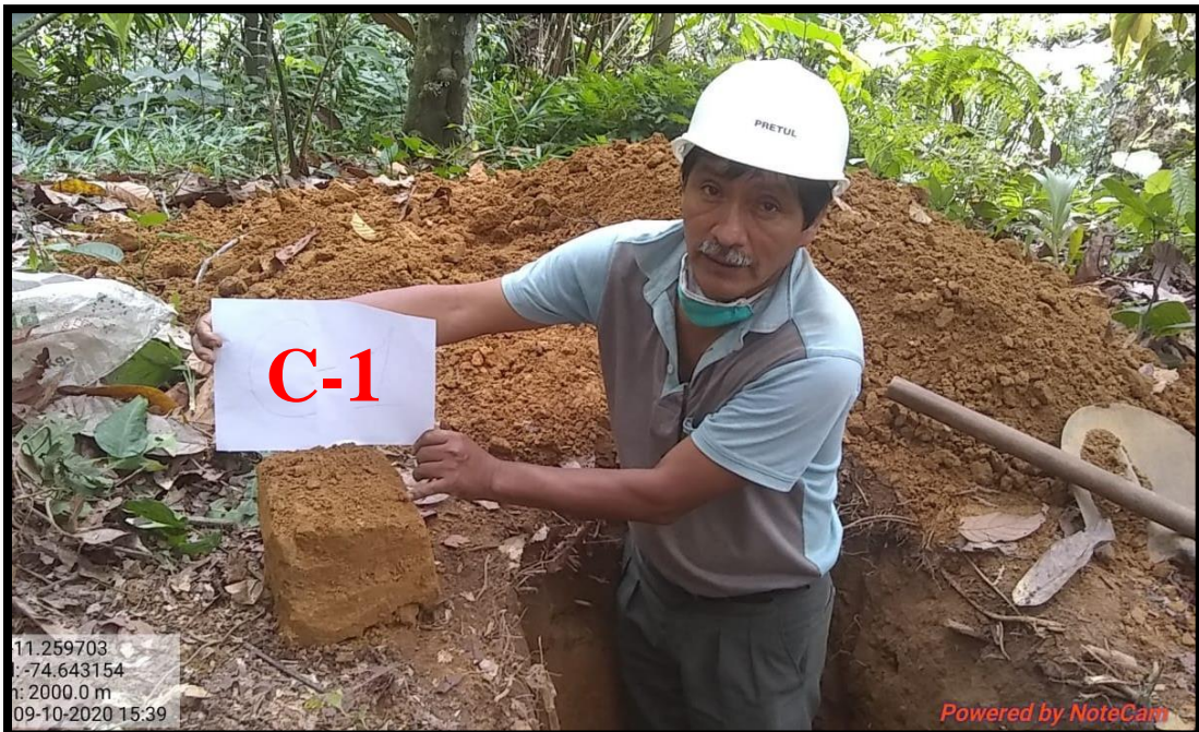
Figura 27: Calicata N° 1 para estructura del reservorio.
