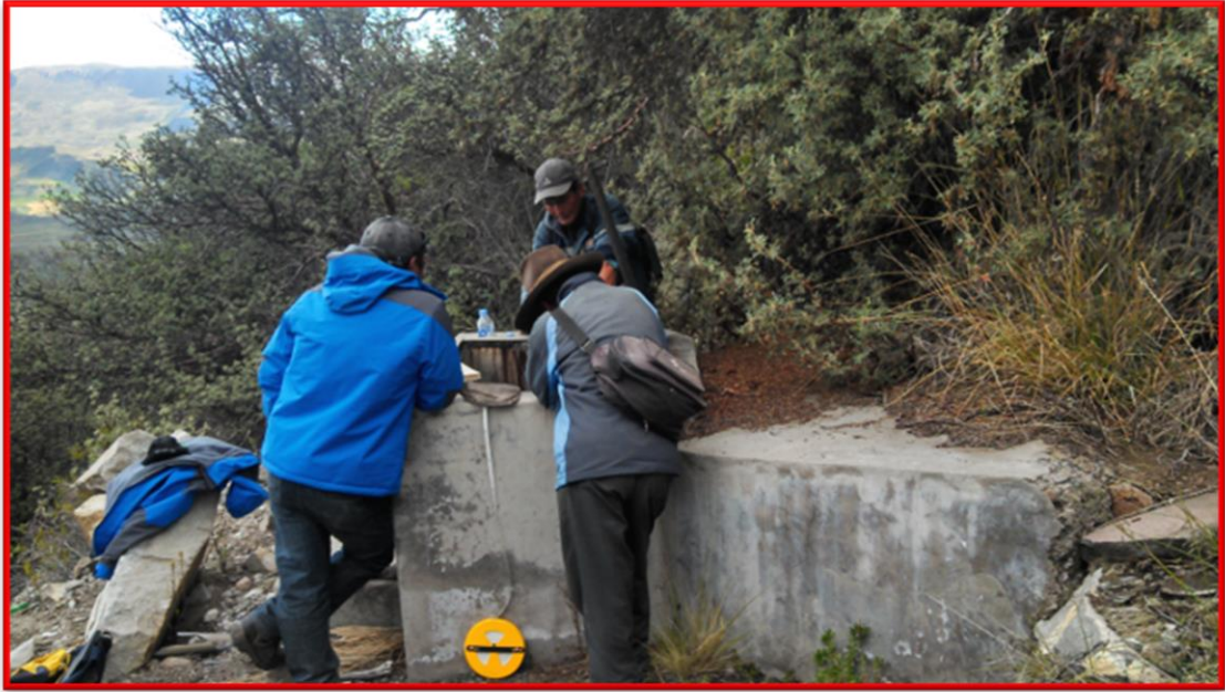
Fotografía 01: Se observa los pobladores del anexo en la captación.
